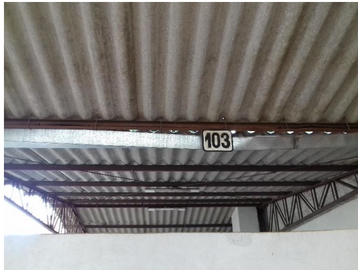
Foto 7: Calha com torção em sua extensão Fonte: Autoria própria,2016
