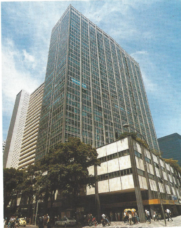
Figura 2 - Edifício Avenida Central, no Rio de Janeiro, construído em 1961
