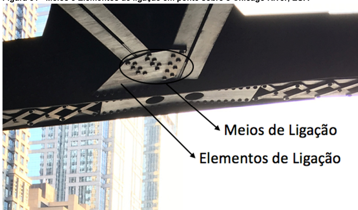
Figura 31 - Meios e Elementos de ligação em ponte sobre o Chicago River, EUA
