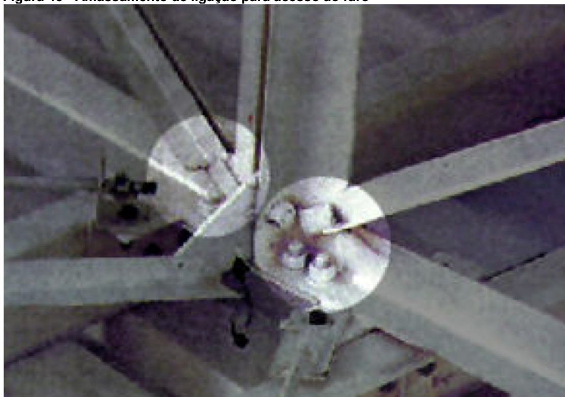
Figura 45 - Amassamento de ligação para acesso ao furo
