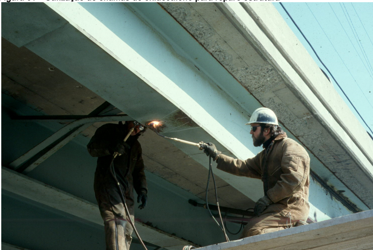
Figura 61 – Utilização de chamas de oxiacetileno para reparo estrutura
