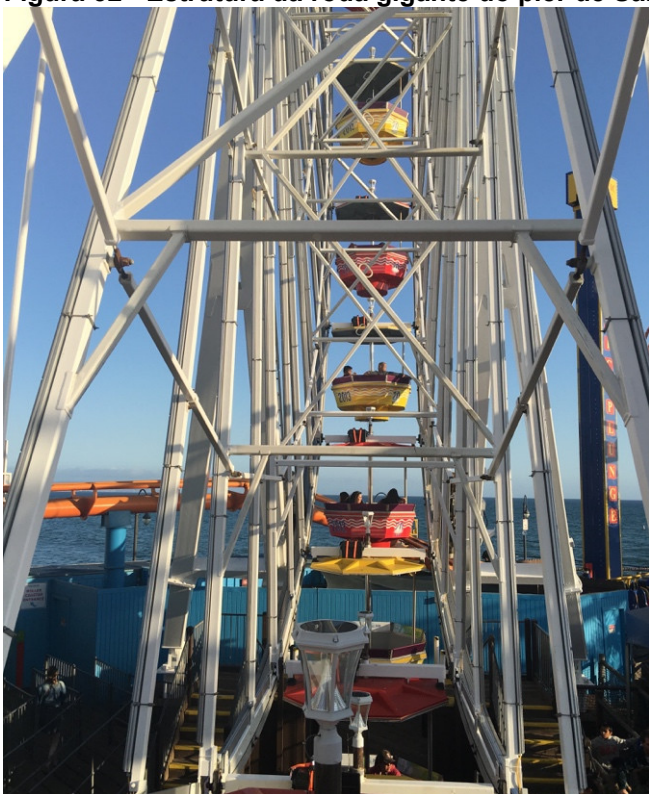
Figura 32 - Estrutura da roda gigante do pier de Santa Mônica, na Califórnia
