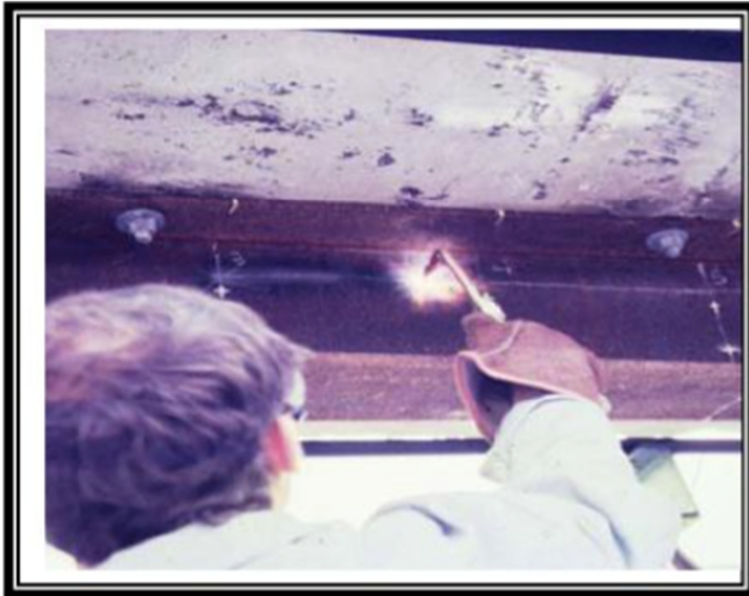
Figura 67 – Execução de aquecimento retangular
