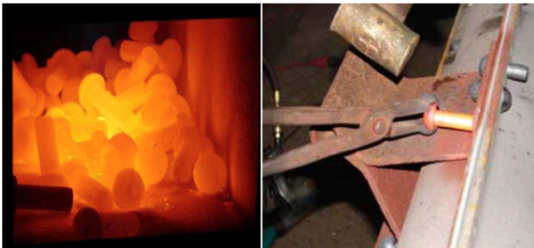
Figura 69 - Aquecimento de rebites e locação de suas hastes na estrutura
