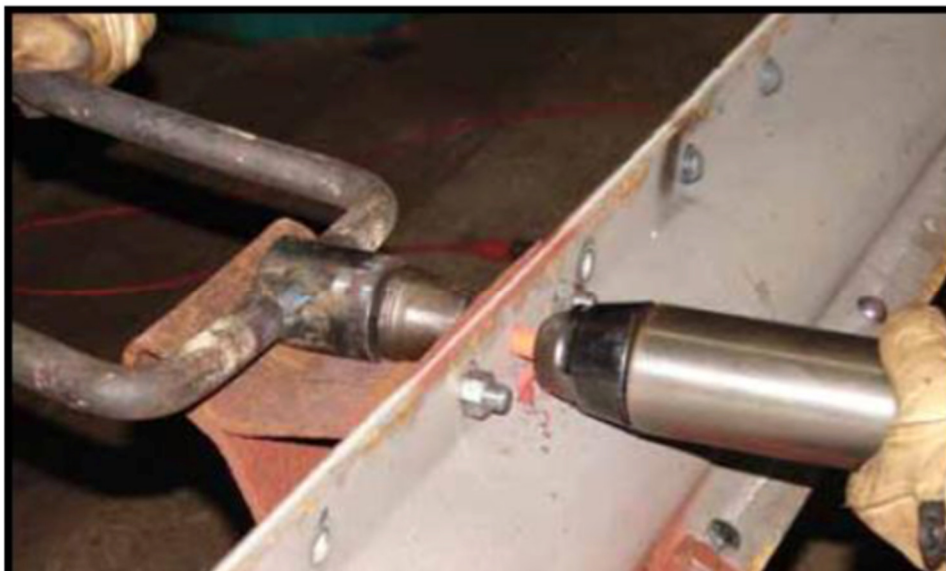
Figura 70 - Pressão exercida sobre o rebite para modelá-lo ao local de ligação
