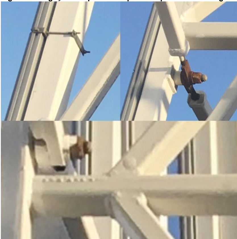
Figura 33 - Ligações responsáveis pelo comportamento e segurança estrutural da roda gigante
