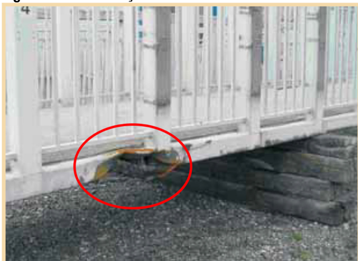
Figura 58 - Substituição de elementos estruturais corroídos
