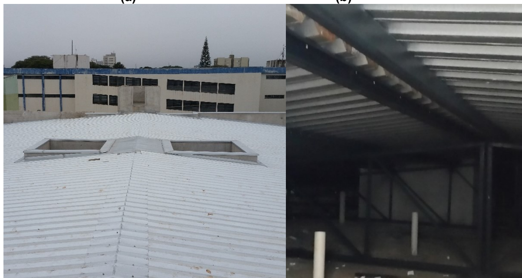
Figura 3 – Superfícies metálicas da cobertura A: a) face superior e b) face inferior.
