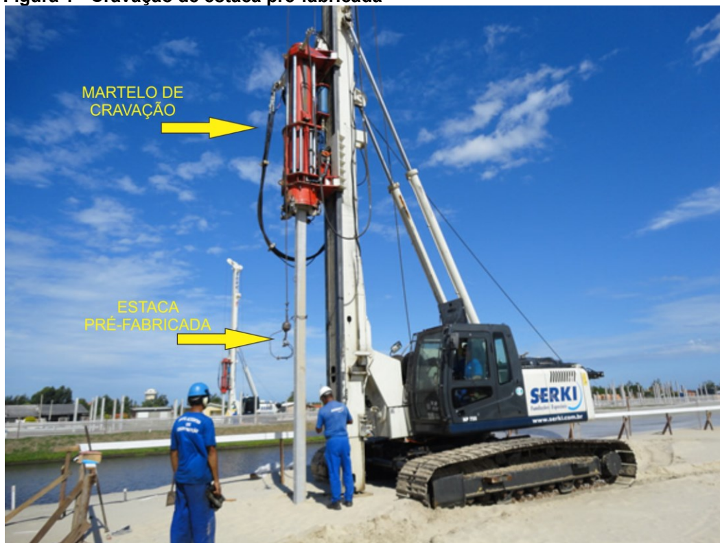
Figura 1 - Cravação de estaca pré-fabricada
