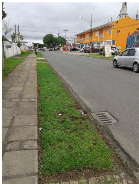
Figura 16 - Sinalização horizontal inadequada Fonte: Autoria própria.
