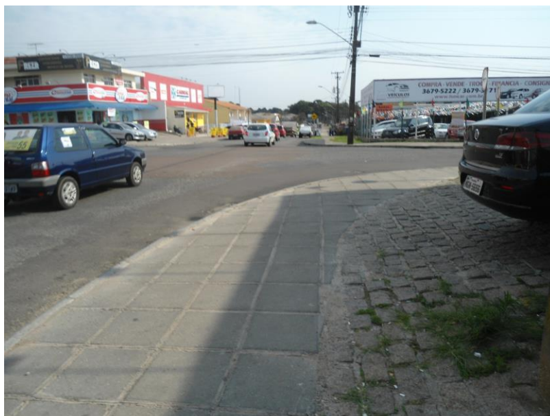
Figura 25 - Trecho da via onde há o conflito do tráfego com os veículos estacionados Fonte: Autoria própria.
