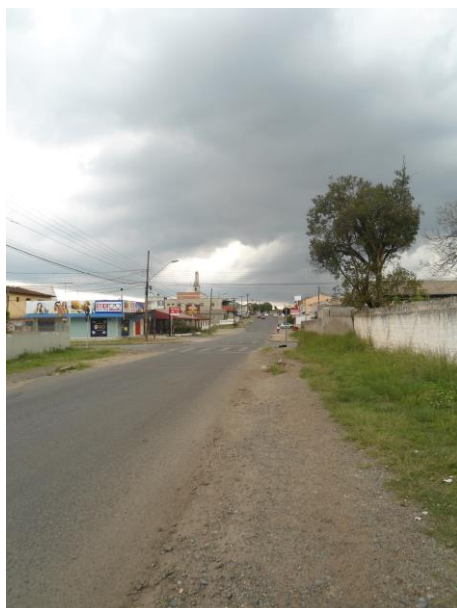
Figura 19 - Segundo trecho da via com infraestrutura precária Fonte: Autoria própria.
