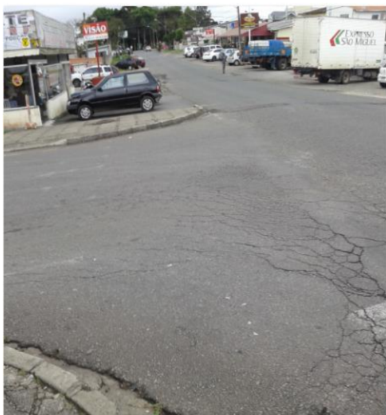
Figura 23 - Conflito no espaço destinado a pedestres e estacionamentos Fonte: Autoria própria
