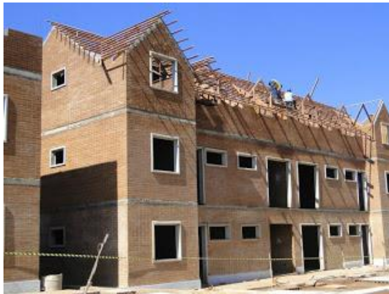
Figura 5 - Construção com BTC em andamento.
