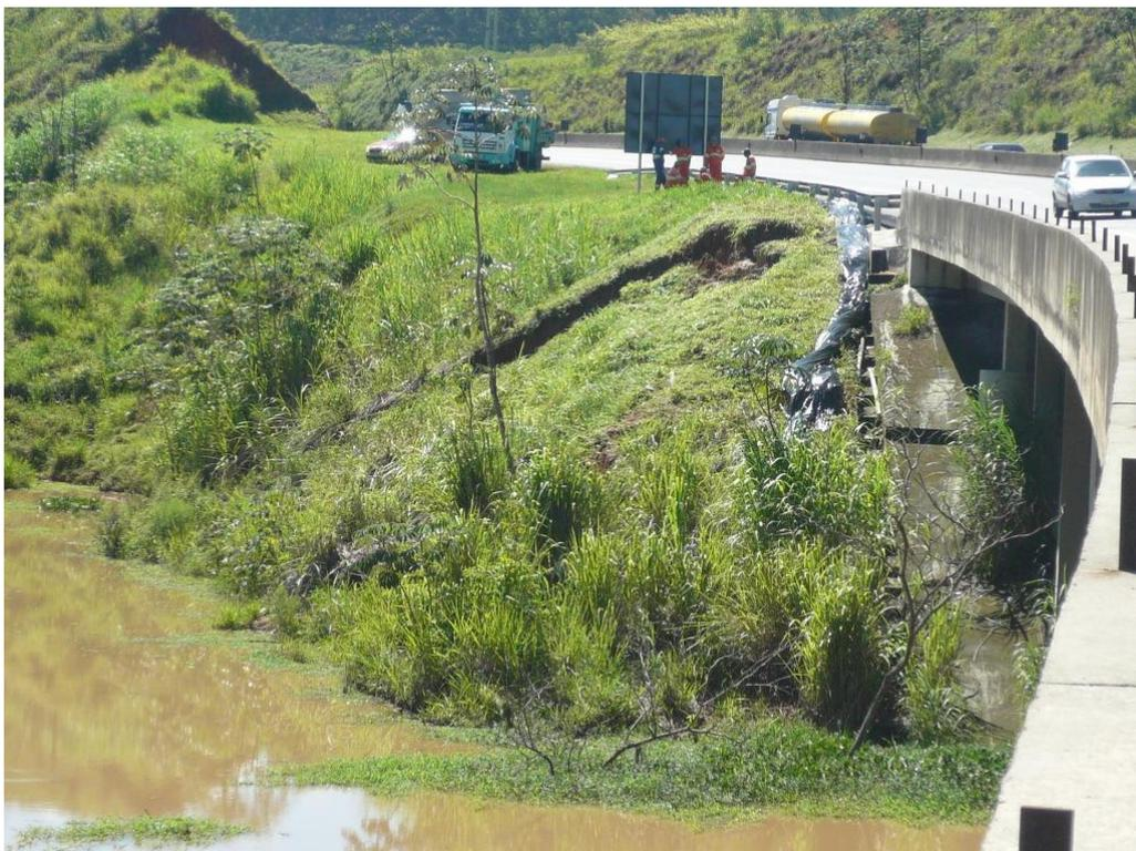
**Figura 22: Ruptura do Talude.**
