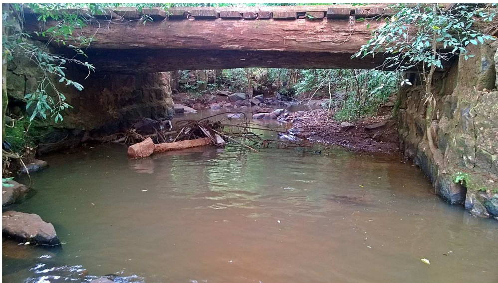
Fotografia 2 – Vista lateral da estrutura Fonte: O autor (2015).
