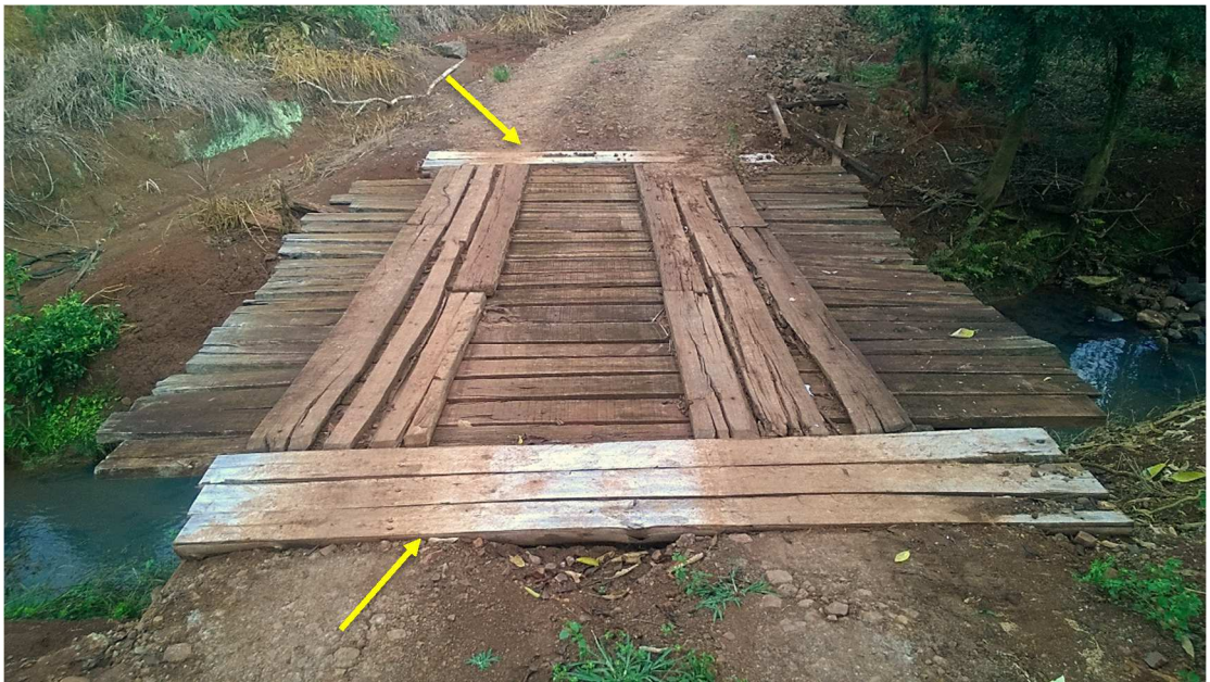
Fotografia 30 – Manutenção corretiva, substituição de pranchas do tabuleiro Fonte: O autor (2015).
