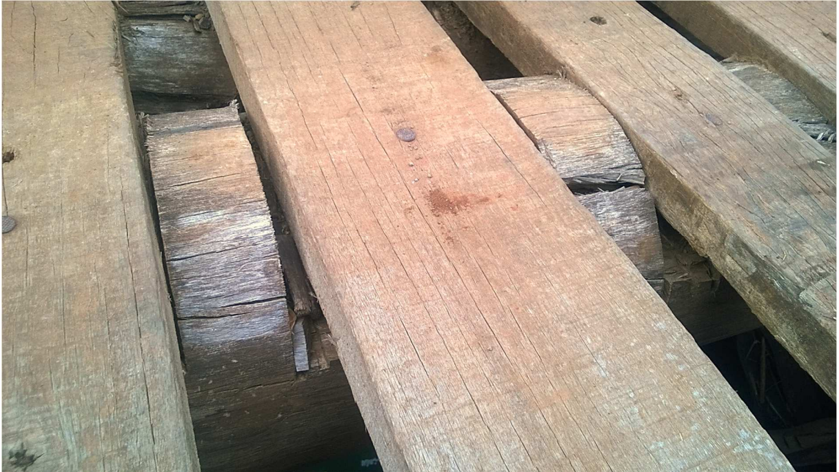
Fotografia 33 – Remoção de madeira das vigas (entalhes) Fonte: O autor (2015).
