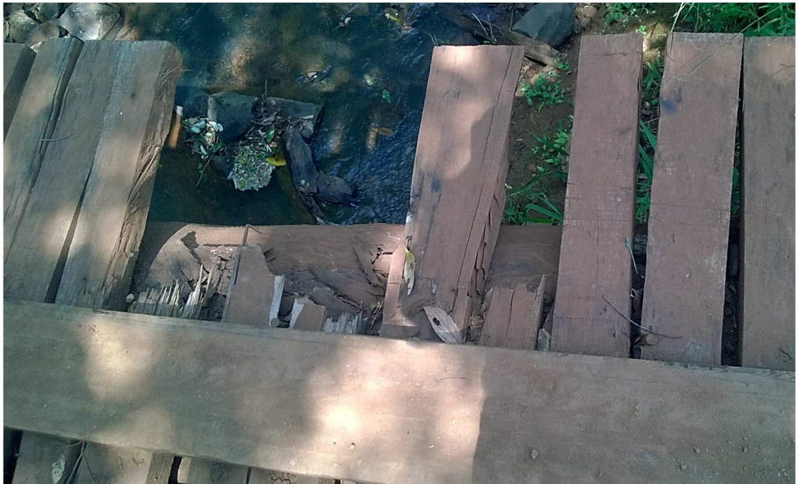
Fotografia 26 – Pranchas quebradas (extremidades em balanço) Fonte: O autor (2015).
