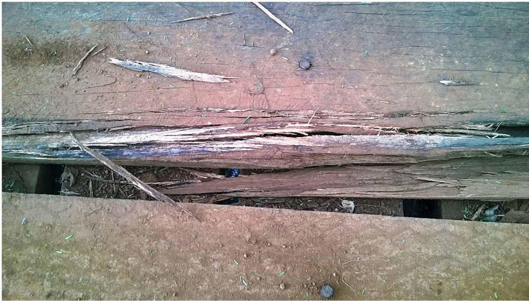
Fotografia 3 – Abrasão mecânica em prancha do rodeiro Fonte: O autor (2015).
