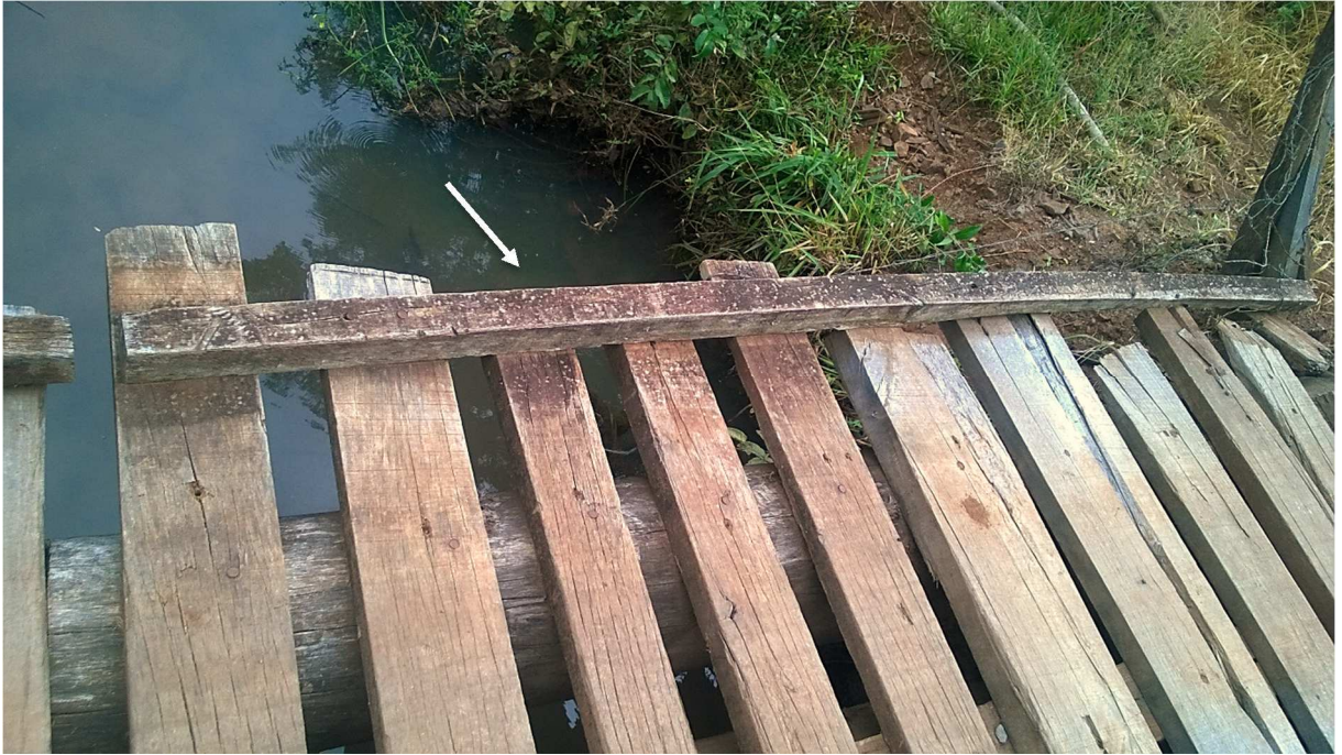
Fotografia 31 – Guarda-rodas ineficiente Fonte: O autor (2015).
