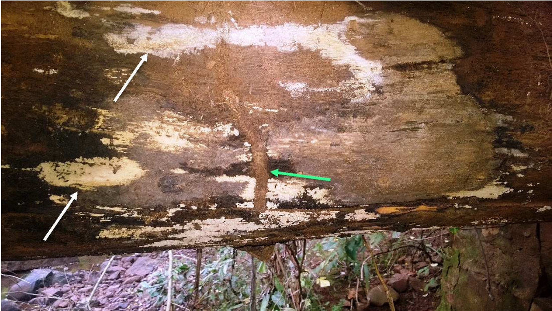
Fotografia 13 – Presença de hifas de fungos e caminho de cupins de solo Fonte: O autor (2015).
