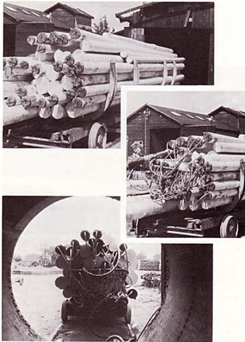
Figura 27 – Execução do Processo Gewecke Fonte: Moreschi (2013).
