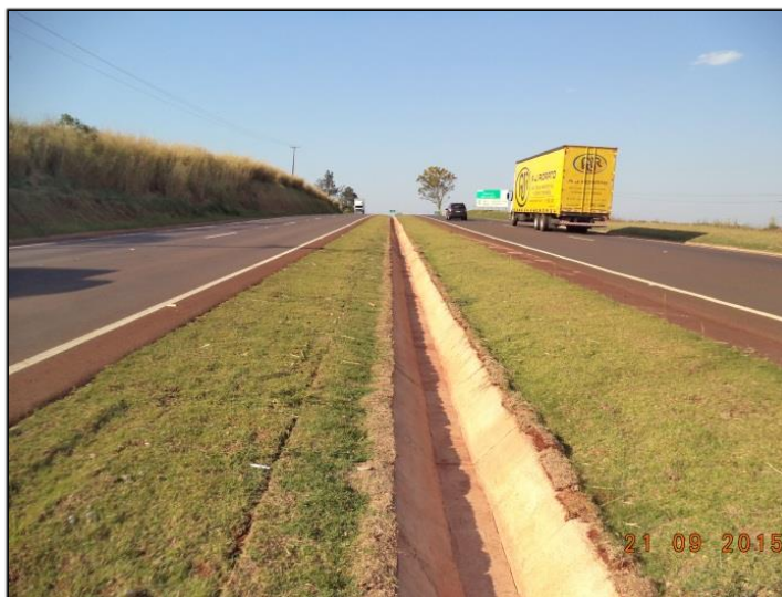
Figura 13: Sarjetas de canteiro central de concreto Fonte: elaboração própria tirada em 21/09/2015
