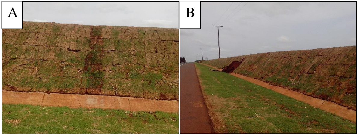
Figura 26: (A) (B) Aplicação de placas em leivas Fonte: Elaboração própria
