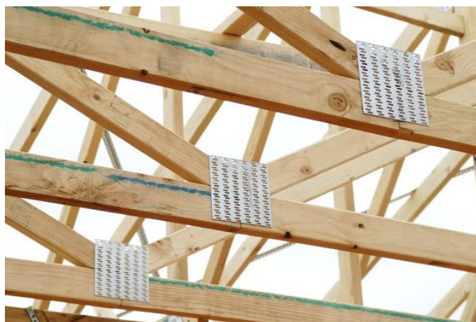
Figura 5 - Ligações com chapas de dente estampados Fonte: Roof truss (2016)
