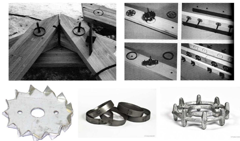
Figura 4 – Ligações com anéis metálicos Fonte: Dias (2014).
