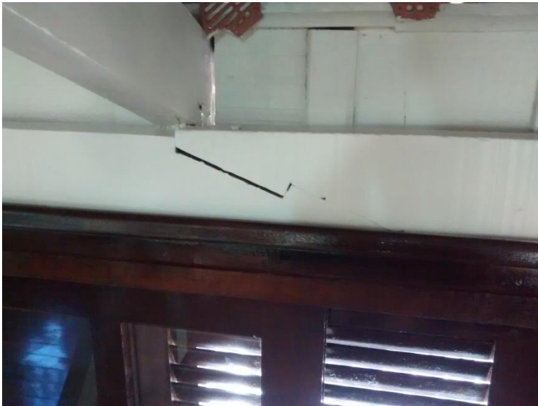
Figura 48: Entalhe do apoio. Fonte: O Autor
