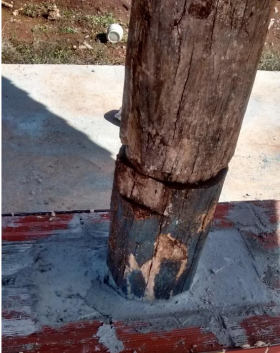
Figura 40: Tora de madeira reaproveitada. Fonte: O Autor
