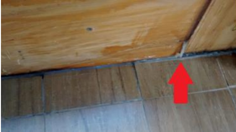
Figura 17: Rodapé interno e base de pilar em madeira de demolição. Fonte: O Autor
