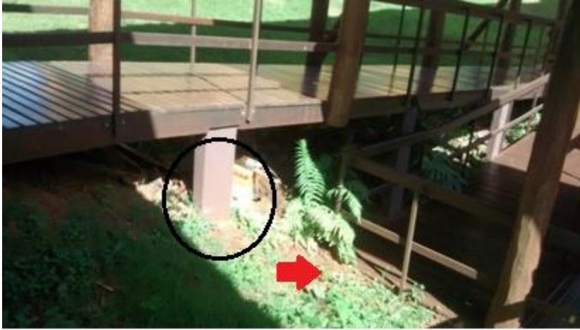
Figura 44: Apoios da passarela. Fonte: O Autor
