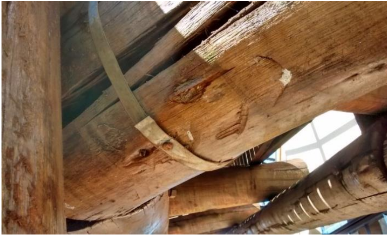
Figura 37: Peça de madeira com anel metálico. Fonte: O Autor
