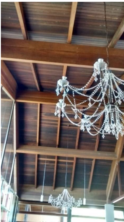
Figura 45: Cobertura interna em madeira. Fonte: O Autor
