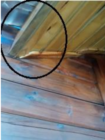
Figura 24: Forro da cobertura externa. Fonte: O Autor
