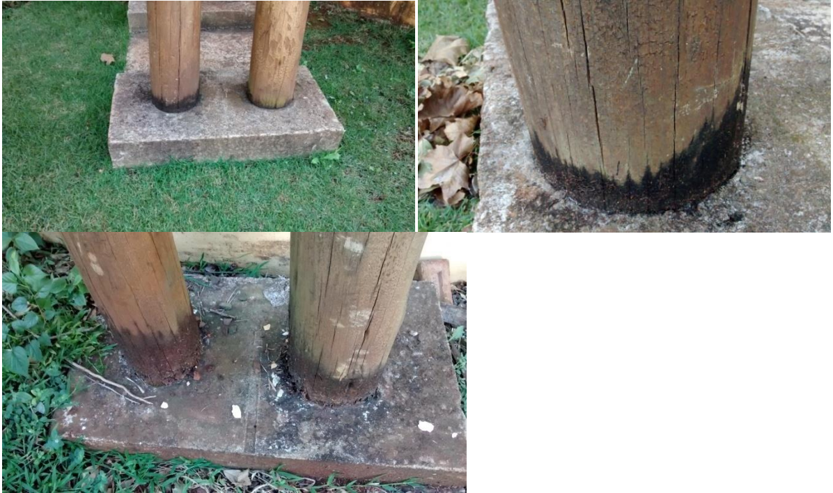
Figura 32: Pilares de madeira com base de concreto. Fonte: O Autor
