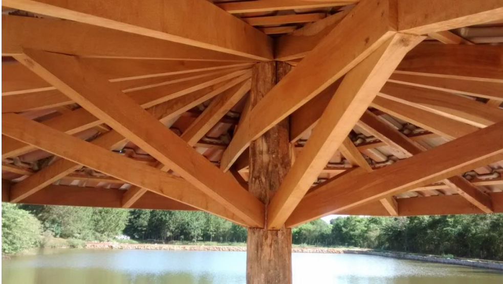
Figura 41: Estrutura da cobertura de um quiosque. Fonte: O Autor
