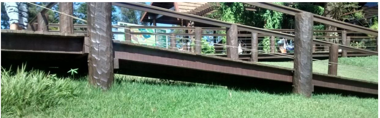
Figura 38: Rampa de acesso feita em madeira. Fonte: O Autor
