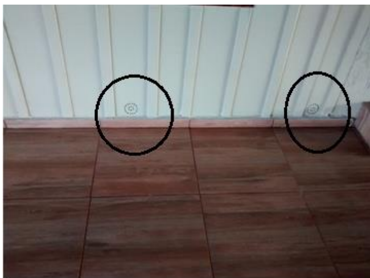
Figura 53: Detalhe construtivo na parte inferior da parede. Fonte: O Autor
