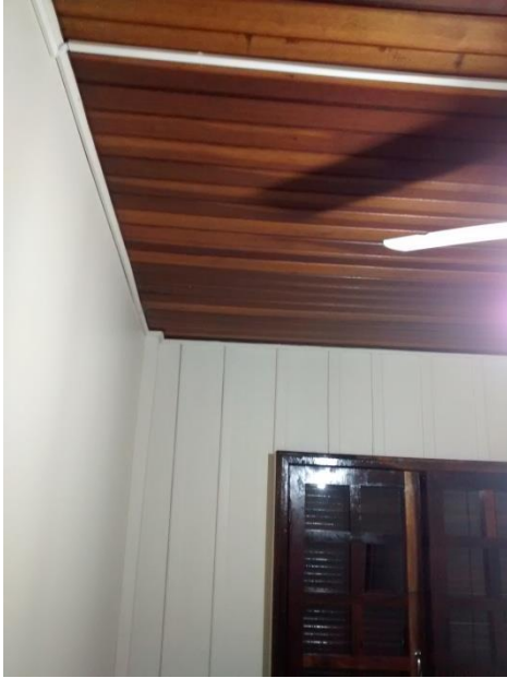
Figura 49: Interior da residência em madeira. Fonte: O Autor
