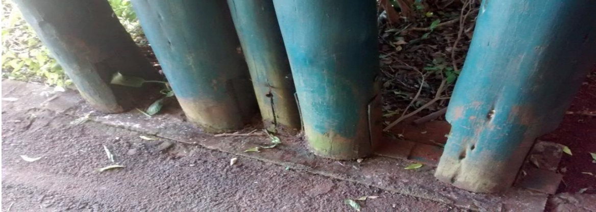
Figura 29: Pilares em madeira roliça em ambiente úmido. Fonte: O Autor
