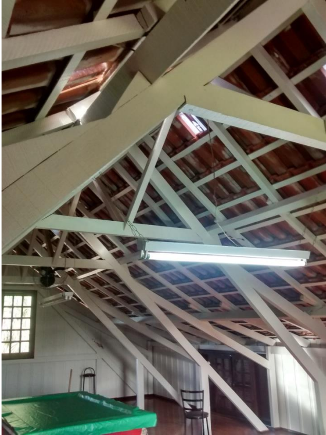
Figura 46: Cobertura interna do sobrado. Fonte: O Autor
