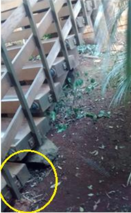
Figura 43: Detalhe lateral da escada. Fonte: O Autor
