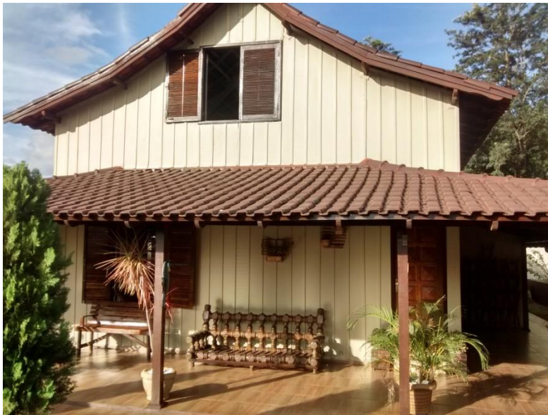
Figura 51: Fachada frontal de residência em madeira. Fonte: O Autor
