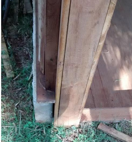
Figura 18: Detalhe do contato das peças de madeira com o solo. Fonte: O Autor
