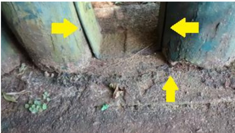
Figura 27: Detalhe das chapas metálicas. Fonte: O Autor
