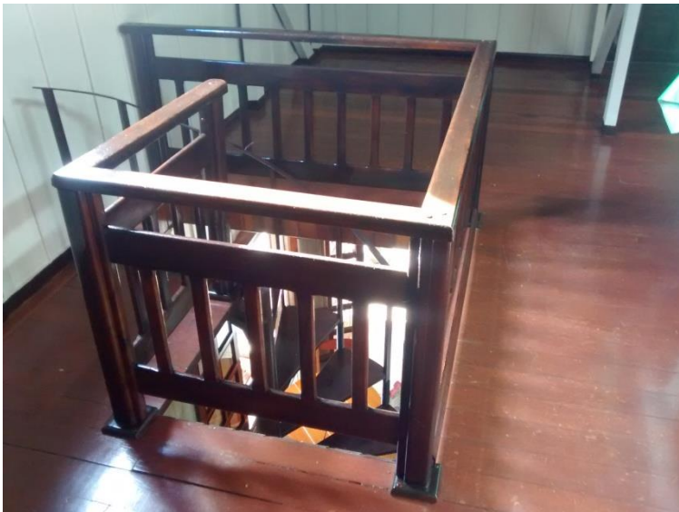
Figura 47: Guarda-corpo e piso de madeira. Fonte: O Autor
