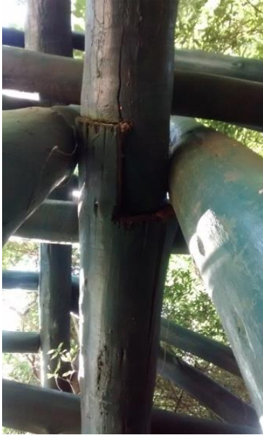
Figura 30: Detalhe da união de duas peças de madeira roliça. Fonte: O Autor
