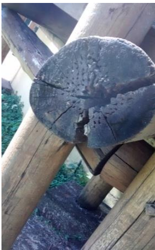
Figura 34: Fenda em peça de madeira roliça. Fonte: O Autor
