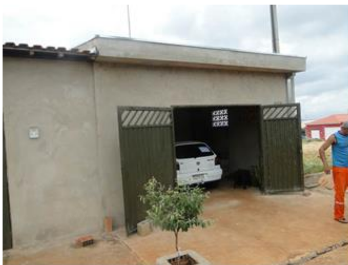
Figura 20 - Fachada do imóvel. Fonte: Autoria própria, 2015.
