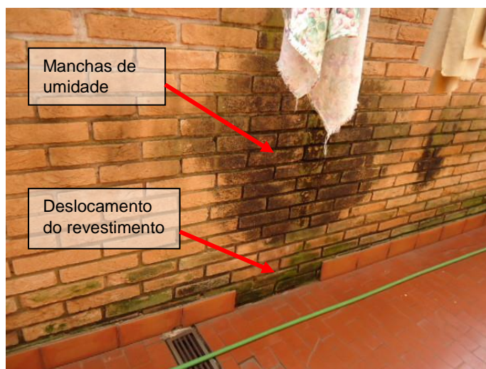
Figura 18 - Vista do muro de divisa com o vizinho. Fonte: Aatoria própria, 2015.
