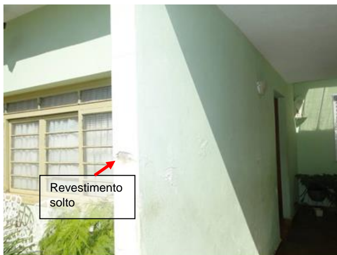
Figura 30 - Vista frontal da garagem. Fonte: Autoria própria, 2015.
