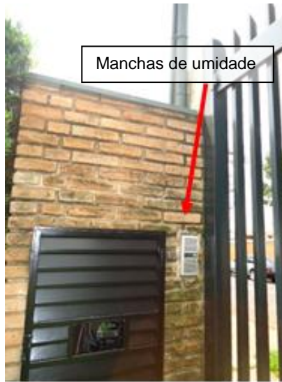
Figura 7 A: Muro de divisa com o vizinho. Fonte: Autoria própria, 2015.
