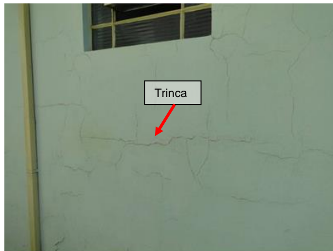
Figura 15 D: Vista de parede externa dos fundos. Fonte: Autoria própria, 2015.
