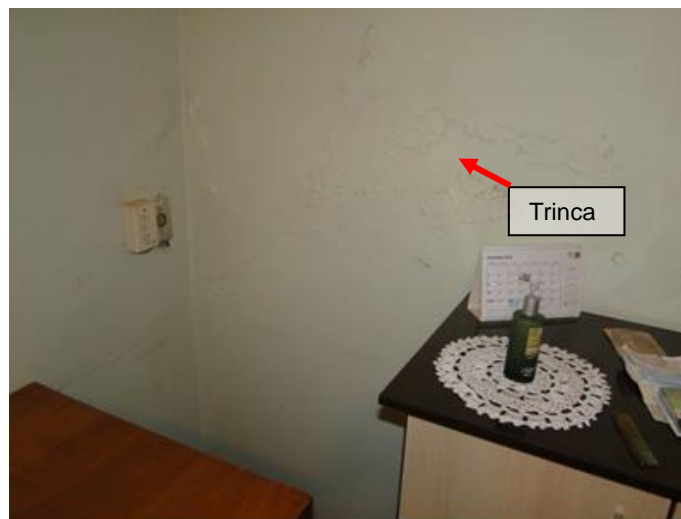
Figura 6 D: Vista da parede do quarto 1. Fonte: Autoria própria, 2015.
