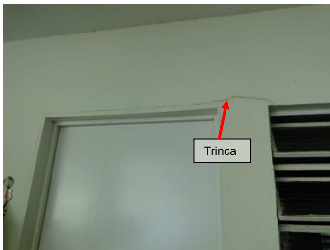
Figura 34 - Vista de porta para acesso aos fundos. Fonte: Autoria própria, 2015.
