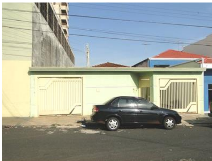
Figura 29 - Fachada do imóvel. Fonte: Autoria própria, 2015.
