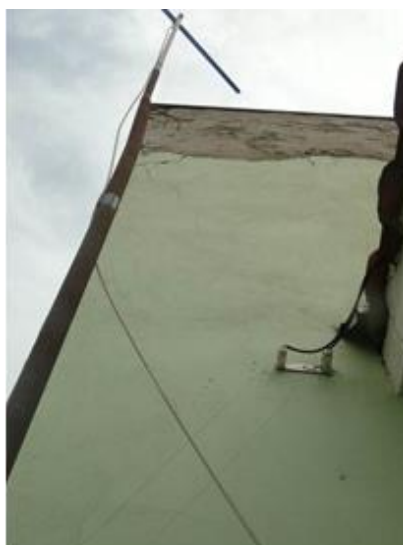
Figura 4 B: Vista da parede dos fundos da garagem. Fonte: Autoria própria, 2015.
