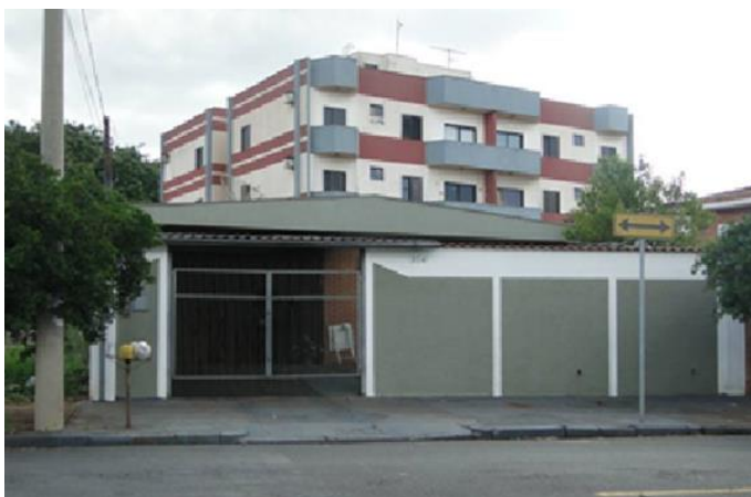
Figura 25 - Vista geral do imóvel. Fonte: Autoria própria, 2015.
