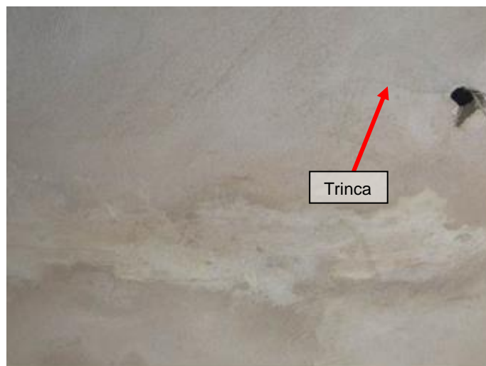
Figura 2 B: Laje executada na garagem. Fonte: Autoria própria, 2015.
