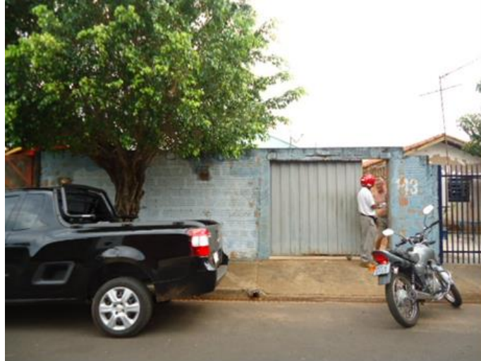
Figura 35 - Fachada do imóvel. Fonte: Autoria própria, 2015.
