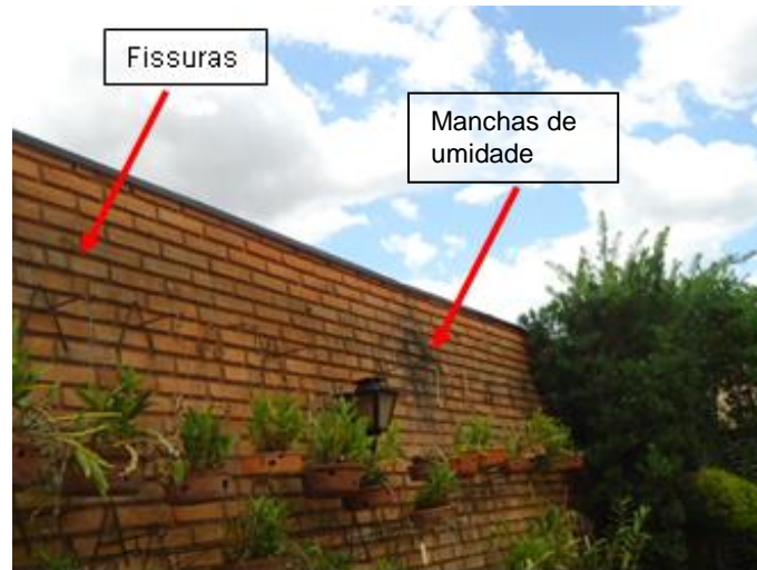
Figura 3 A: Muro de divisa. Fonte: Aatoria própria, 2015.
