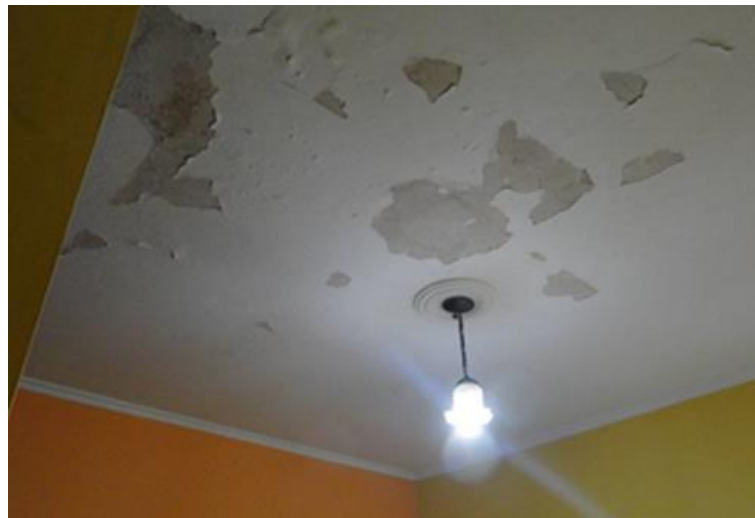
Figura 13 C: Vista do teto do quarto 1. Fonte: Aatoria própria, 2015.
