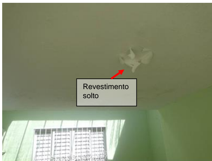
Figura 32 - Vista do teto da garagem. Fonte: Autoria própria, 2015.
