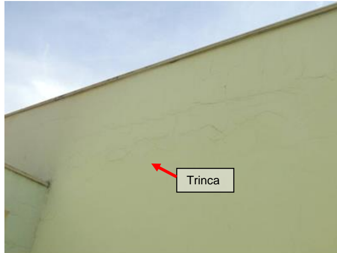
Figura 12 D: Vista da parede lateral da garagem. Fonte: Autoria própria, 2015.
