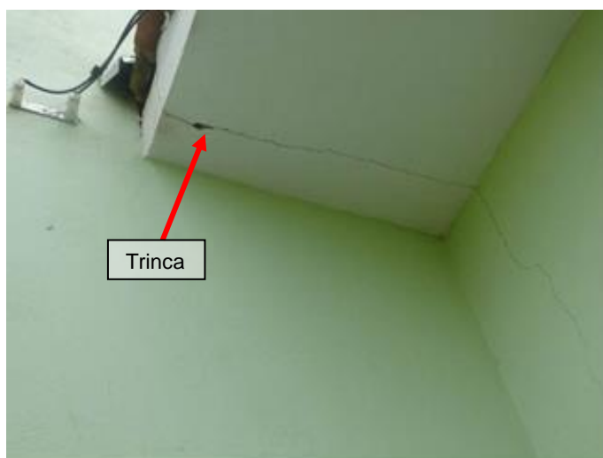
Figura 22 - Vista parcial da platibanda em destaque. Fonte: Aatoria própria, 2015.
