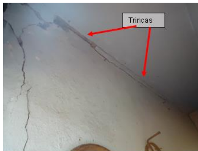
Figura 17 - Vista do depósito - Parede de divisa com o vizinho. Fonte: Autoria própria, 2015.
