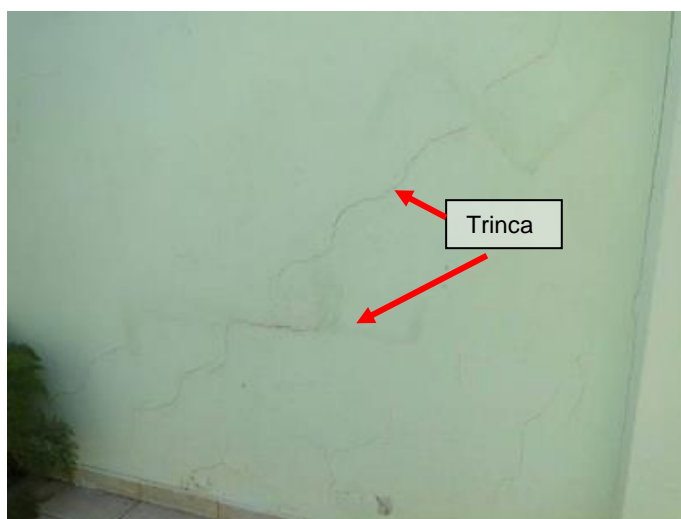
Figura 31 - Vista da parede da garagem. Fonte: Autoria própria, 2015.
