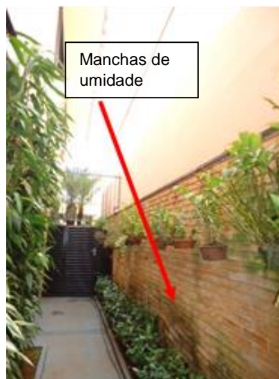
Figura 4 A: Vista do muro. Fonte: Aatoria própria, 2015.
