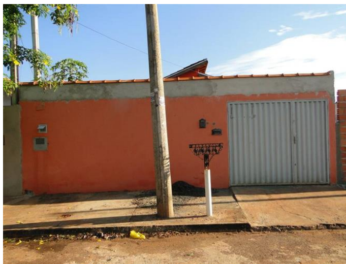
Figura 42 - Fachada do imóvel. Fonte: Autoria própria, 2015.
