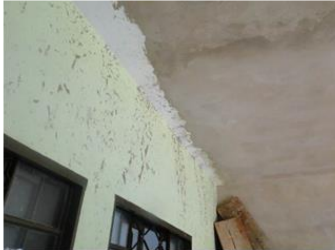
Figura 24 - Vista da parede recebendo a laje. Fonte: Autorial própria, 2015.
