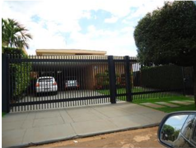
Figura 14 - Vista geral do imóvel. Fonte: Autoria própria, 2015.
