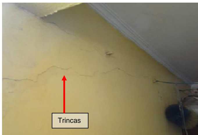
Figura 27 - Vista de parede lateral no fundo do imóvel. Fonte: Aatoria própria, 2015.
