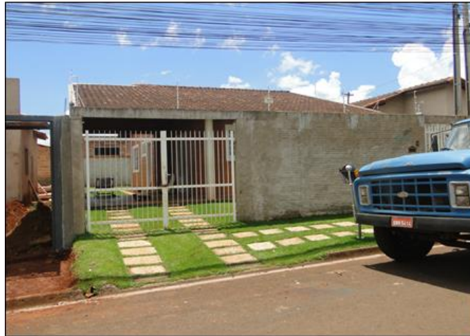
Figura 38 - Fachada do imóvel. Fonte: Autoria própria, 2015.
