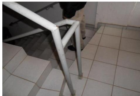
**Figura 22 - Corrimão com cantos vivos e escada sem anti derrapante**
