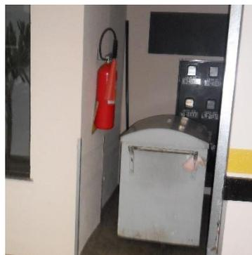
**Figura 32 – Falta de sinalização e espaço para utilização do extintor**
