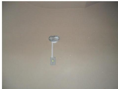
**Figura 38 – luminárias mantidas por bateria**
