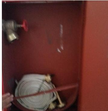
Figura 50 - Mangueira insuficiente para proteção.
