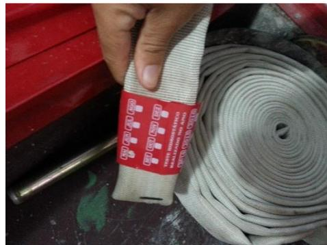
Figura 51 - Etiqueta de inspeção da mangueira.
