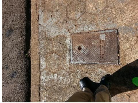
**Figura 53 - Localização do hidrante de recalque correta.**
