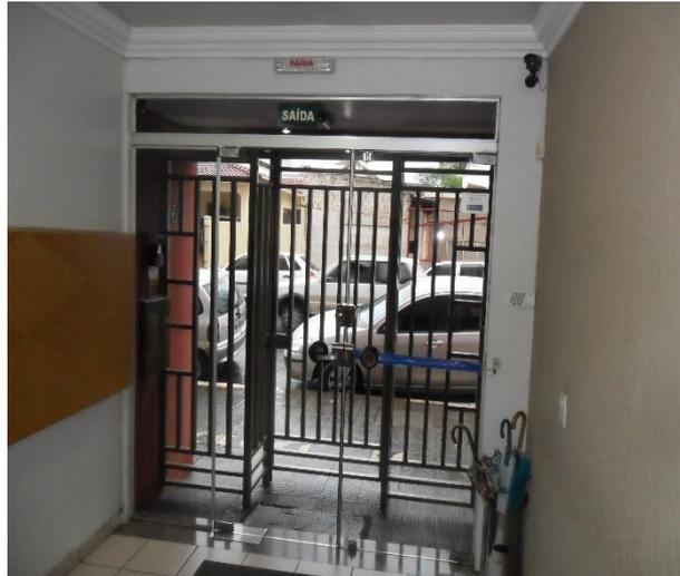
**Figura 29 - Porta de segurança impedindo a rota de fuga.**
