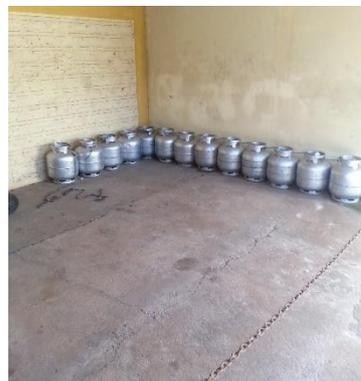
**Figura 44 - Botijões de gás armazenados de forma indevida.**
