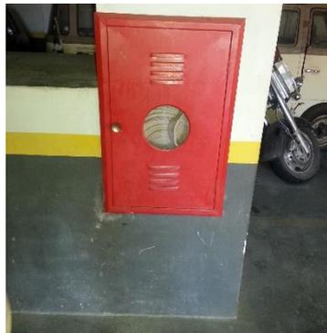
**Figura 48 - Caixa de hidrante sem sinalização**
