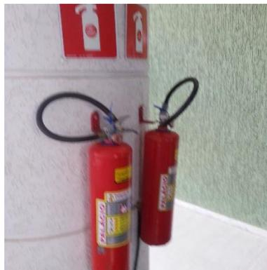
**Figura 34 – Duas unidades extintoras devidamente sinalizadas.**
