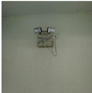
**Figura 37 – Iluminação por bloco autônomo.**
