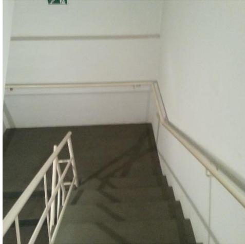
**Figura 23 - Corrimão contínuo, sem cantos vivos e piso ante derrapante**
