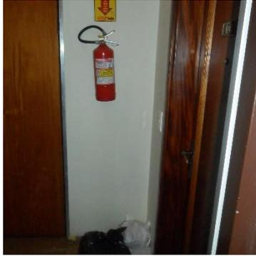
**Figura 33 – Sacos de lixo impedindo fácil acesso ao extintor**
