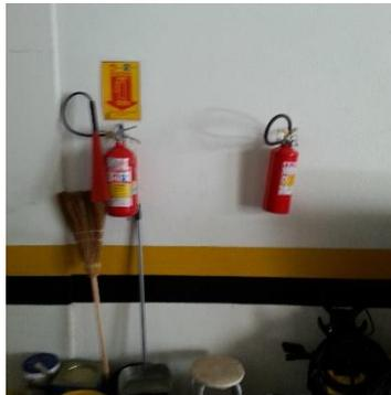
**Figura 31 – Equipamento de limpeza dificultando a utilização do extintor.**
