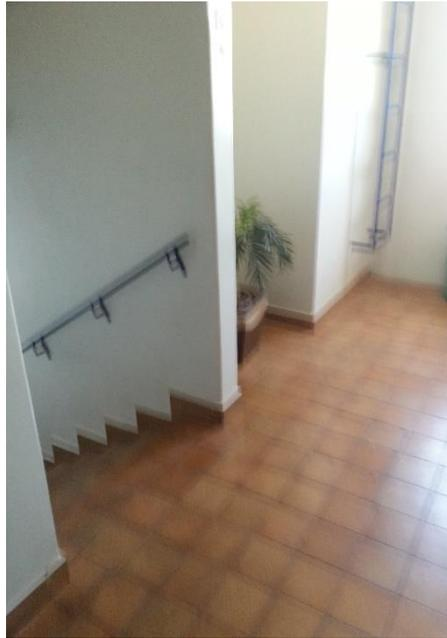
**Figura 25 - 1° edifício sem escada enclausurada**
