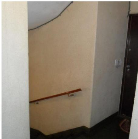
**Figura 26 - 2° edifício sem escada enclausurada**
