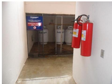
Figura 47 - Central de GLP protegida por extintores.
