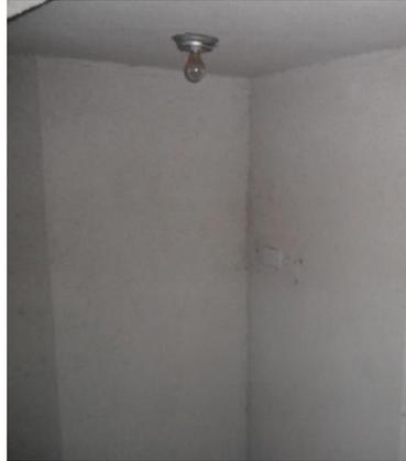
**Figura 39 – luminária inadequada**
