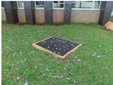
**Figura 54 - Hidrante de recalque em jardim acima do nível da rua.**
