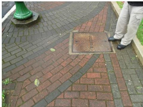
**Figura 55 - Hidrante de recalque longe da guia.**
