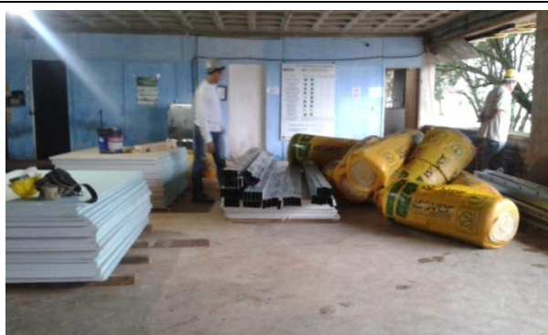
Figura 17 – Componentes estocados inicialmente no 1º pavimento de garagem
