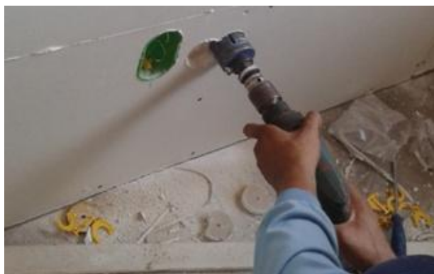
Figura 28– Corte do gesso acartonado para colocação de caixinha elétrica
