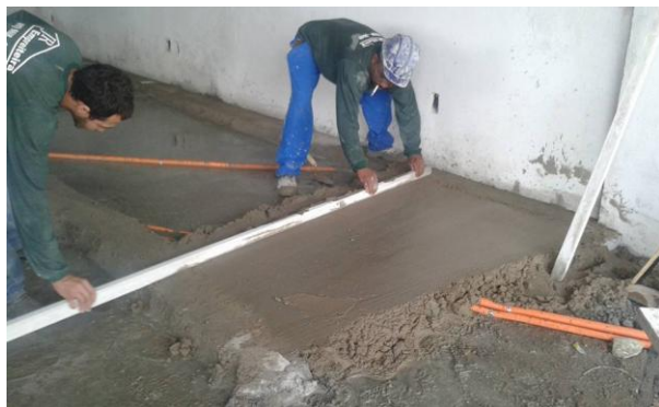
Figura 15 – Concretando o contra piso do apartamento
