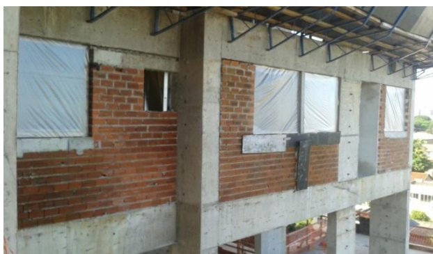
Figura 16 – Proteção provisória de intempérie do apartamento
