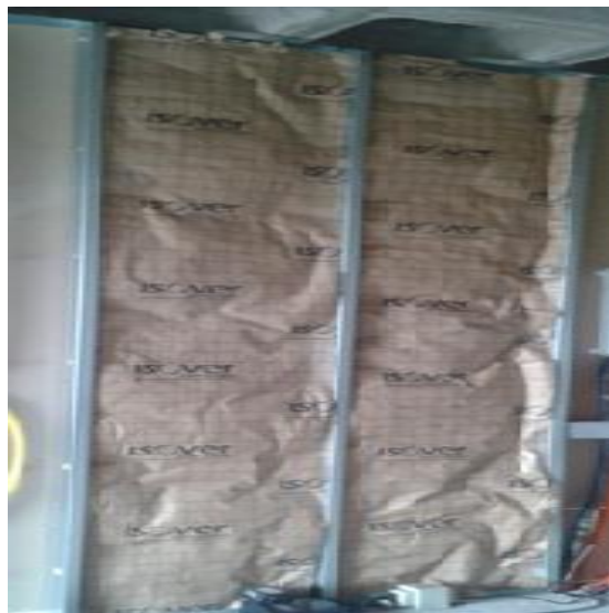
Figura 33 – Lã de vidro colocada no interior da parede de Drywall
