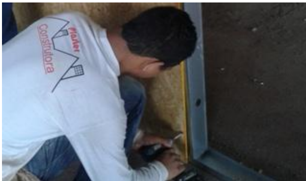
Figura25 - Fixação de placa de OSB com parafuso especial para Drywall
