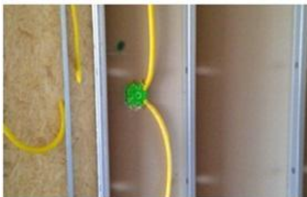
Figura 31– Mangueiras colocadas no interior das paredes
