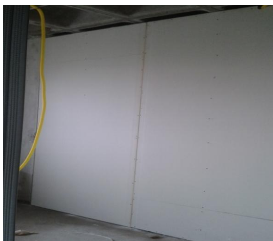
Figura 34 – 2ª face da parede de Drywall fechada
