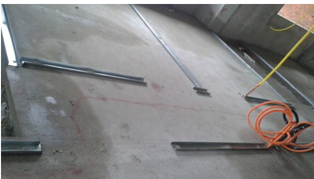
Figura 22 – Guias inferiores colocadas
