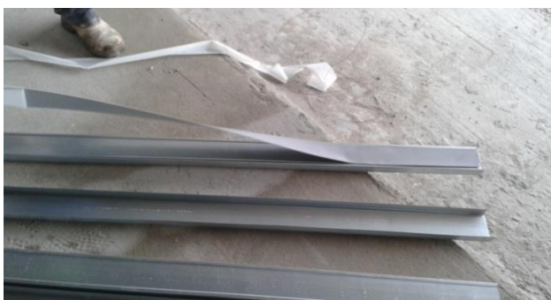
Figura 21 – Fita de isolamento sendo colocada nas guias
