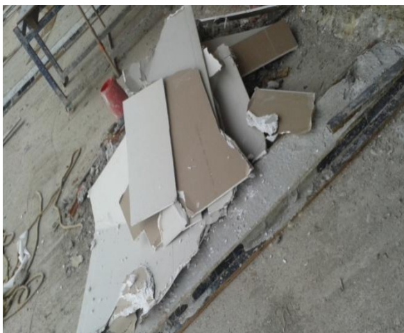
Figura 37 – Resíduo de Gesso acartonado.
