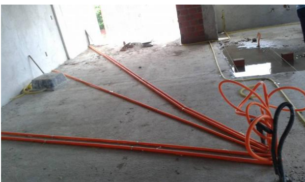
Figura 13 – Instalação hidráulica que ficará dentro do contra piso
