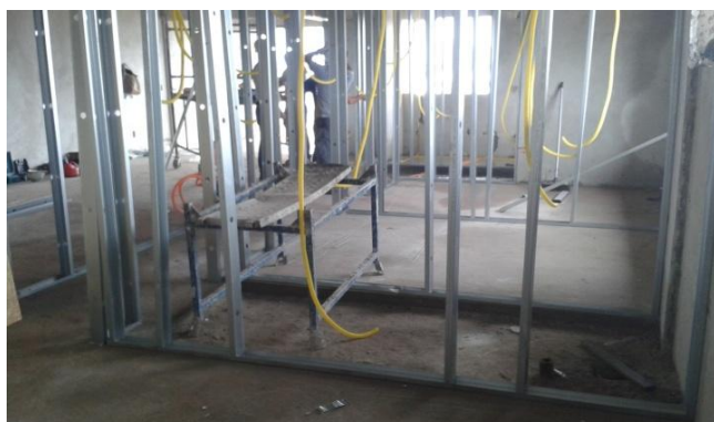
Figura 23 – Montantes colocados
