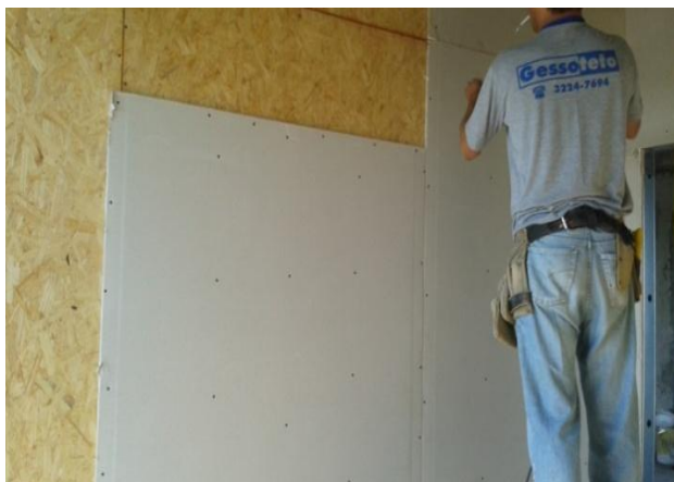
Figura 26 – Fixação de Gesso acartonado sobre OSB
