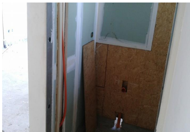
Figura 35 – 2ª face da parede de Drywall aberta para término da passagem de tubulação
