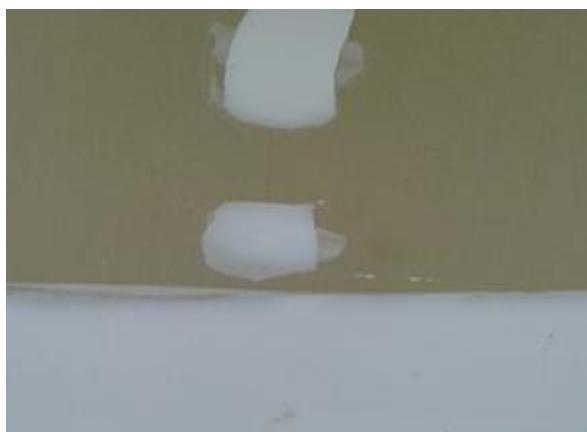
Figura 36 – Tratamento da junta do gesso acartonado e do parafuso de fixação – 2ª camada
