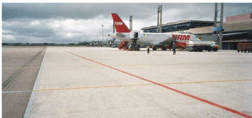
Figura 12: Pátio de Aeronaves Aeroporto Afonso Pena, Curitiba - PR Fonte: Rudloff
