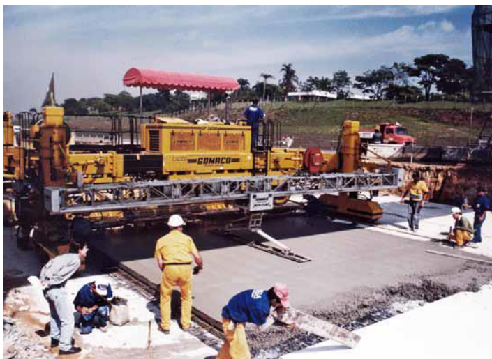
Figura 13: Vibroacabadora na construção do pavimento de concreto na Nova Dutra
