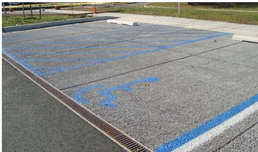
Figura 16: pavimento permeável de concreto poroso Fonte: ABCP (2011)
