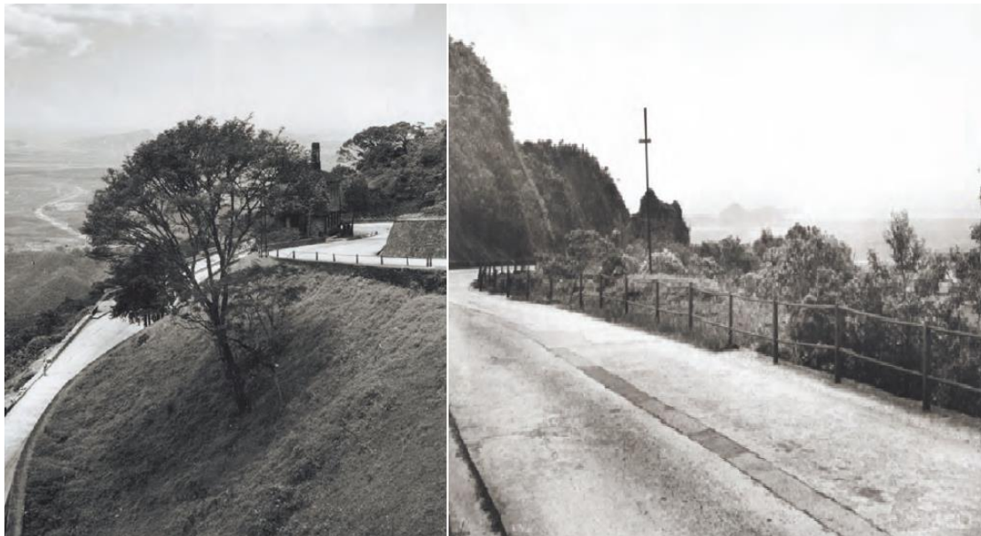
Figura 1: Caminhos do Mar – primeira estrada pavimentada com concreto na América Latina.
