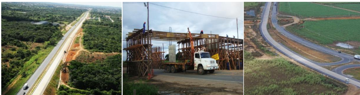
Figura 10: BR 101 NE (Lote 01/ RN, Lote 03/AL, Lote 06/PE) Fonte: DEC (Departamento de Engenharia e Construção)
