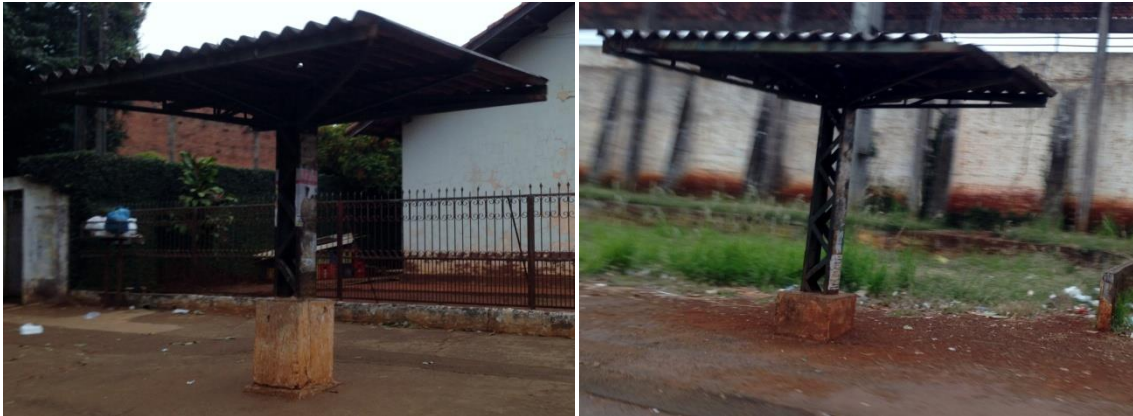
Figura 25 - Pilar coberto com telha ondulada de fibrocimento Fonte: Autoria Própria
