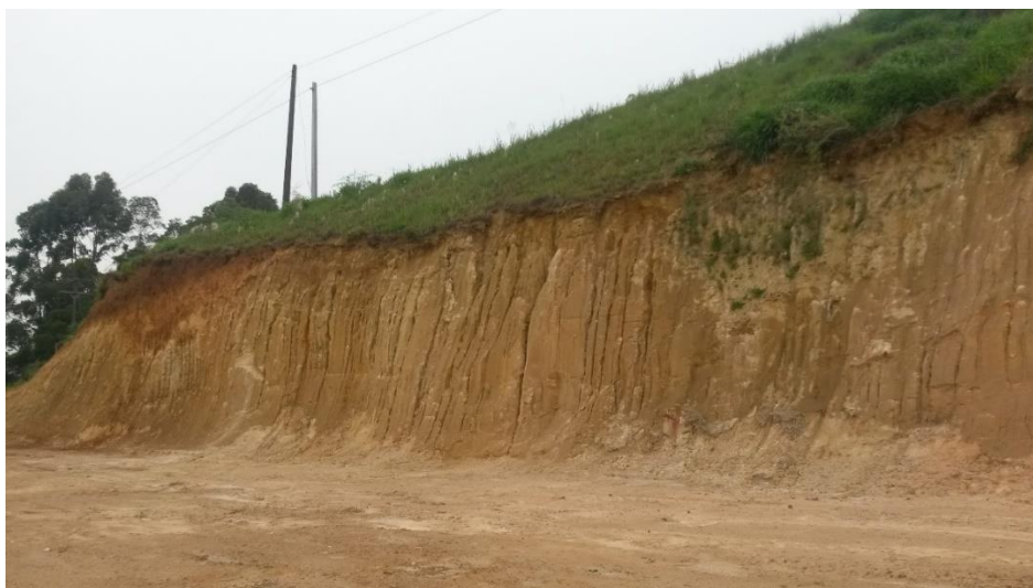
Figura 14 - Talude original de estudo Fonte: Autoria própria.
