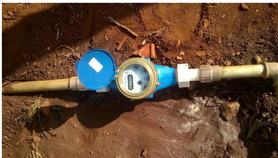
Figura 11- Hidrômetro instalado no Colégio Estadual de Campo Mourão. Fonte: Elaboração própria. Fotografada em: 25/03/2015
