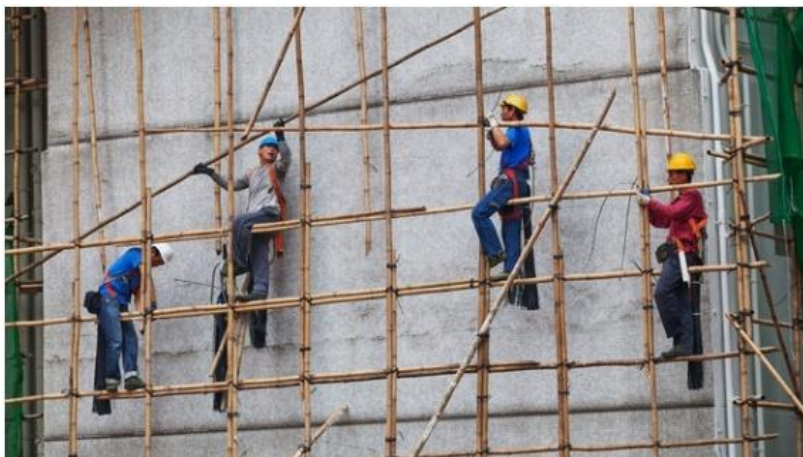
Figura 6 - Andaime de bambu de camada simples Fonte: Engenharia e Construção (2012)
