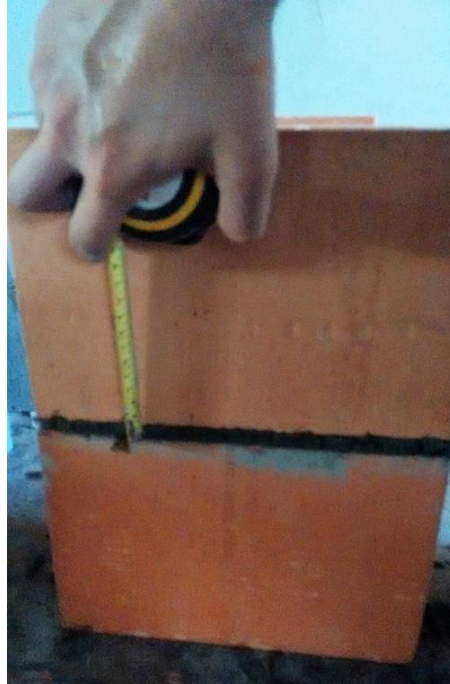
Figura 14 - Verificação da Espessura de Assentamento. Fonte: Autoria própria.
