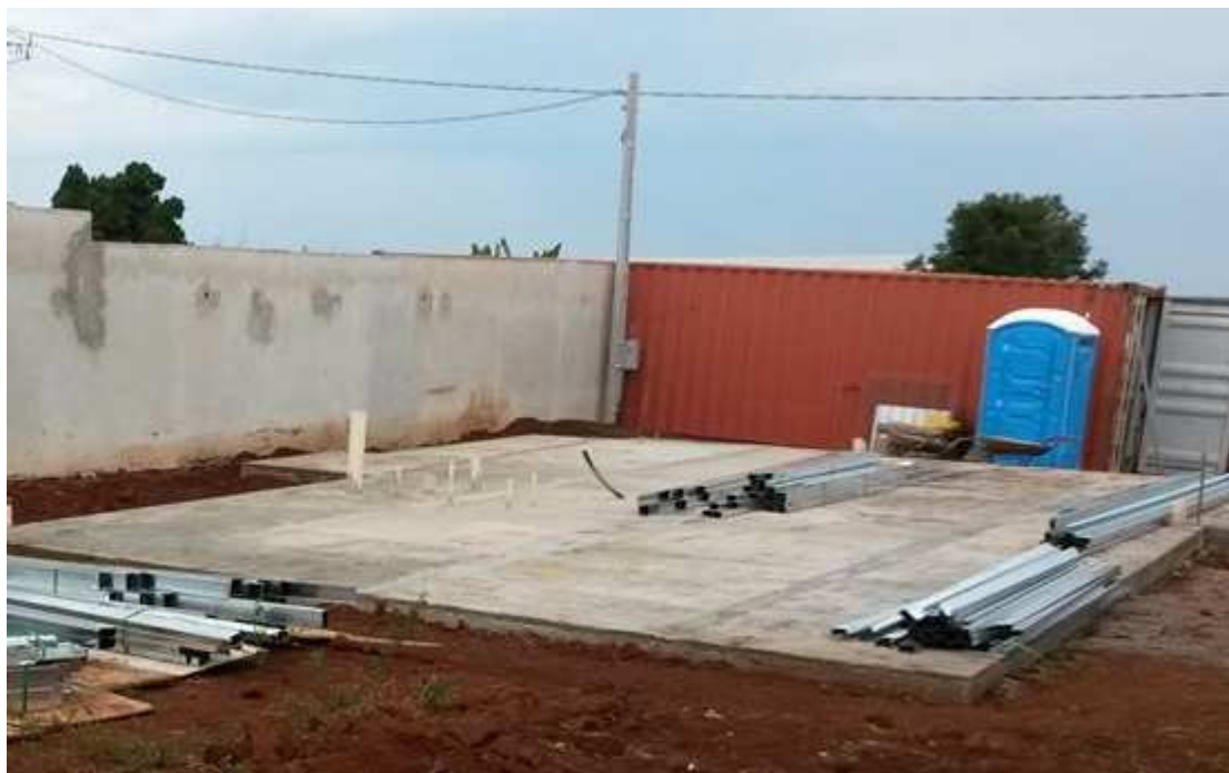
Figura 33 – Laje radier concretada. Fonte: Arquivo da empresa Montaggio.
