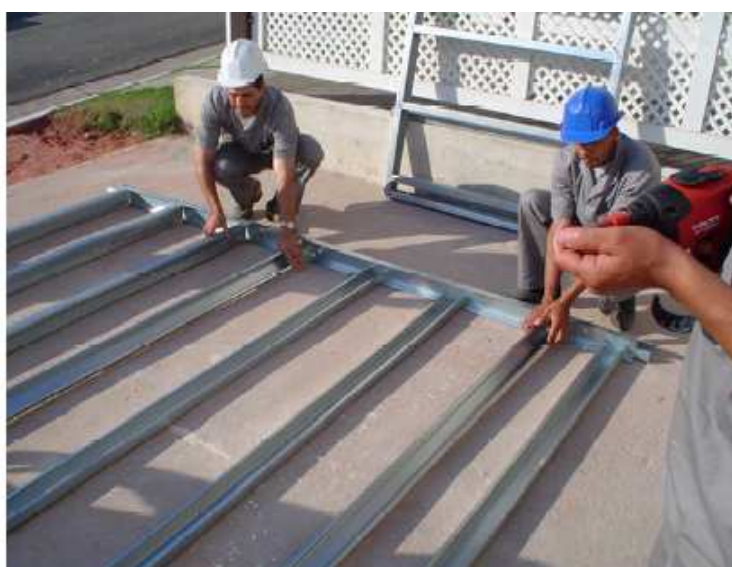
Figura 2 - Montagem de painel em Light Steel Framing no canteiro de obras.
