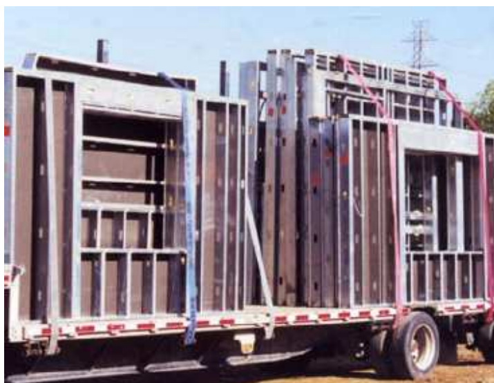
Figura 3 - Painéis em Light Steel Framing produzidos em fábrica e transportados para obra.
