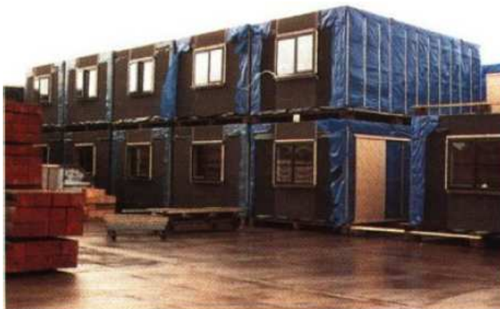
Figura 5 - Construção de edifício em módulos. Fonte: Santiago, 2008, s/p.
