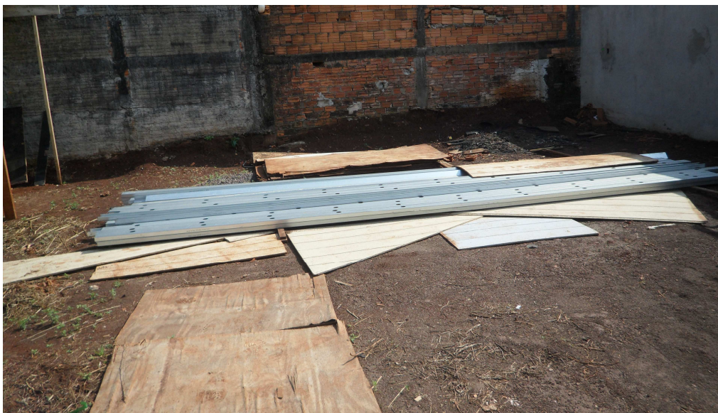
Figura 28 - Guias e montantes de 6 metros. Fonte: Arquivo do Autor
