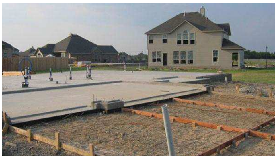
Figura 6 – Fundação tipo laje radier com instalações hidrossanitárias e elétricas aparentes.
