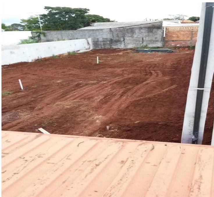
Figura 31 – Terreno nivelado. Fonte: Arquivo da empresa Montaggio.
