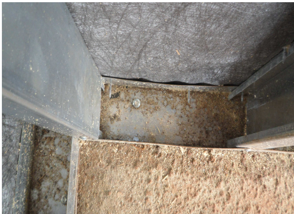
Figura 37 – Fixação do painel na laje radier. Fonte: Arquivo do Autor.
