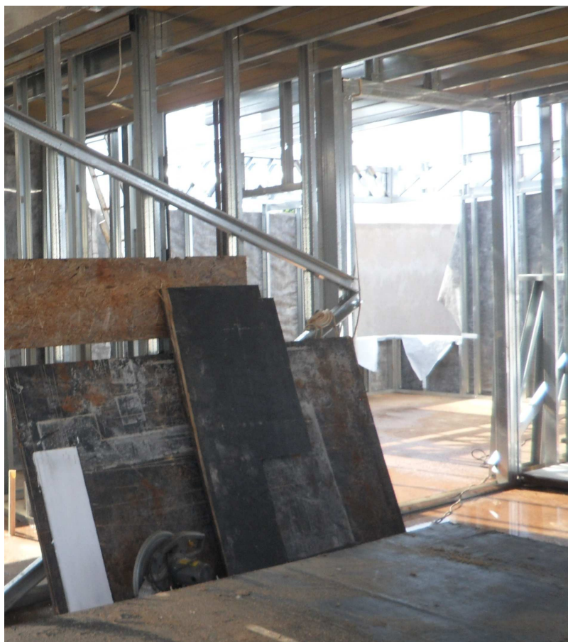
Figura 35 – Painéis com viga-caixa. Fonte: Arquivo do Autor
