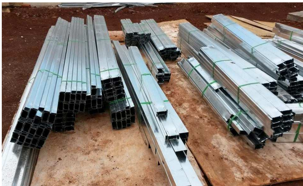
Figura 27 - Guias e montantes de 3 metros. Fonte: Arquivo da empresa Montaggio
