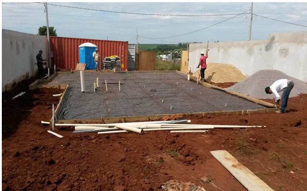
Figura 32 – Lona de impermeabilização e instalações elétricas e hidráulicas preliminares, antes da concretagem da fundação. Fonte: Arquivo da empresa Montaggio.
