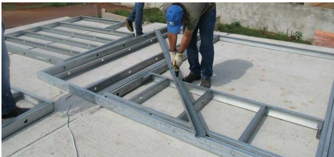
Figura 30 – Montagem dos perfis de aço. Fonte: Arquivo da empresa
