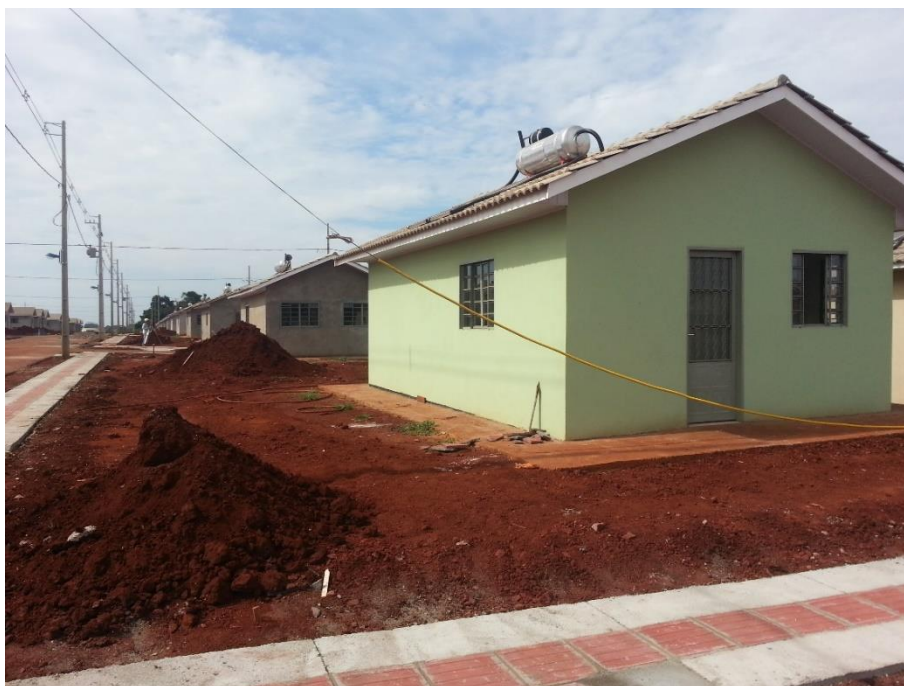
Figura 11 – Registro Fotográfico de uma unidade habitacional na fase final do Residencial. Fonte- Autoria própria.
