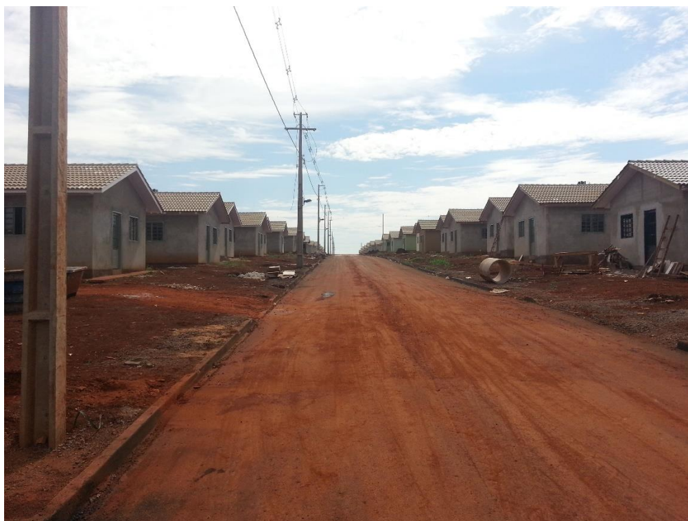
Figura 09 – Registro Fotográfico das obras do Residencial. Fonte- Autoria própria.
