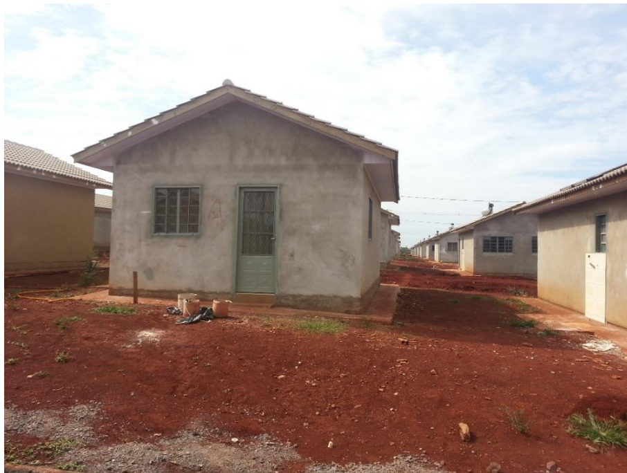
Figura 10 – Registro Fotográfico de uma unidade habitacional em obras do Residencial. Fonte- Autoria própria.
