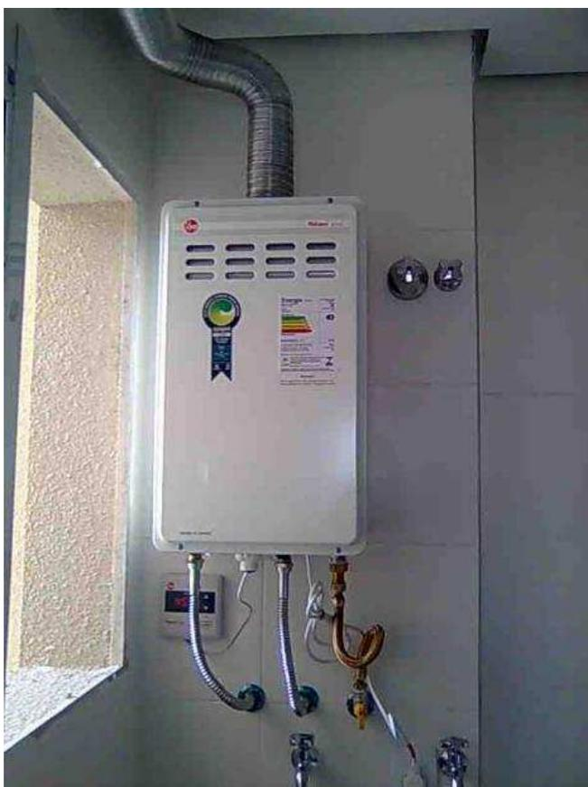
**Figura 15 - Aquecedor de passagem de 8 litros**
