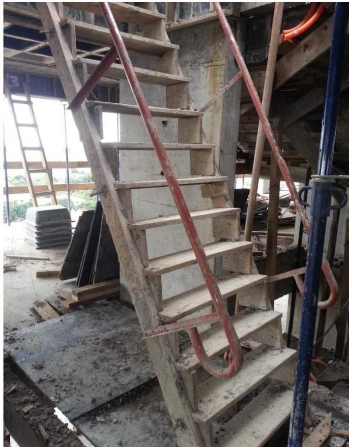
Figura 23– Escadas de uso coletivo Obra B Fonte: Arquivo do Autor
