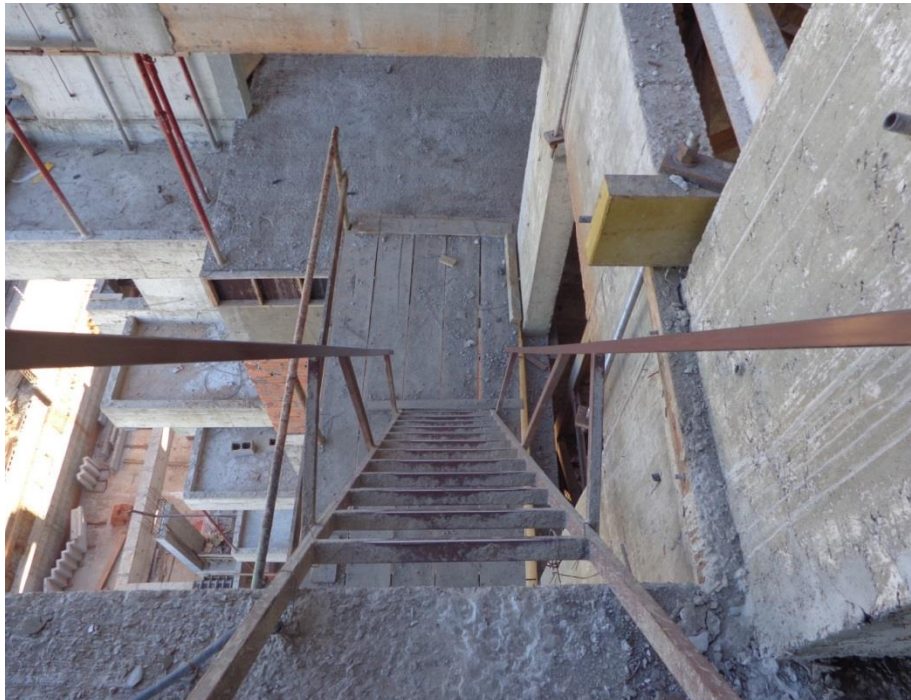
Figura 16 – Escadas de uso coletivo Obra A
