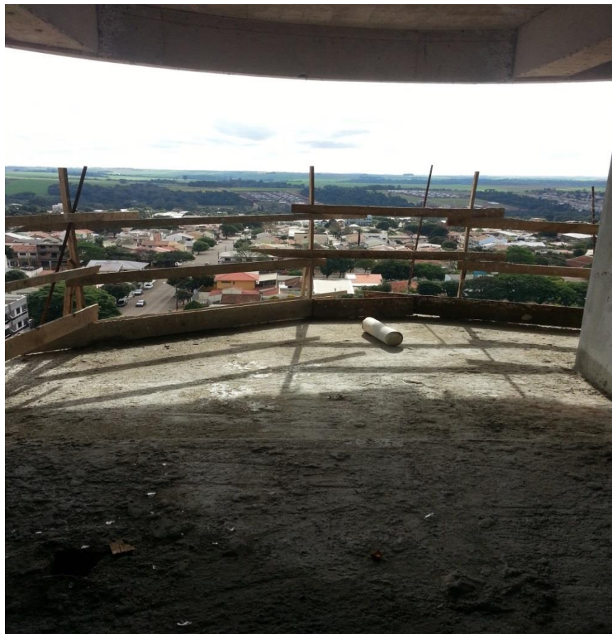
Figura 21- Sistema de guarda corpo – rodapé Obra B
