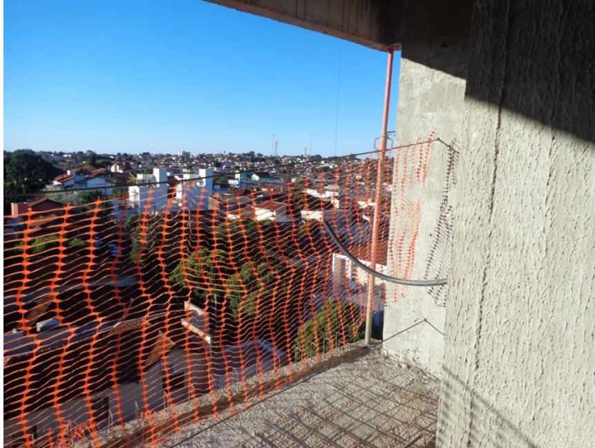
Figura 15 – Sistema de barreira com rede Obra A Fonte: Arquivo do autor
