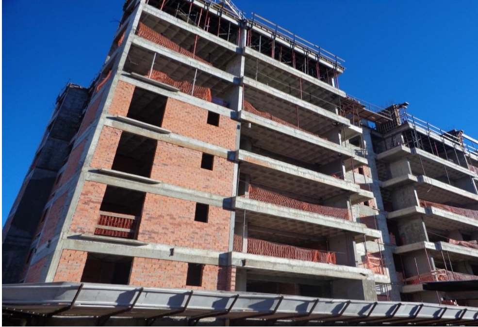
Figura 18 – Dispositivos de proteção para limitação e quedas 2 Obra A Fonte: Arquivo do Autor
