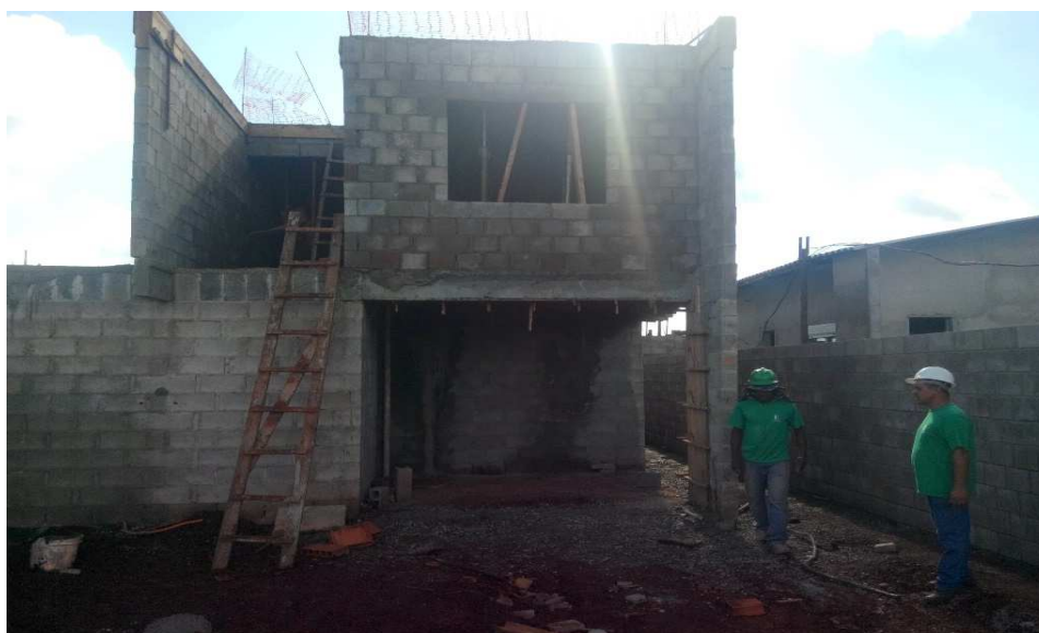
Figura 3- Sobrados em execução
