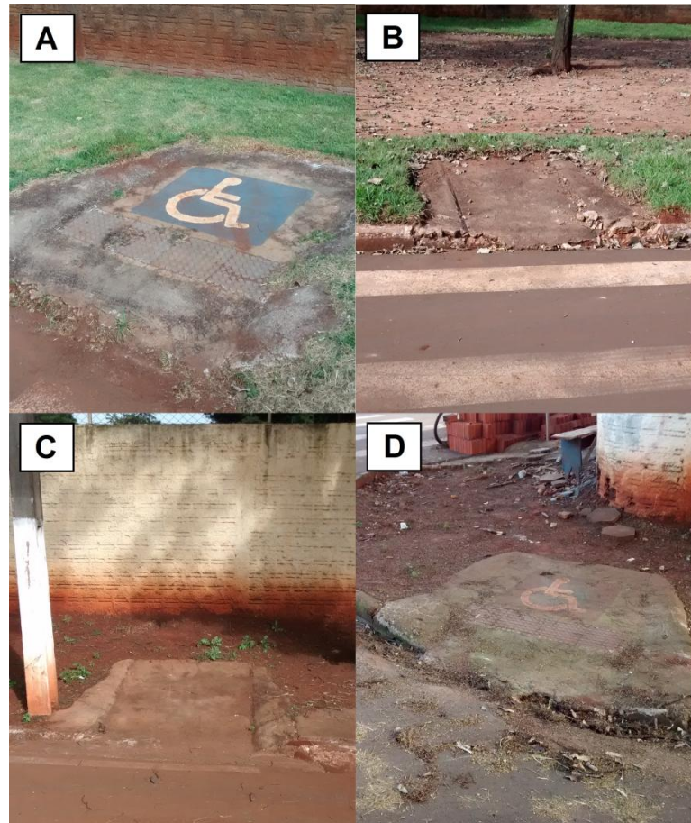
Figura 26 - Guias rebaixadas encontradas nas ruas da cidade Fonte: Autoria própria(2014).
