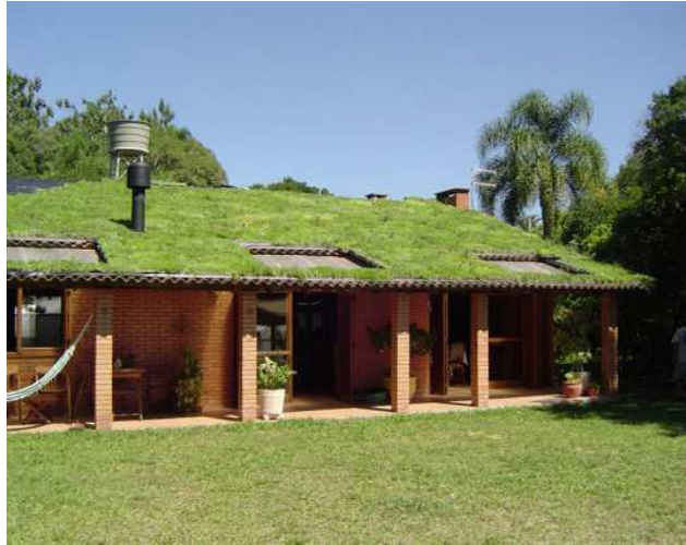
Fotografia 3: Telhado Verde de Classe Extensiva Fonte: Cia Ecológica, 2011.
