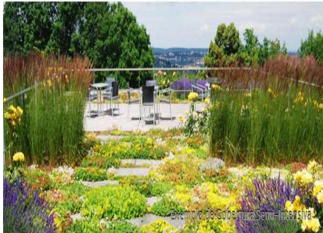
Fotografia 2 – Telhado Verde de classe semi-intensiva Fonte: Coberturas Verdes, 2011.
