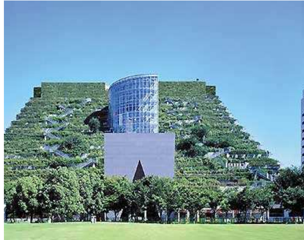
Fotografia 1 – Telhado Verde de Classe Intensiva Fonte: Cia Ecológica, 2011.
