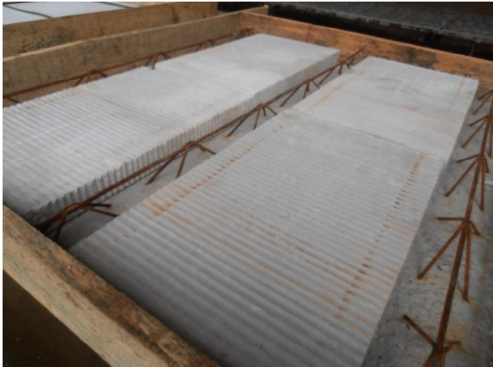
**Figura 9 - Montagem da Laje com Concreto Celular**
