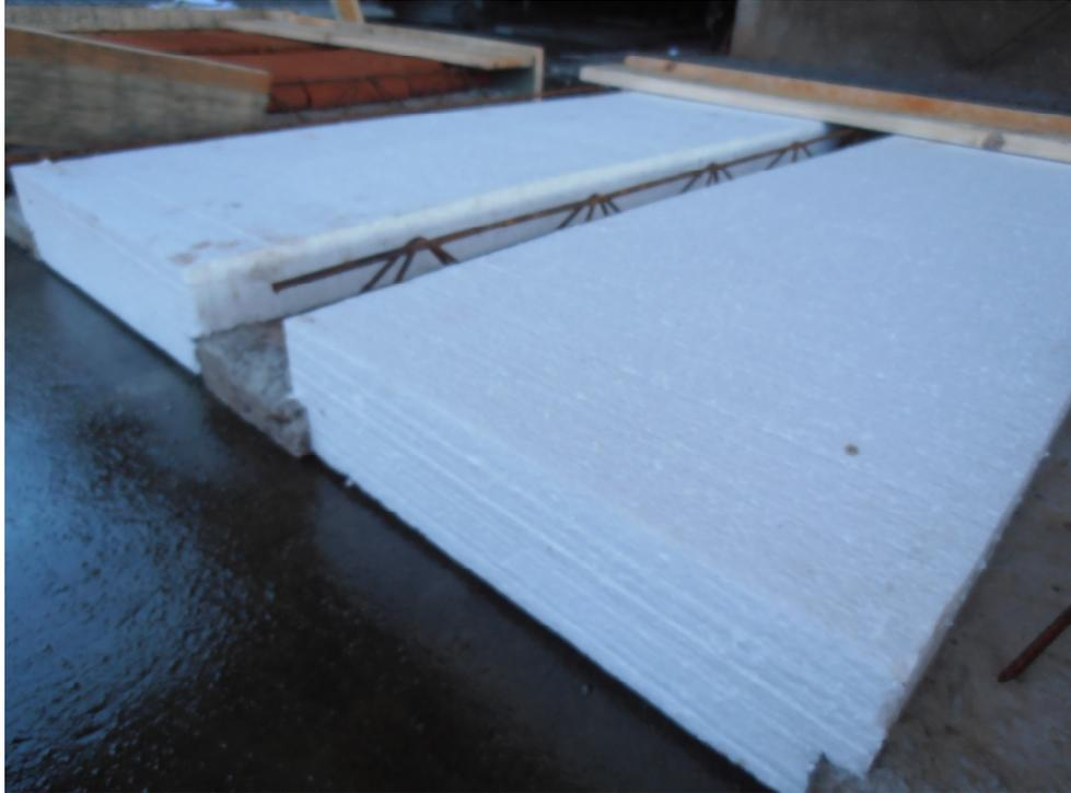
**Figura 7 - Montagem da Laje com EPS (Poliestireno Expandido)**
