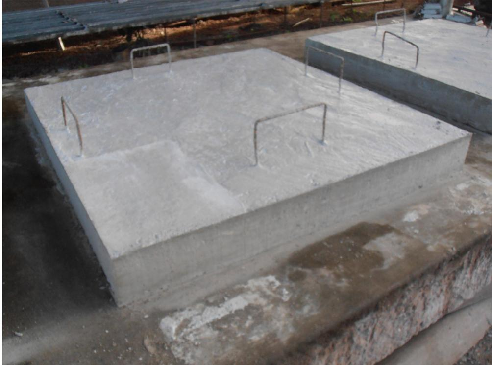
**Figura 11 - Laje Acabada com Alças para Manejo**
