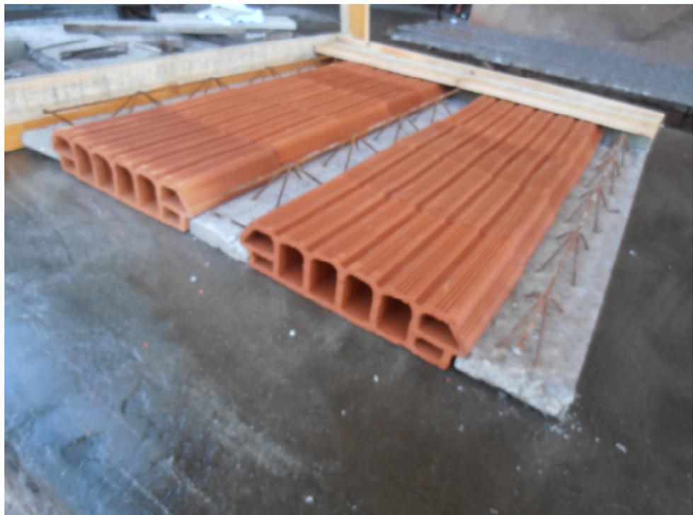
**Figura 8 - Montagem da Laje com Lajota Cerâmica**
