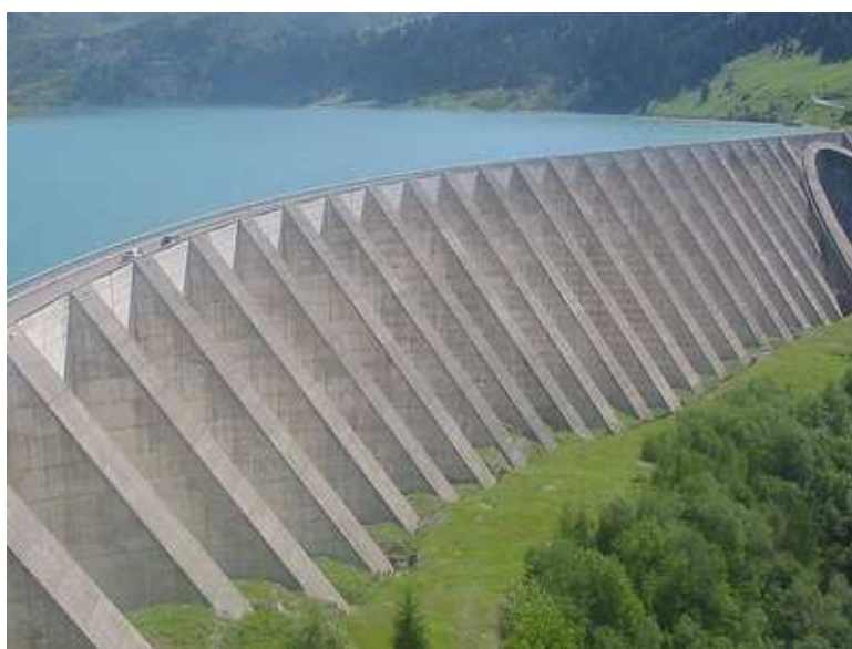
Figura 13 – Barragem em contraforte Buttress Dam Fonte: França (2014).
