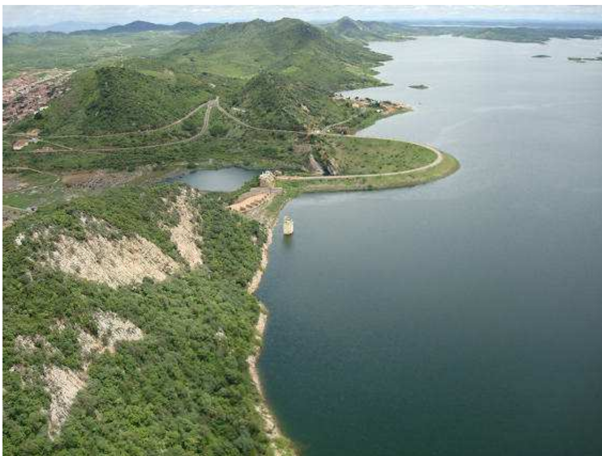
Figura 36 – Vista da barragem de Orós
