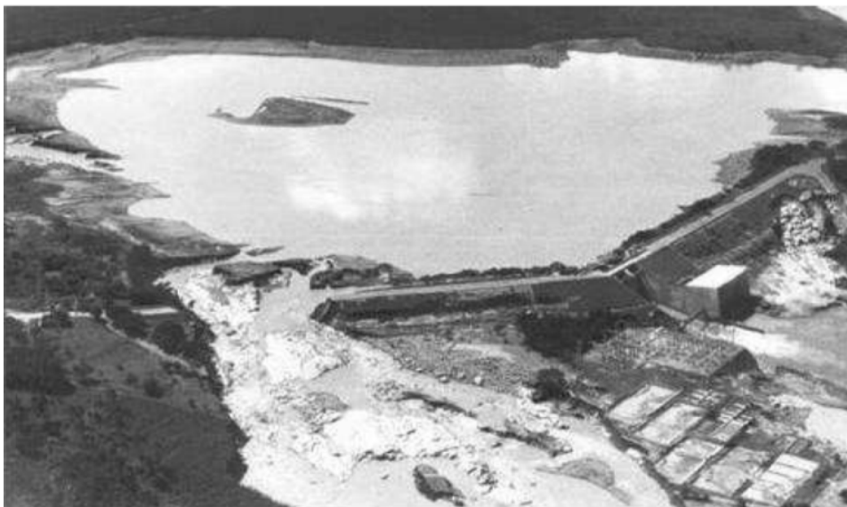
Figura 29 – Usina hidroelétrica de Armando Sales de Oliveira após o galgamento Fonte: Carvalho (2007, apud SALIBA, 2009).
