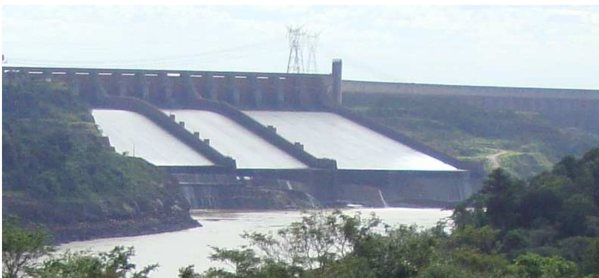
Figura 5 – Vertedouro da barragem de Itaipu
