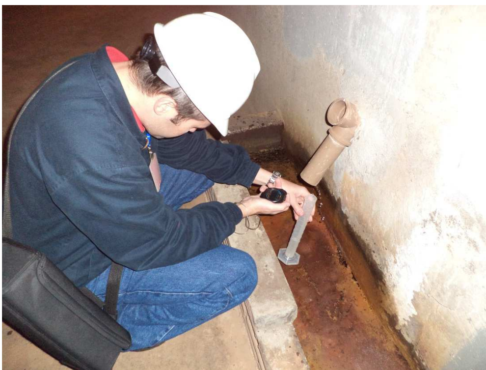
Figura 22 – Medição de pequena vazão em um dreno de uma barragem de concreto
