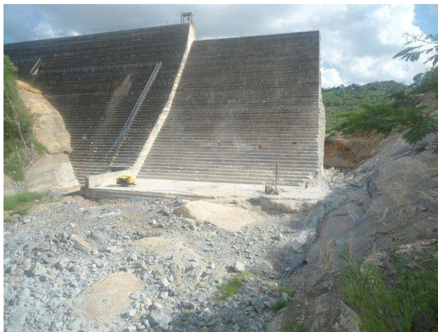
Figura 48 – Vista da jusante da reconstrução da barragem de Camará Fonte: Reconstrução... (2014).
