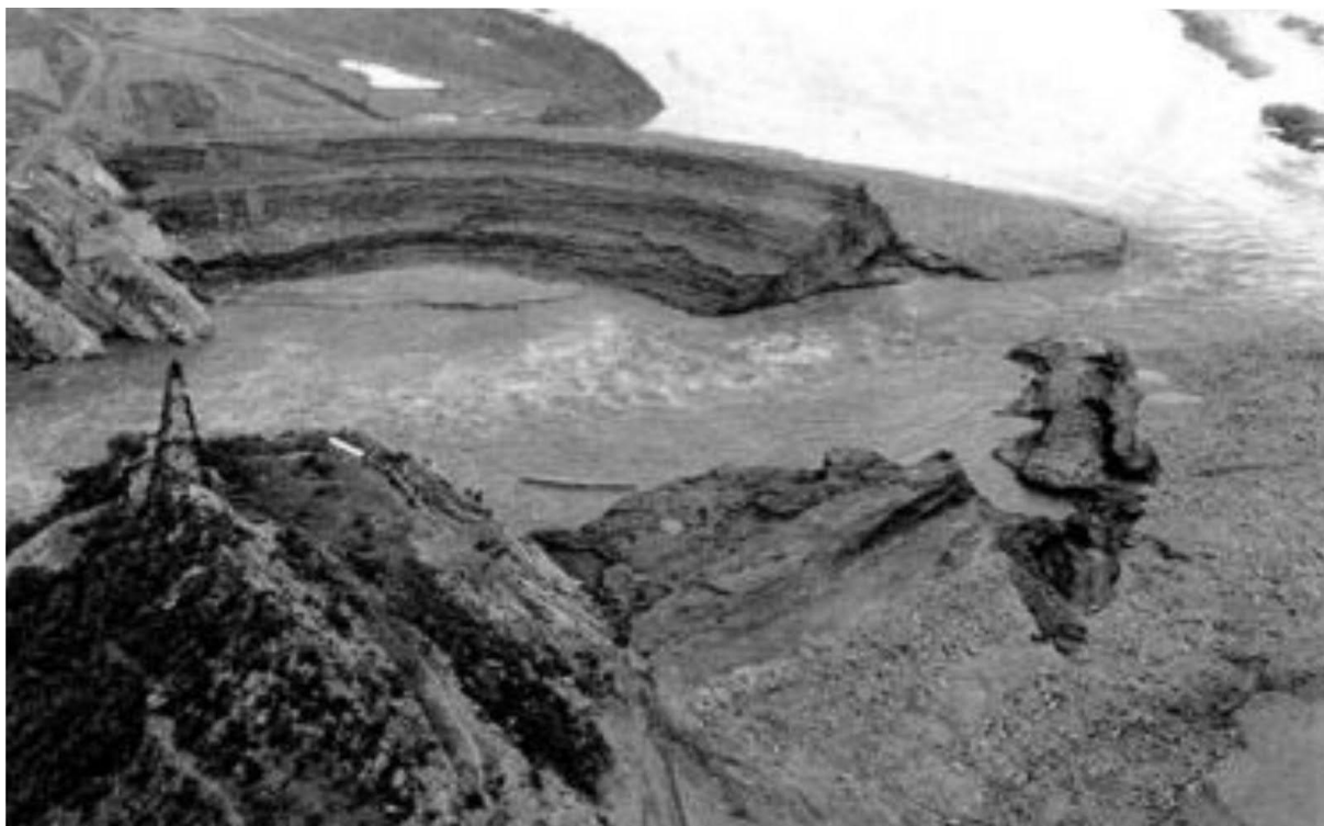
Figura 37 – Barragem de Orós após o rompimento
