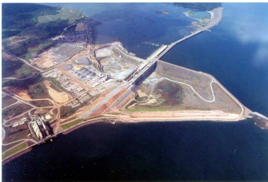
Figura 26 – Vista da UHE Tucuruí
