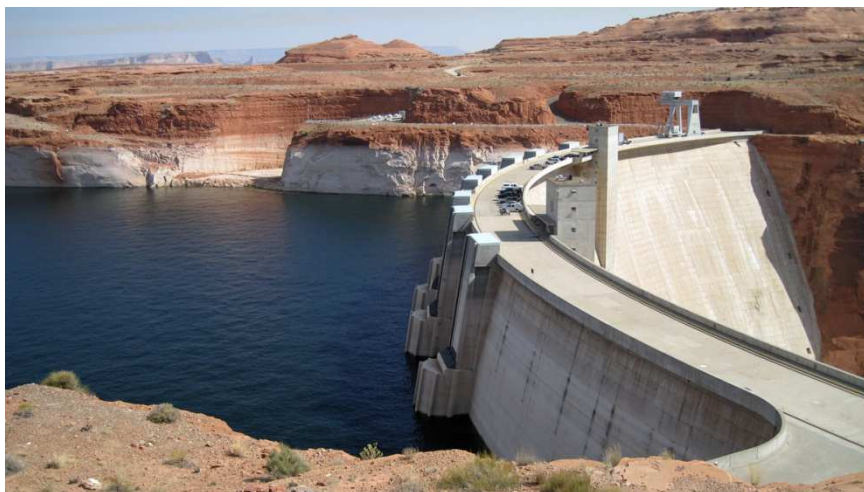
Figura 15 – Barragem em arco Glen Canyon Dam
