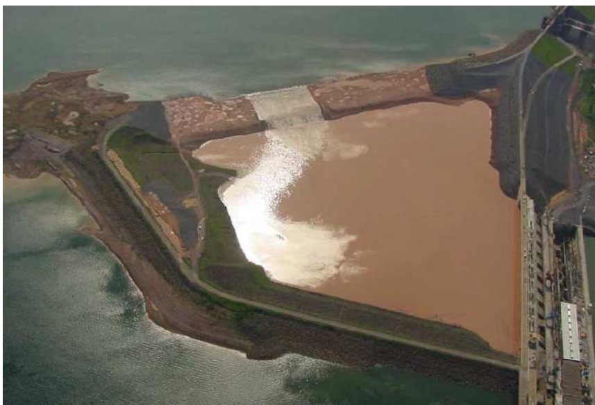
Figura 27 – Vista da UHE Tucuruí
