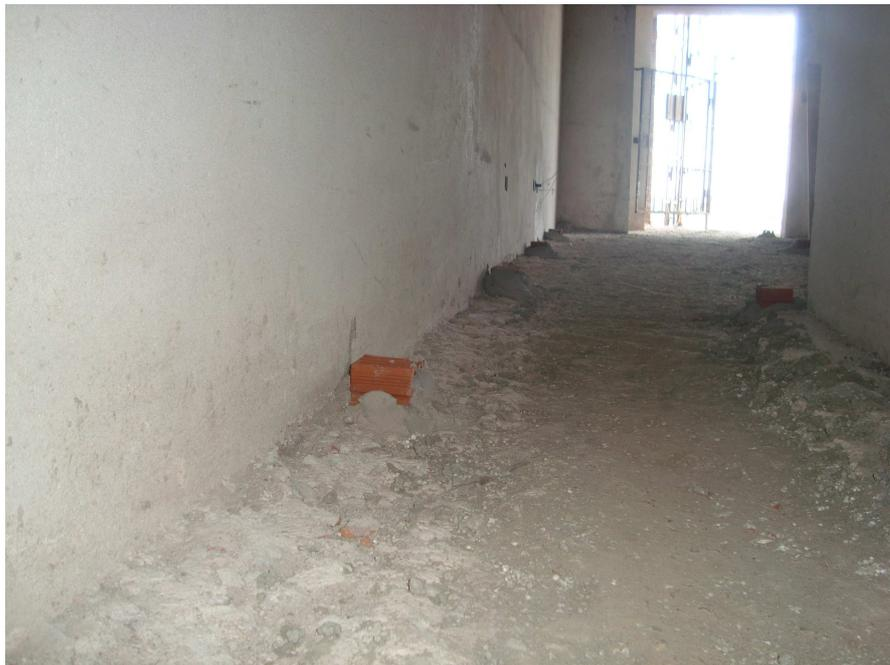
Figura 14 - Taliscas para nivelamento do pano de concreto
