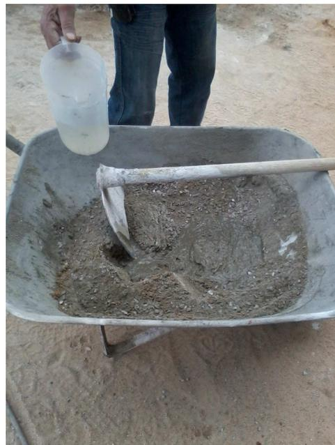
Figura 11 - Preparação do concreto na carriola
