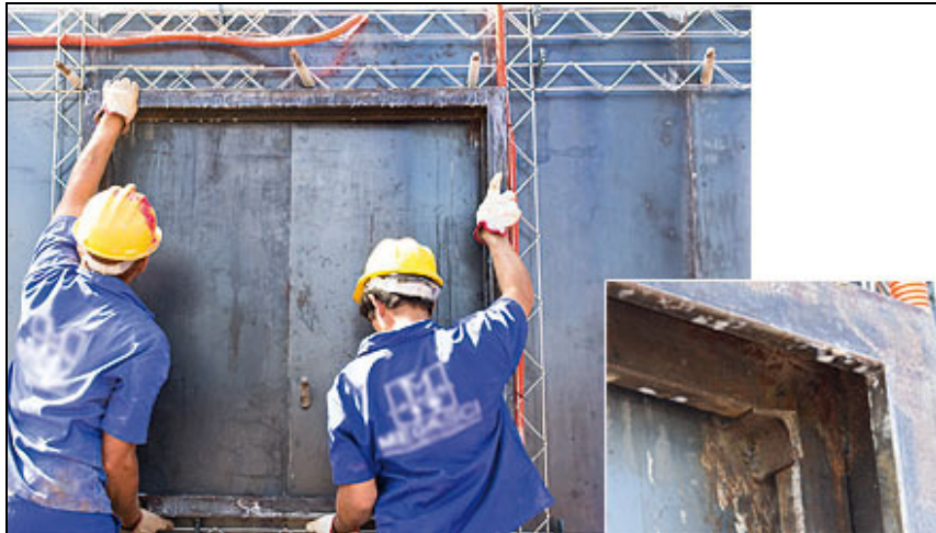
Figura 5 – Fixação do gabarito da janela Fonte: Venturini (2011).
