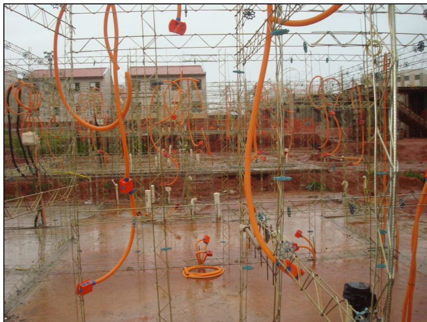
Figura 3 – Armação para paredes de concreto. Fonte: Elaborado pelo Autor (2013).
