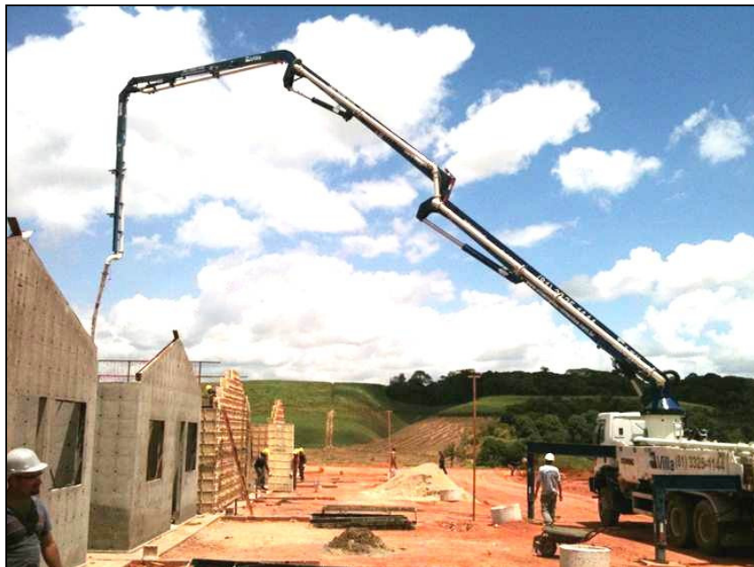
Figura 8 – Concretagem Fonte: Usimak (2012).
