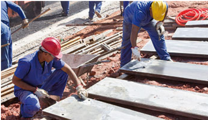
Figura 9 – Limpeza dos painéis Fonte: Venturini (2011).
