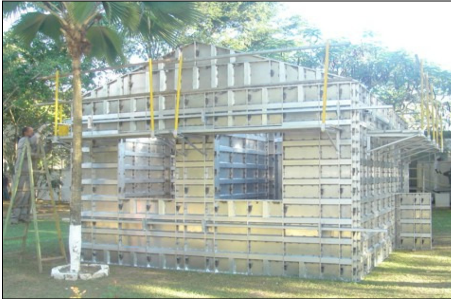
Figura 6 – Fôrmas de alumínio montadas Fonte: Fernandes (2010).
