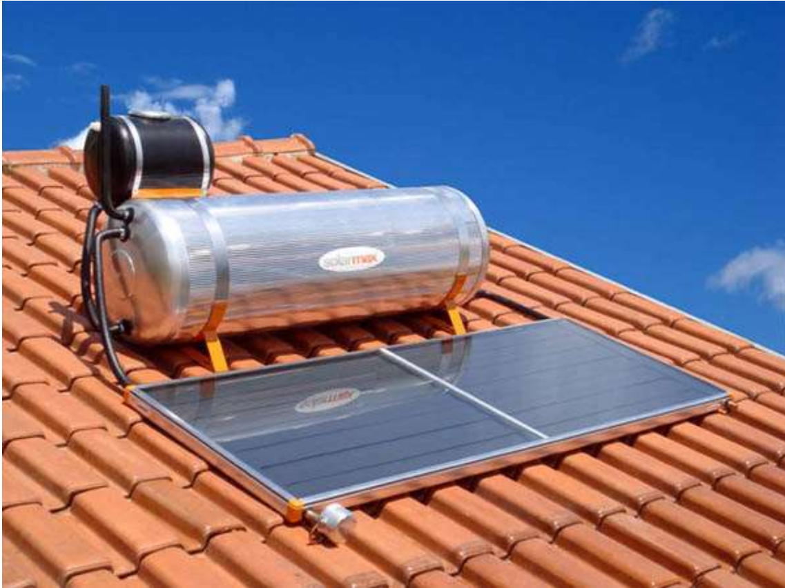
Figura 3 - Exemplo de boiler instalado no telhado de uma casa Fonte: construindo.org
