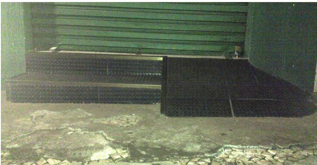
Figura 9 – Rampa estreita com largura de 74 cm Fonte: Autoria própria.
