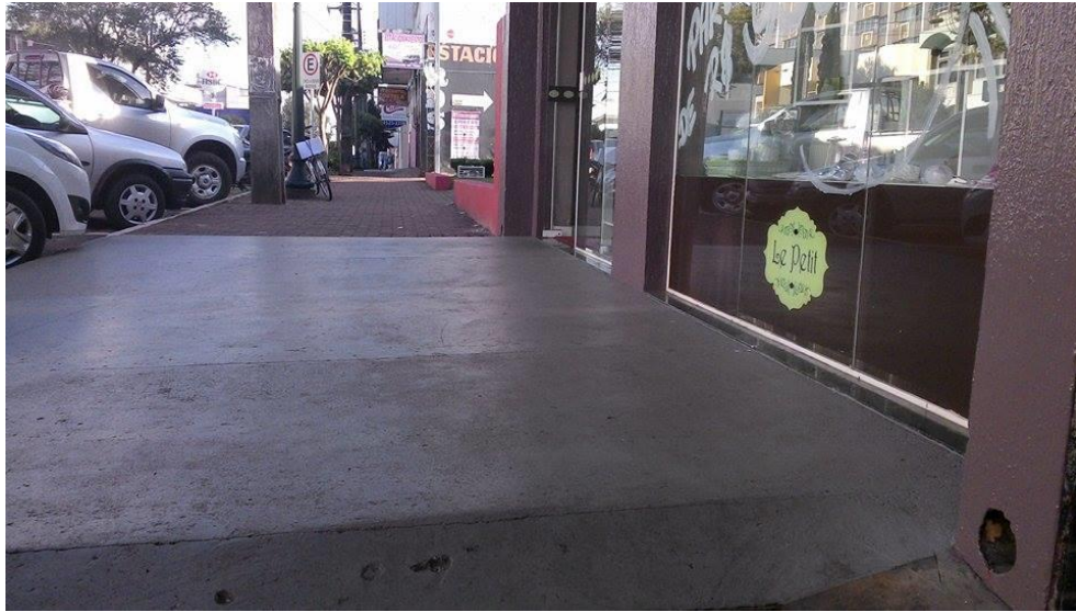
Figura 28 – Rampa correta de acordo com a NBR 9050/2004. Fonte: Autoria própria.
