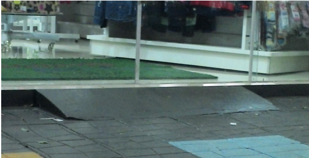
Figura 26 – Rampa correta de acordo com a NBR 9050/2004. Fonte: Autoria própria.
