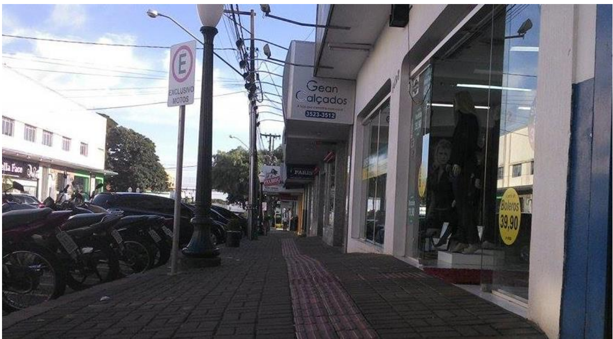
Figura 29 – Rampa correta de acordo com a NBR 9050/2004. Fonte: Autoria própria.
