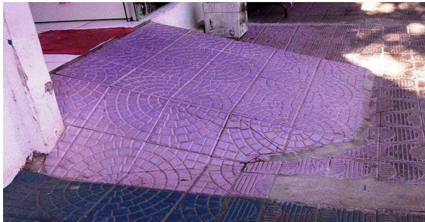
Figura 4 – Rampa com inclinação de 29,95% Fonte: Autoria própria.
