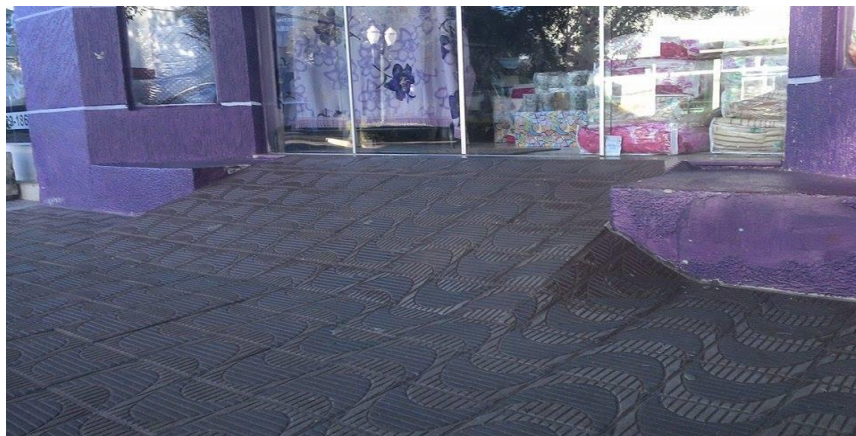
Figura 5 – Rampa com inclinação de 23,81% Fonte: Autoria própria.
