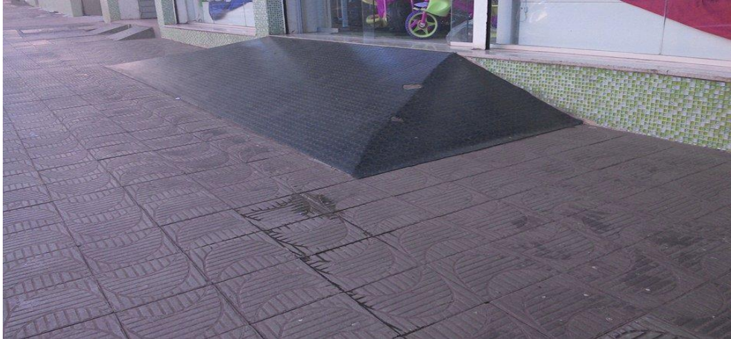
Figura 6 – Rampa com inclinação de 26,41% Fonte: Autoria própria.
