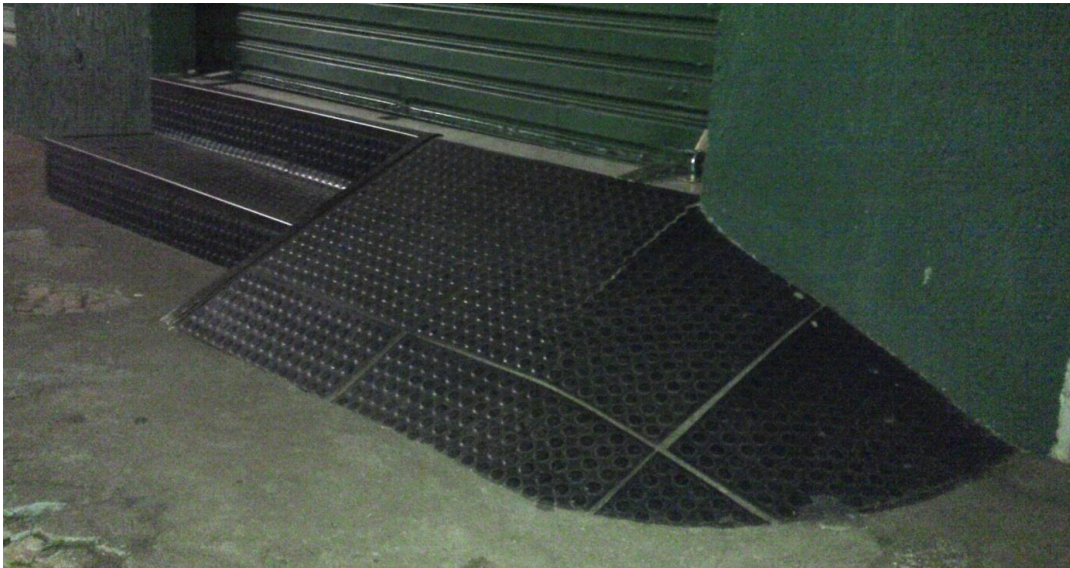
Figura 8 – Rampa com inclinação de 212,50% Fonte: Autoria própria.
