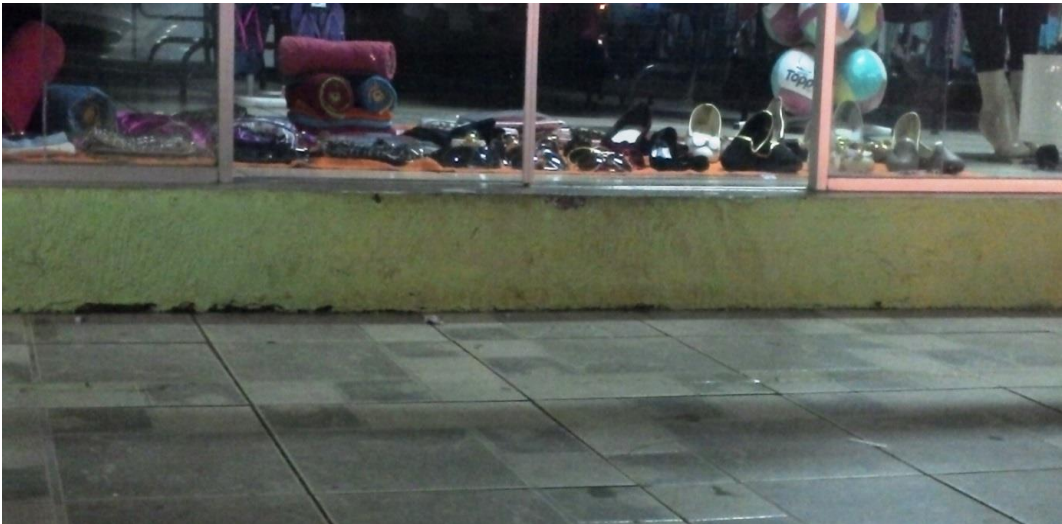
Figura 12 – Desnível de 23 cm Fonte: Autoria própria.
