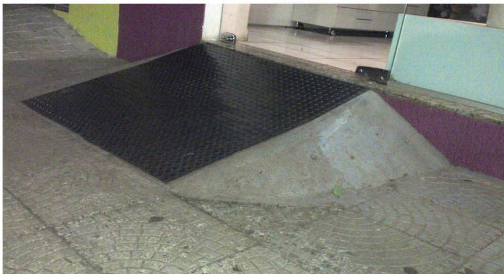
Figura 7 – Rampa com inclinação de 21,98% Fonte: Autoria própria.
