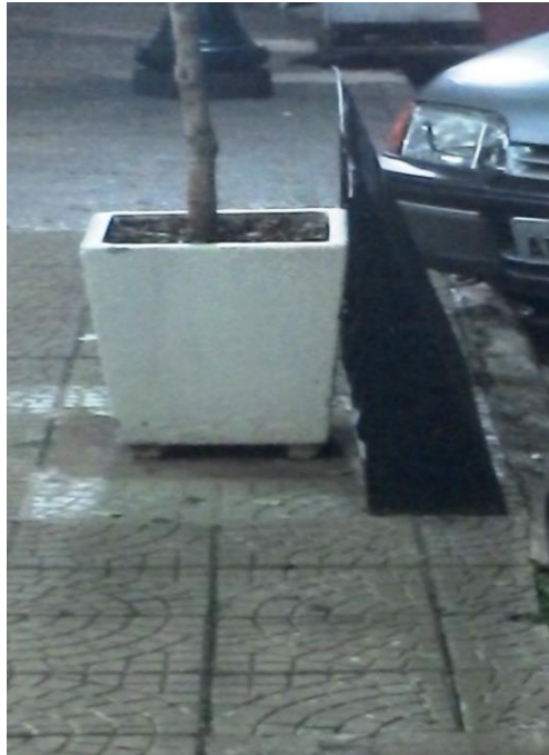
Figura 14 – Rampa móvel Fonte: Autoria própria.
