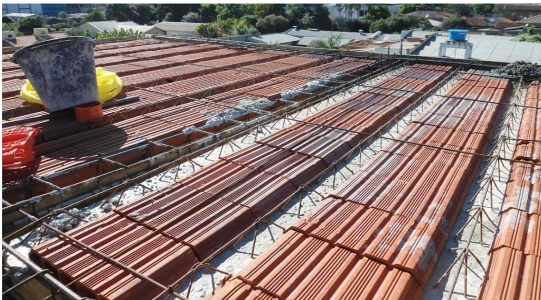
**Figura 11 - Laje com lajota cerâmica**
