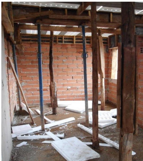
**Figura 27 - Escoramento metálico e de madeira**
