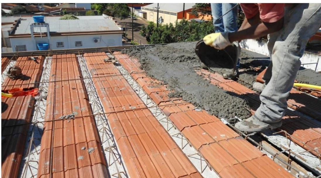
**Figura 16 - Concretagem da viga**
