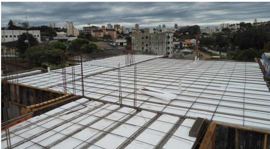
**Figura 25 - Laje treliçada com isopor/Obra D**
