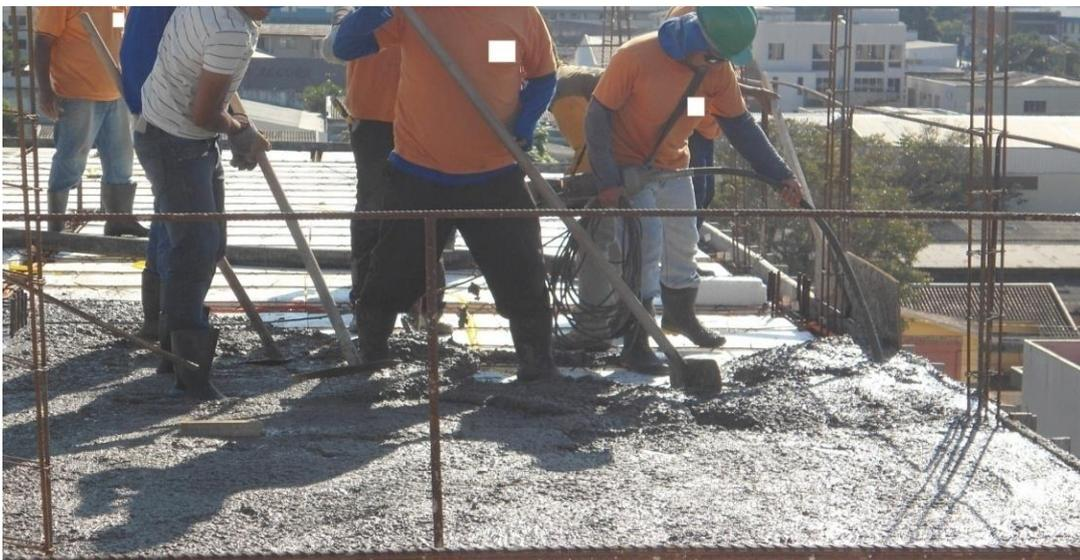
**Figura 22 – Distribuição do concreto/Obra C**
