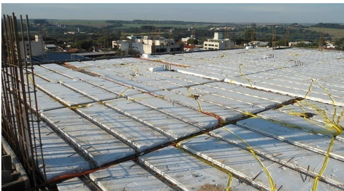
**Figura 18 - Laje treliçada com isopor/Obra C**
