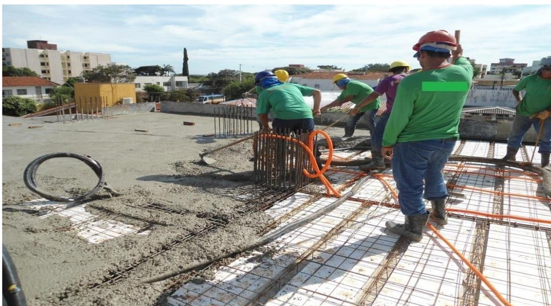
**Figura 6 – Distribuição do concreto/Obra A**
