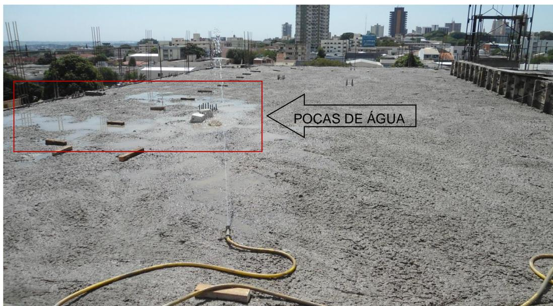
**Figura 24 - Laje concretada com poças de água**
