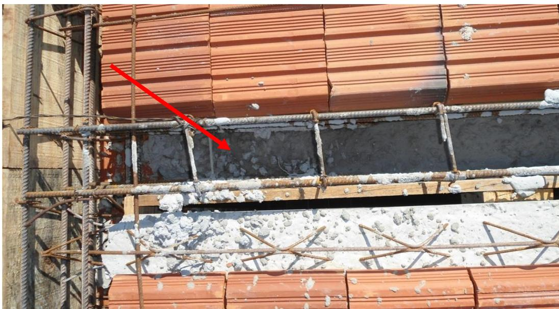
**Figura 13 - Restos de concreto na viga**
