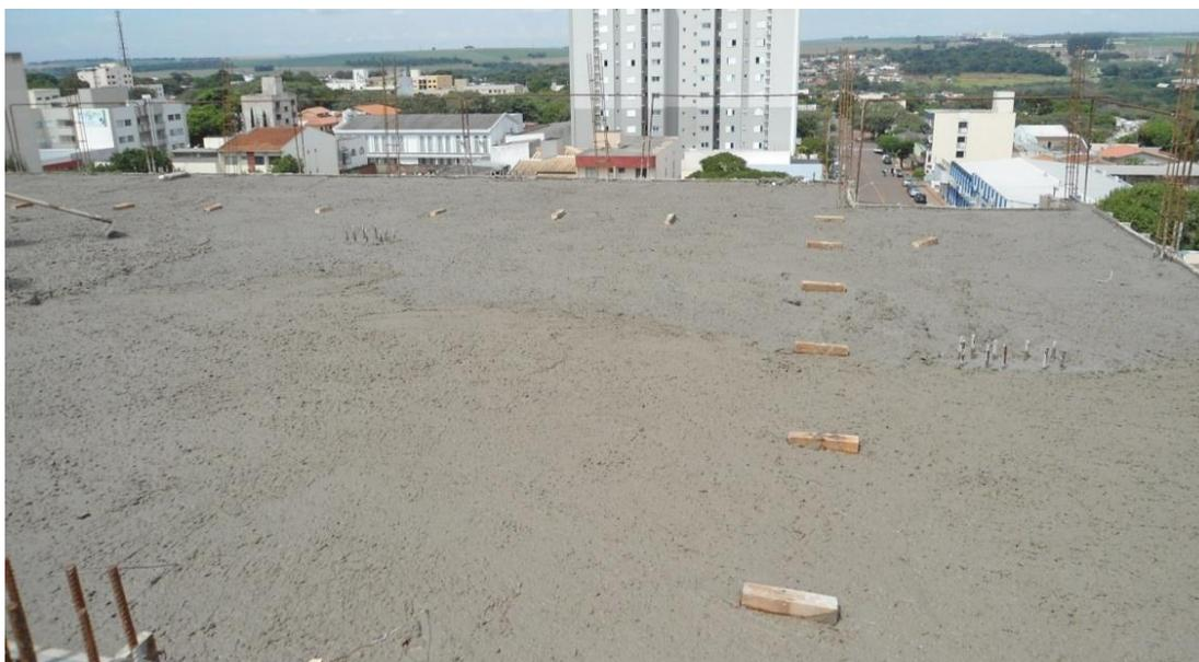
**Figura 23 - Resultado da laje concretada/Obra C**
