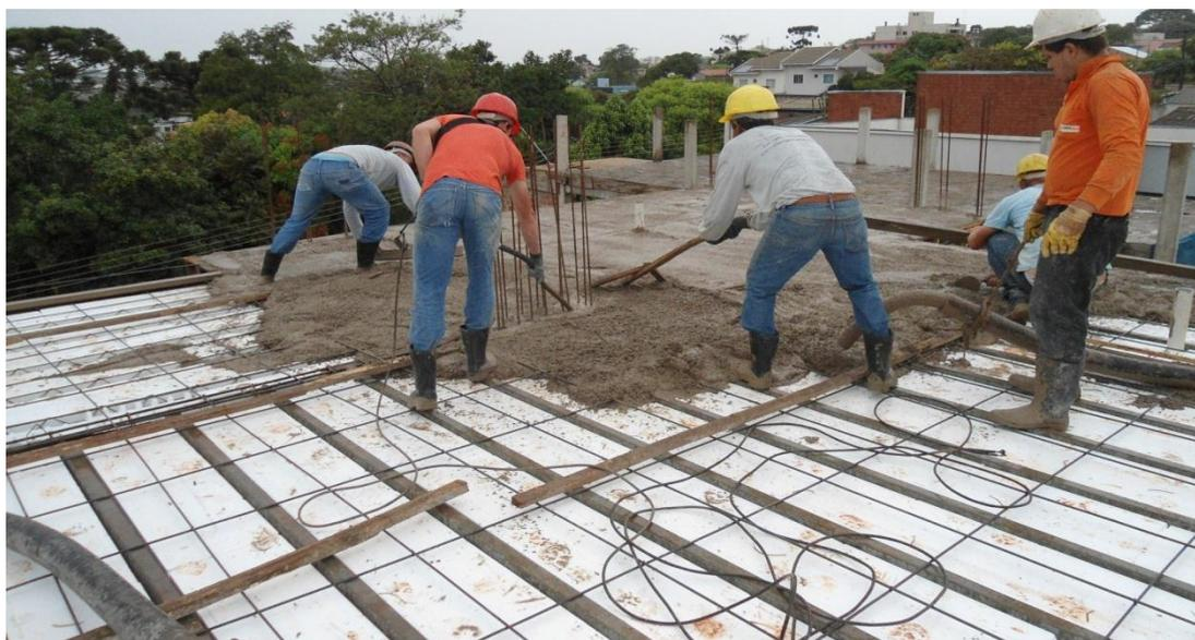
**Figura 29 - Distribuição do concreto/Obra D**
