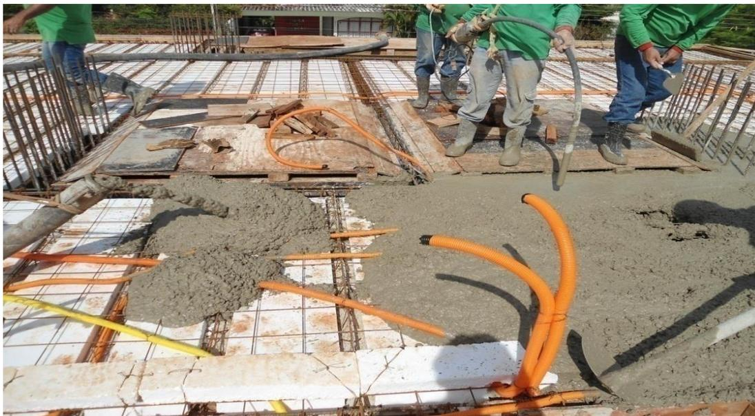
**Figura 7 - Lançamento e adensamento do concreto**
