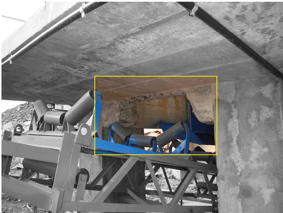
Figura 28 - Viga quebrada
