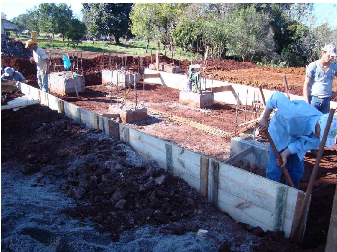
Figura 27 – Formas para o piso de 60 cm
