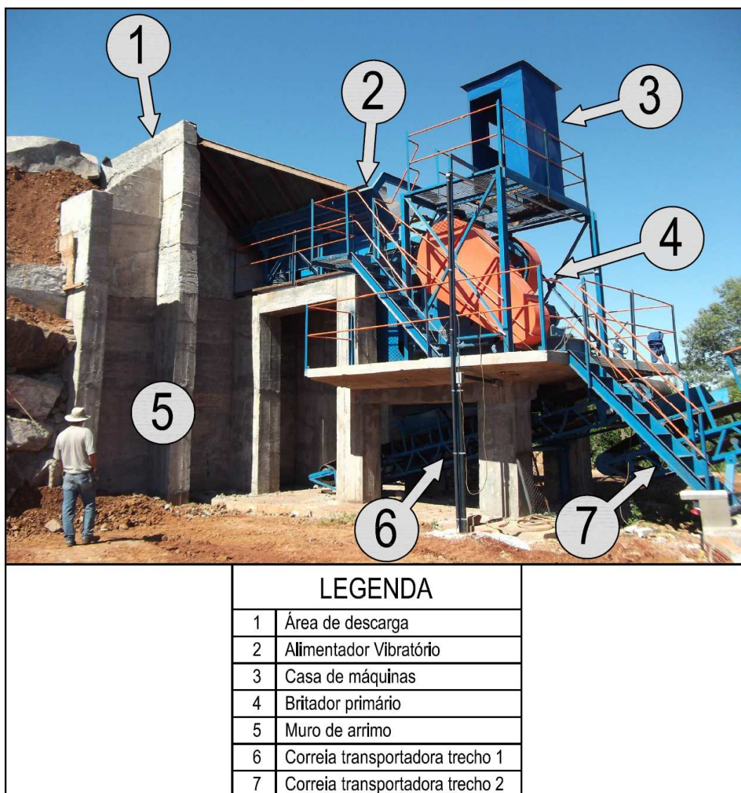
Figura 19 – Conjunto primário de britagem
