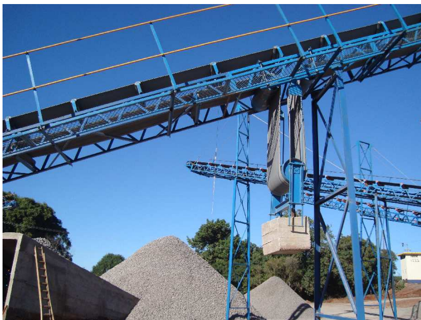
Figura 34 - Contrapeso de concreto
