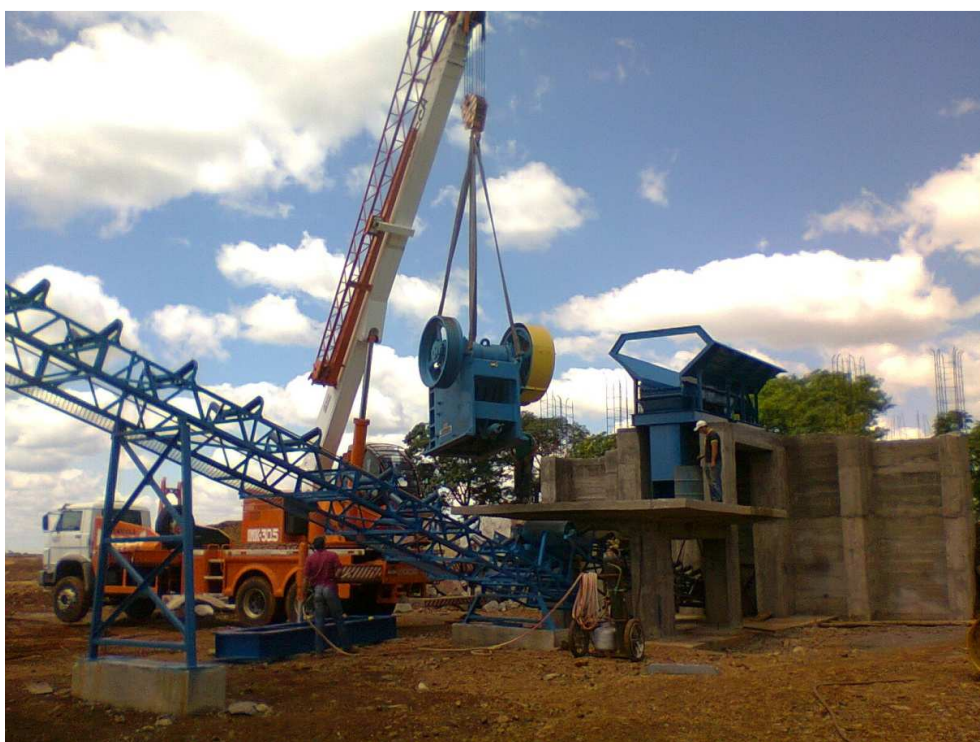
Figura 29 - Montagem do britador primário
