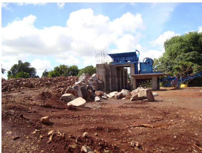
Figura 30 - Rampa e conjunto primário
