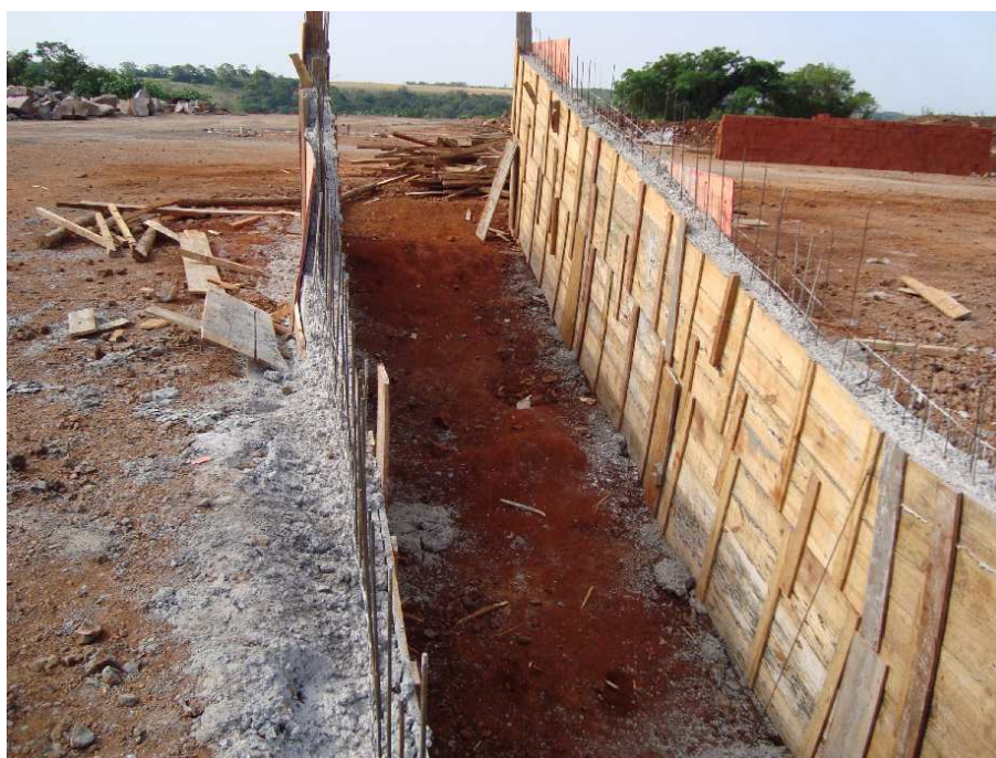
Figura 31 - Construção do pulmão
