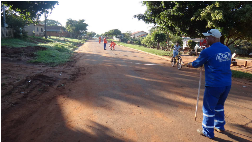
Figura 14 - Demarcação do estaqueamento
