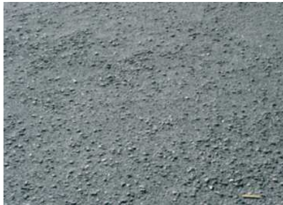
Figura 9 – Desgaste Fonte: Bernucci et al. (2006)
