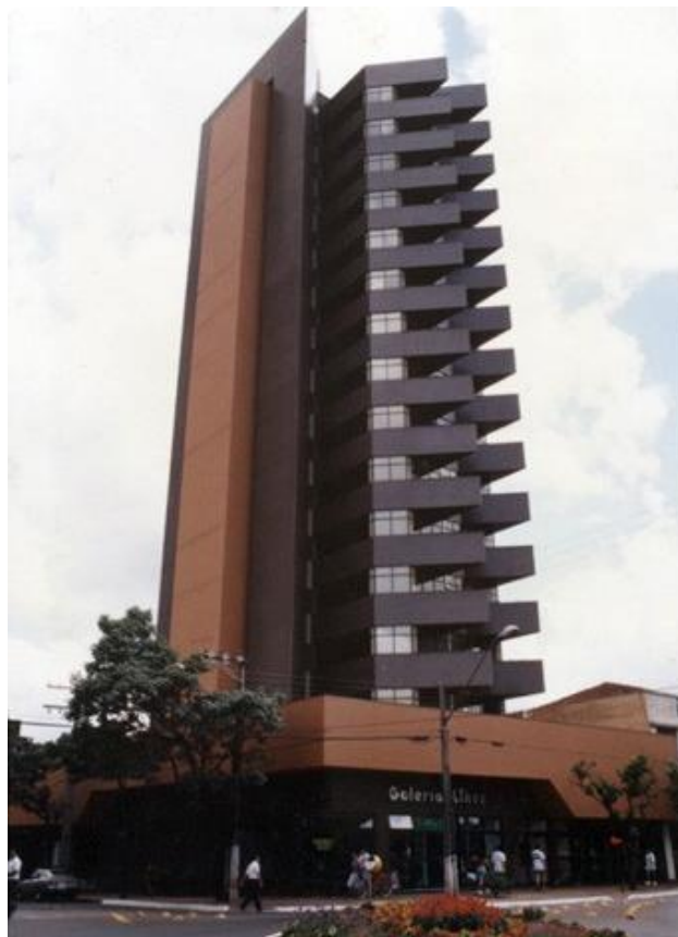
Figura 6 – Edifício Likes Fonte: Acervo Construtora Piacentini
