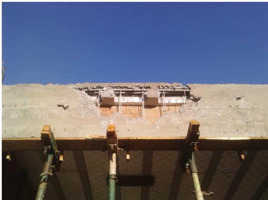
**Figura 33 - Obstrução do concreto pelos condutos de elétrica**
