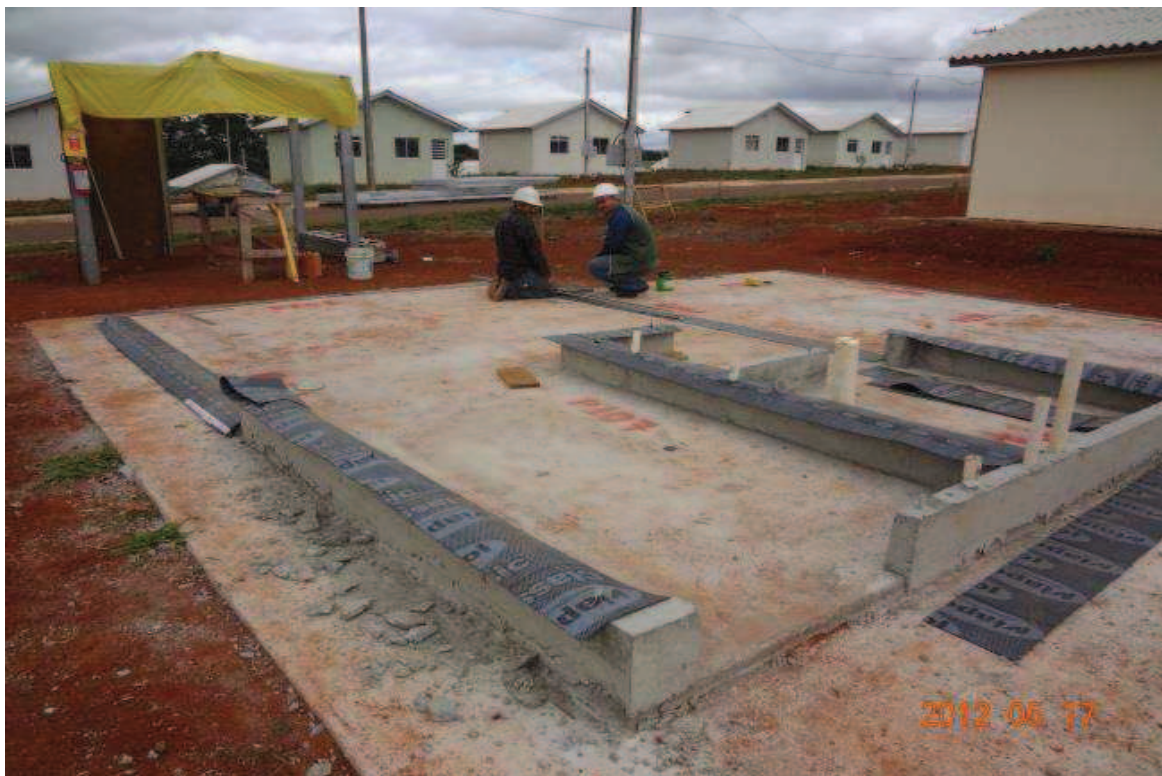
Figura 5 – Exemplo de fundação para LSF.
