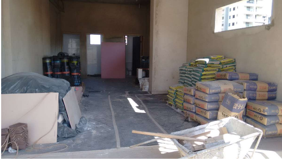
Figura 10 – Estoque de materiais de forma correta. (Obra B)
