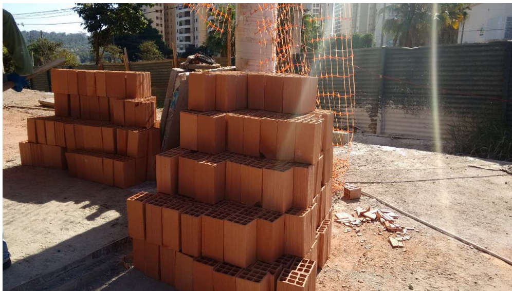
Figura 2 – Blocos cerâmicos sem paletização e proteção contra intempéries.
