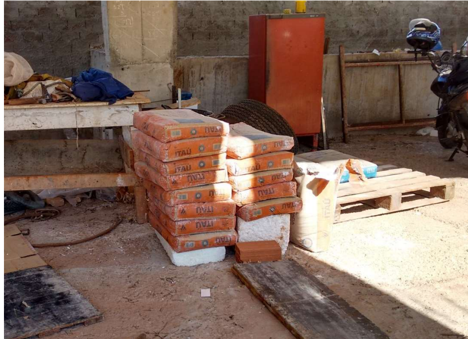
Figura 3 – Sacos de cimento e cal, protegidos do solo e intempéries.
