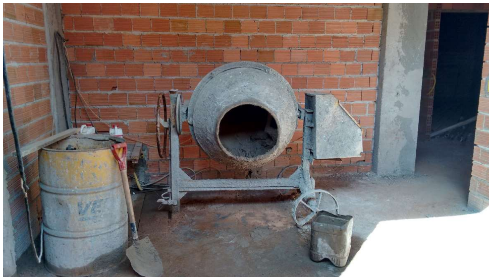
Figura 14 – Central de argamassas da obra C.
