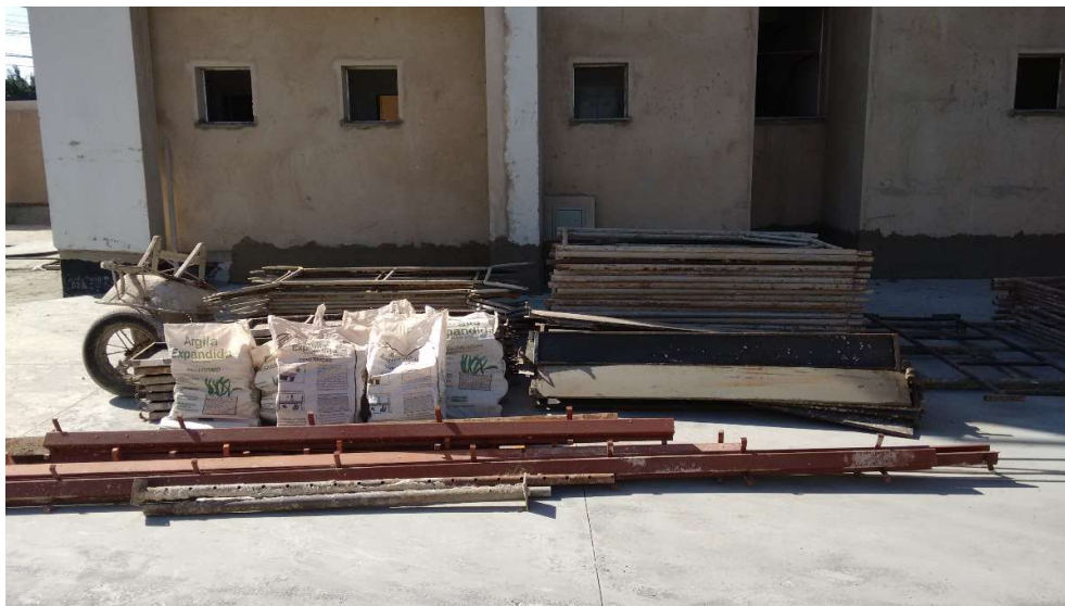
Figura 11 – Organização dos equipamentos da obra B.
