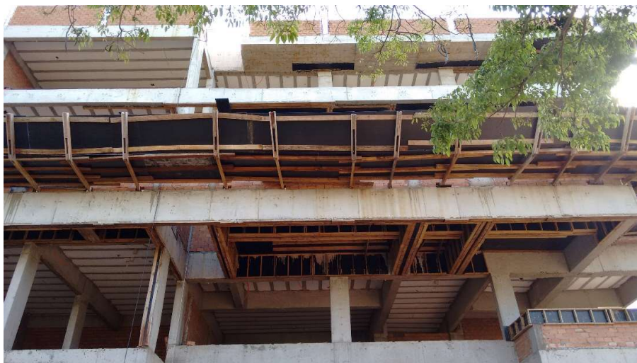
Figura 19 – Bandeja primária.
