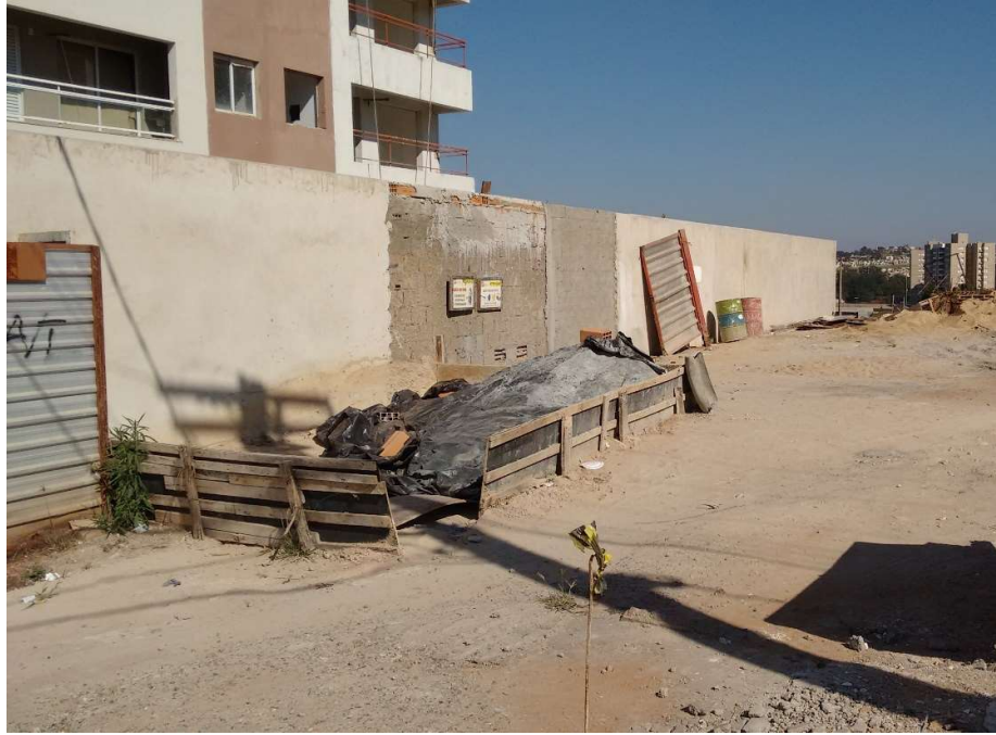
Figura 9 – Área de apoio no terreno ao lado da obra B.
