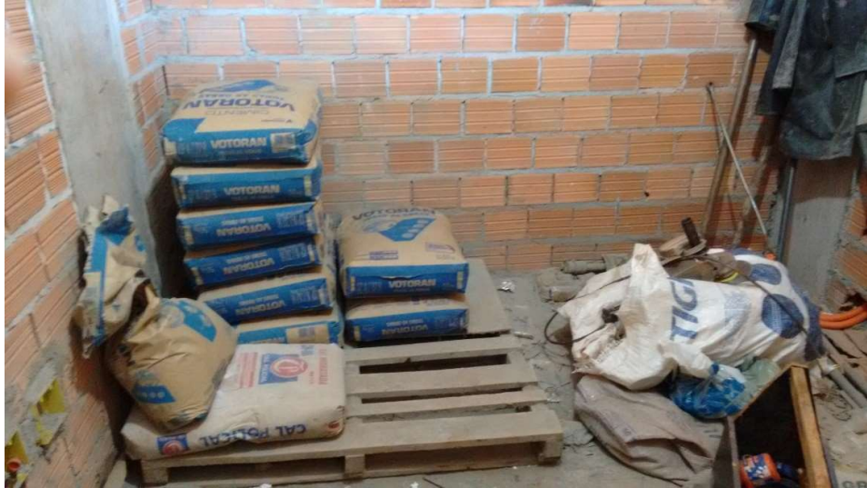
Figura 15 – Local destinado a depósito e almoxarifado. (Obra C)
