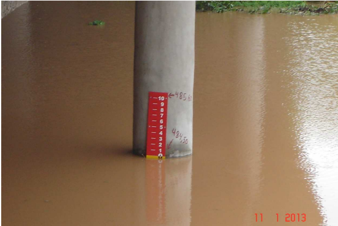
Figura 16: Nível de água registrado à véspera do escorregamento Fonte: Confidencial.
