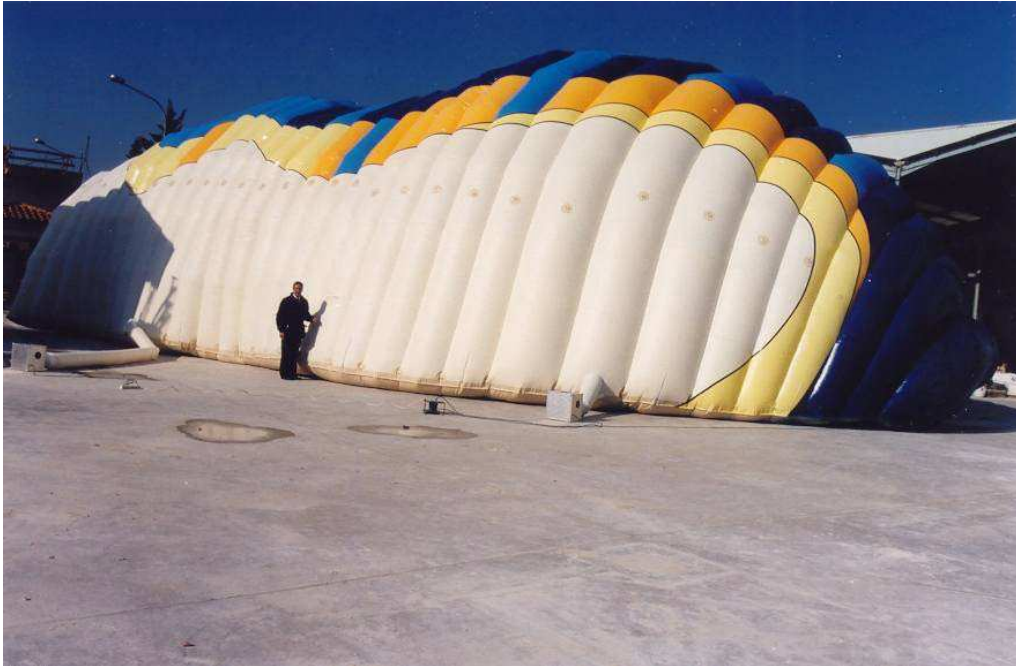
Figura 1 – Pavilhão inflável (250 m 2 ), formado por um conjunto de tubos de baixa pressão.
