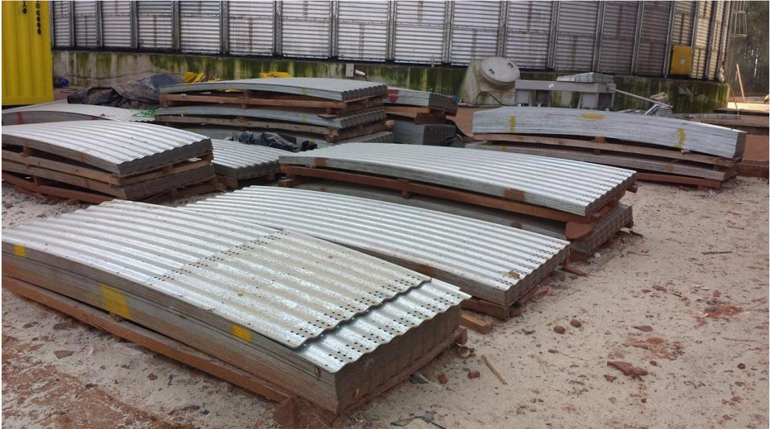
**Fotografia 6 – Limpeza das chapas do corpo do silo.**
