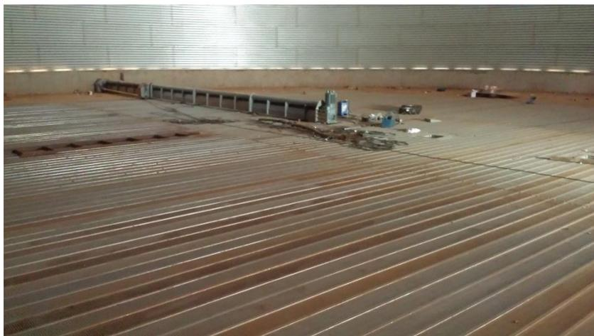
**Fotografia 20 – Chapas de aeração instaladas.**
