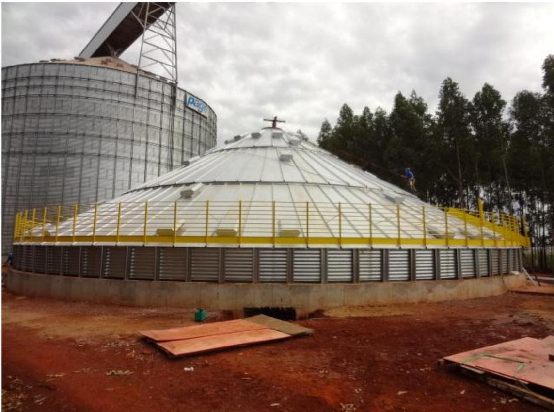
**Fotografia 14 – Cobertura e guarda corpo do telhado.**
