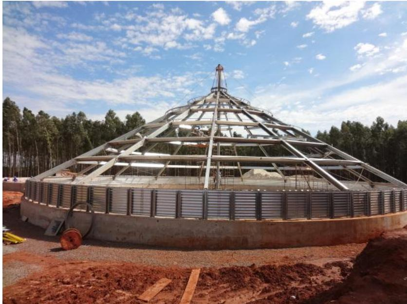
**Fotografia 12 – Estrutura do telhado do silo 9022.**
