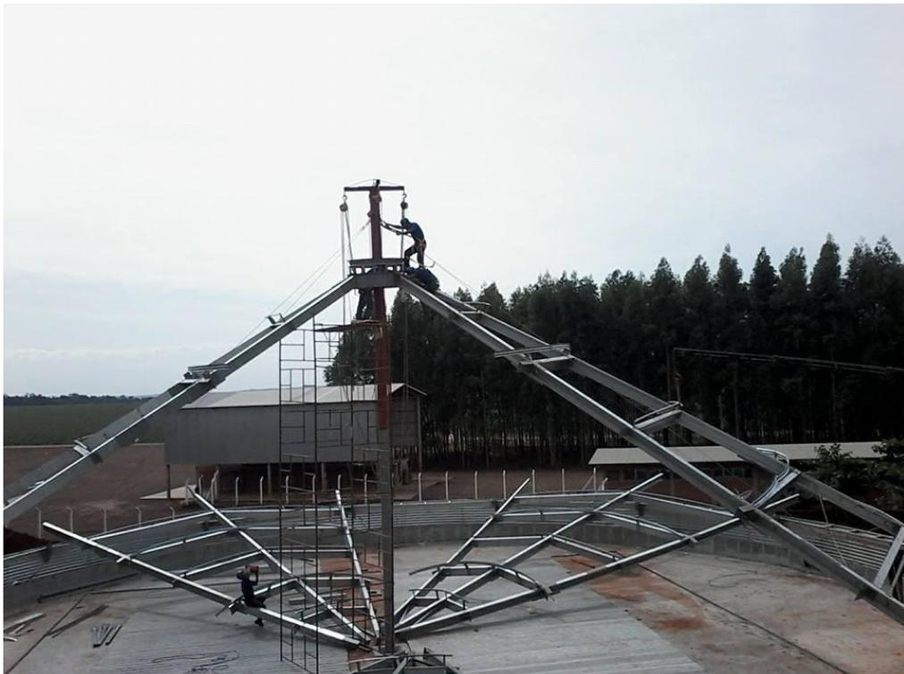
**Fotografia 11 – Fixação das longarinas ao colar central.**
