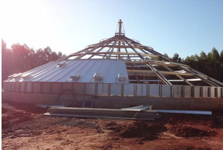
**Fotografia 13 – Início da cobertura da estrutura do telhado.**
