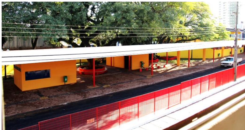
Figura 45 – Terminal após reforma. Fonte: Prefeitura (2012).
