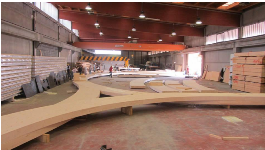
Figura 62 - Pré-Montagem do pórtico com 50m de vão livre
