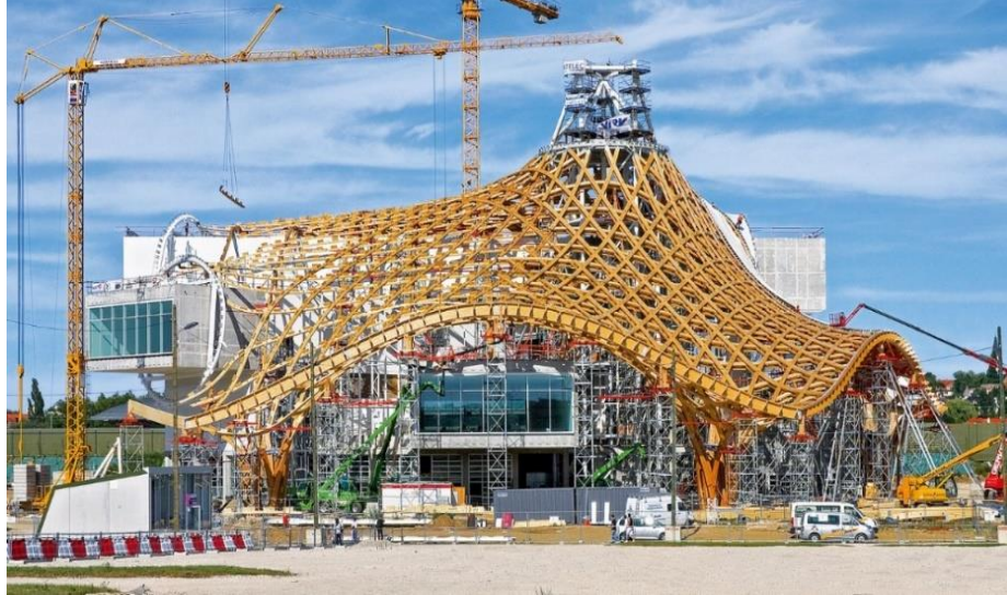
Figura 9 - Montagem estrutura MLC Fonte: ASSENOTEC (2012)
