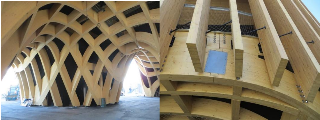
Figura 13 - Pisos e fachadas do pavilhão Fonte: Novoambiente (2014)
