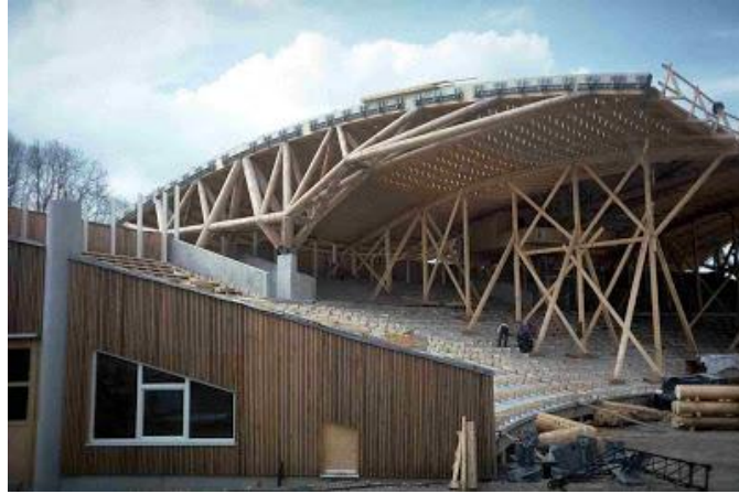
Figura 24 - Cobertura autoportante Fonte: Blog Estruturas de Madeira (2009)
