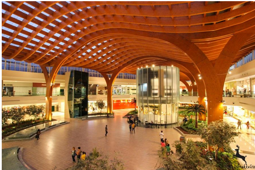
Figura 66 - Cobertura de madeira Shopping Iguatemi Fonte: Carpintería (2015)
