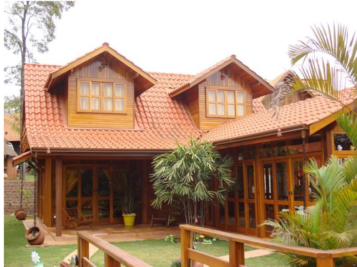
Figura 48 - Estrutura pilar-viga com vedação em vidro Fonte: http://www.arquiteturadamadeira.com.br/ (2013)
