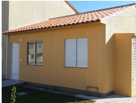
Figura 55 - Habitação social em wood frame Fonte: http://construcaomercado.pini.com.br/ (2013)
