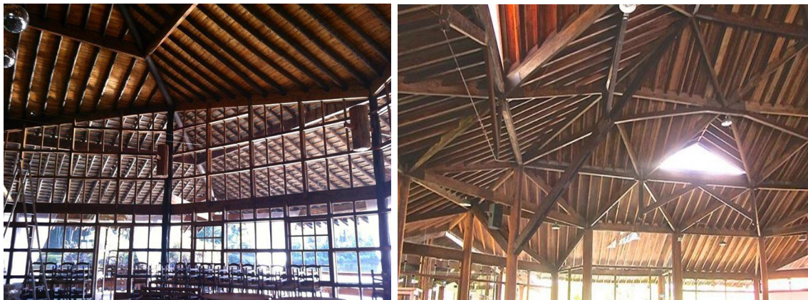
Figura 71 - Galpão – madeira nativa e reflorestada Fonte: Blog Estruturas de Madeira (2015)
