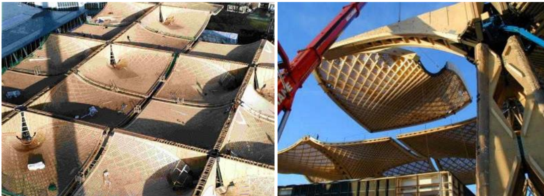
Figura 23 - Conchas da cobertura do pavilhão Fonte: Blog Estruturas de Madeira (2009)
