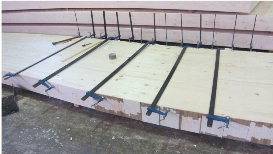
Figura 60 - Correção de falhas Fonte: Carpinteria (2014)
