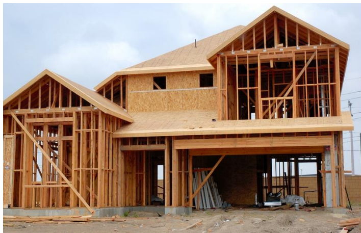
Figura 50 - Exemplo estrutura wood frame
