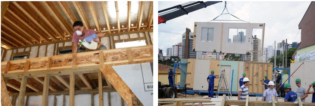
Figura 53 - Montagem da obra Fonte: http://construcaomercado.pini.com.br/ (2013)
