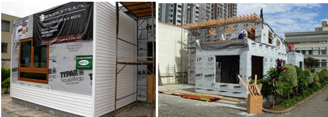
Figura 56 - Montagem da obra / Construção enxuta Fonte: http://www.escriptorioverdeonline.com.br/ (2012)
