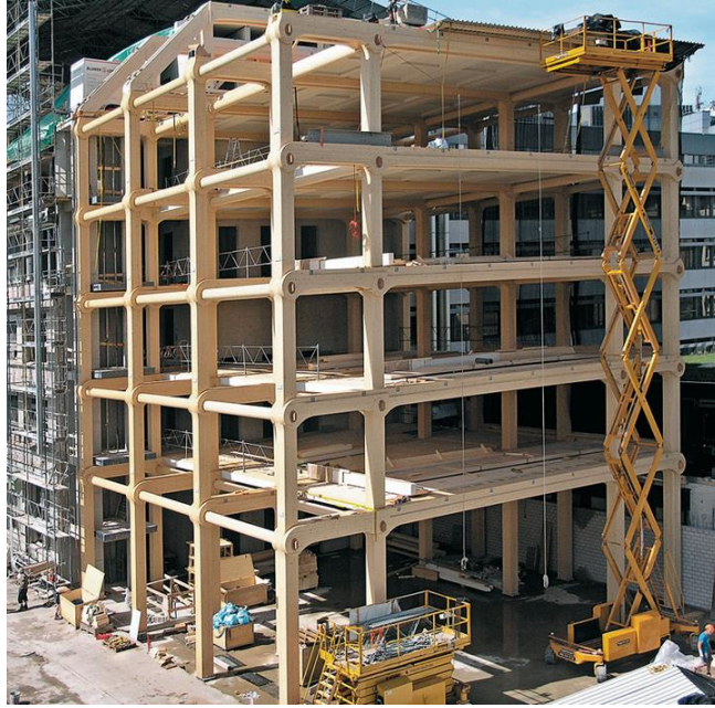
Figura 17 - Execução superestrutura do Tamedia Office Building Fonte: http://www.shigerubanarchitects.com/ (2014)
