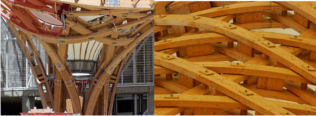
Figura 11 - Malha de treliças em MLC. Fonte: ASSENOTEC (2012)
