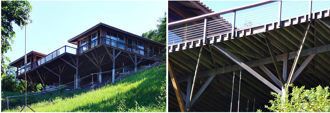
Figura 75 - Casa Zarvos – madeira nativa Fonte: Blog Estruturas de Madeira (2015)
