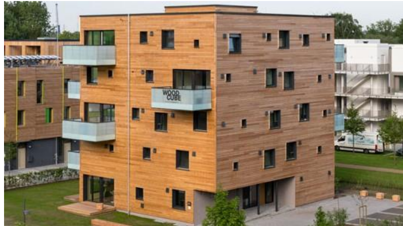
Figura 19 - Edifício de 5 pavimentos Fonte: http://www.mnn.com/ (2013)
