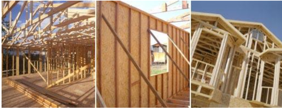
Figura 51 - Montantes de madeira e chapas OSB
