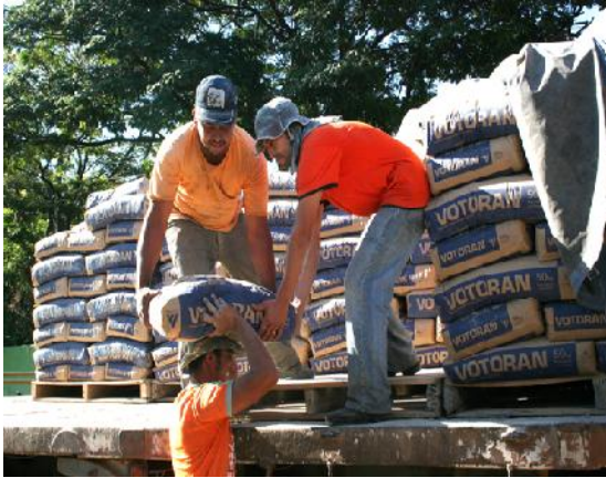
Figura 5 - Transporte de materiais Fonte: Ministério Público do Trabalho, (2014).
