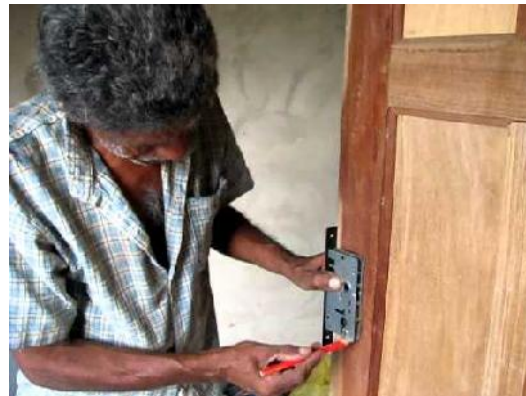
Figura 18 - Fixação de fechadura Fonte: Júlio, (2013).
