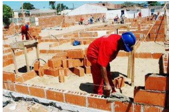
Figura 39 - Construção de edificação Fonte: Portal da Paulínia, (2012).
