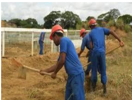
Figura 3 - Limpeza do terreno Fonte: APLs de Pernambuco, (2010).
