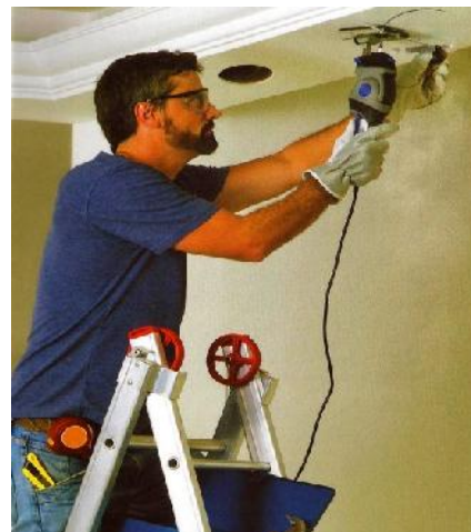
Figura 24 - Instalação de luminária Fonte: Bosch, (2013).
