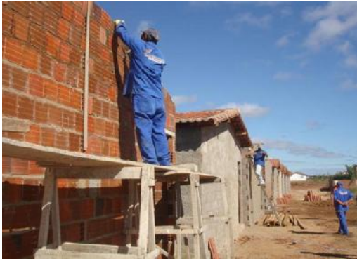
Figura 36 - Construção de alvenaria Fonte: Joli, (2011).
