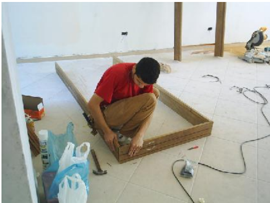
Figura 19 - Montagem de batente Fonte: Faz fácil, (2014).
