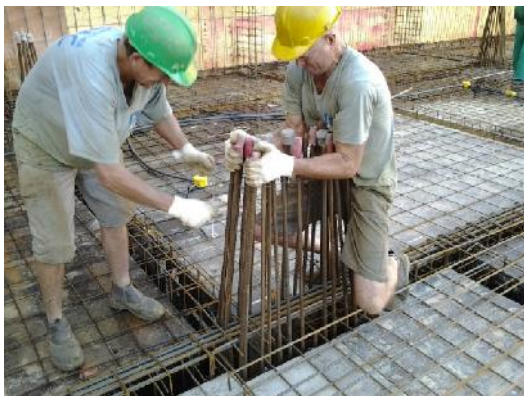
Figura 12 - Amarração de armadura Fonte: Fernandes, (2012).
