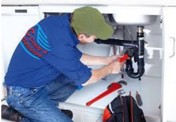
Figura 27 - Instalação hidráulica Fonte: Eletrodeca, (2014).
