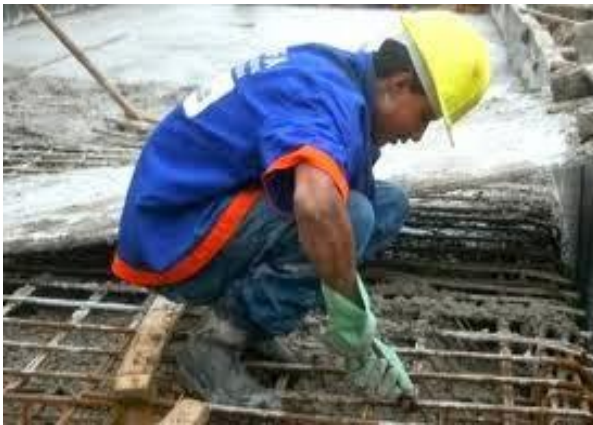
Figura 10 - Verificação da armadura Fonte: ALEC Associação de locadoras, (2013).
