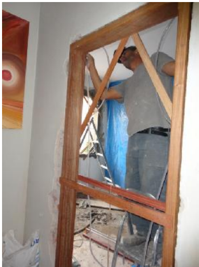
Figura 17 - Instalação de batente Fonte: Sales, (2011).
