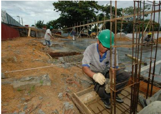
Figura 8 - Colocação de estribos Fonte: Santos, (2012).
