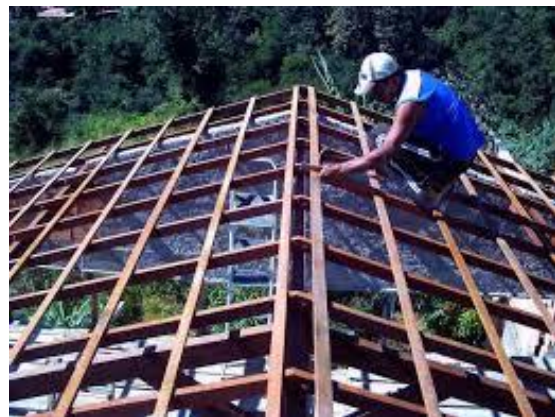
Figura 22 - Construção do telhado Fonte: Santos, (2012).
