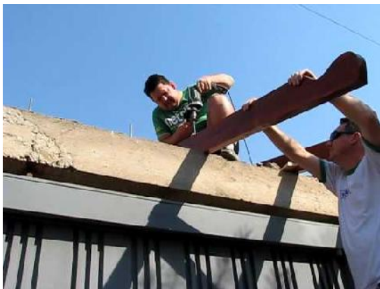
Figura 21 - Fixação de viga do telhado Fonte: Couto, (2011).
