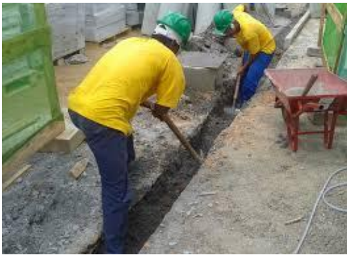
Figura 7 - Escavação de vala Fonte: Monteiro Sales engenharia, (2013).
