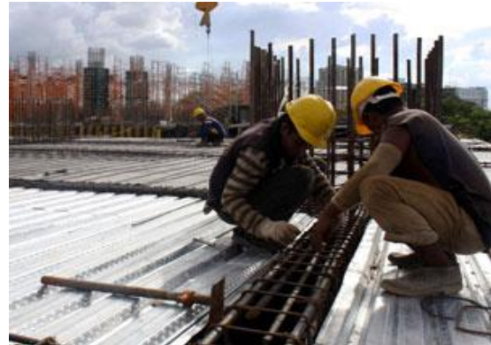
Figura 9 - Colocação da armadura Fonte: Semdesu, (2012).
