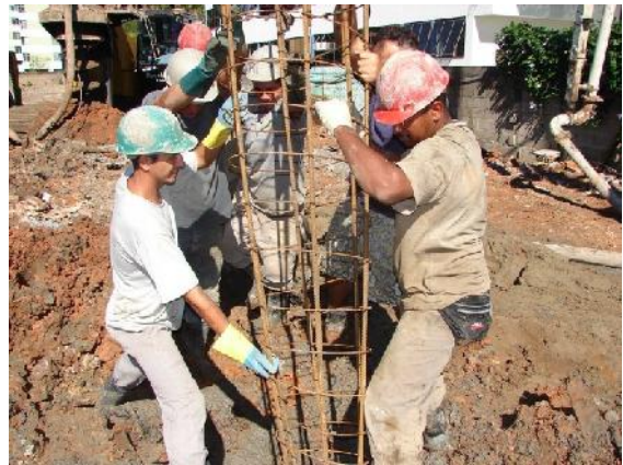
Figura 11 - Colocação de armadura Fonte: Ramos, Zanin e Barzotto, (2008).
