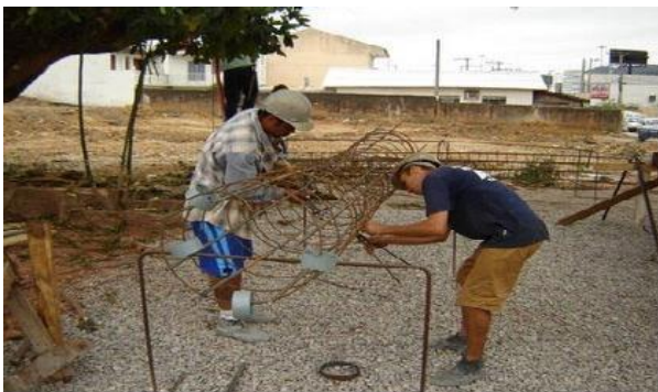
Figura 14 - Montagem de vergalhões Fonte: Zandavalli, Striani e Pinto, (2008).
