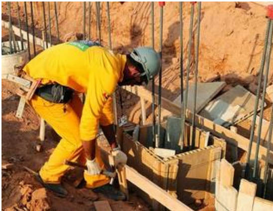
Figura 15 - Montagem de formas Fonte: Simonini, (2011).
