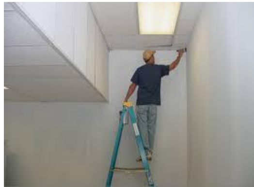
Figura 41 - Pintura de parede Fonte: JN Pintura e reforma, (2014).
