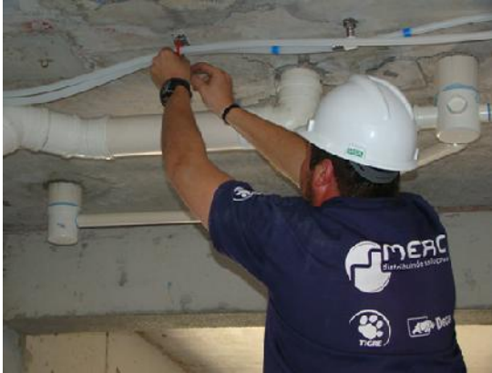
Figura 29 - Instalação hidráulica em lajes Fonte: AEC Web, (2013).
