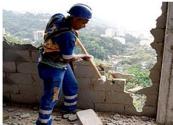
Figura 2 - Demolição de parede Fonte: Demolidora & Demolições, (2013).
