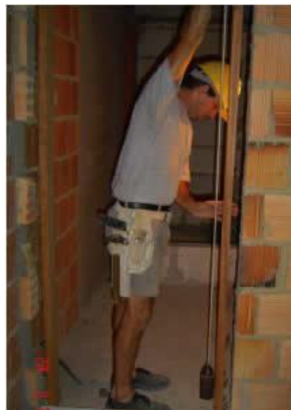
Figura 20 – Regularização de esquadria Fonte: WLM Instalações de portas, (2014).
