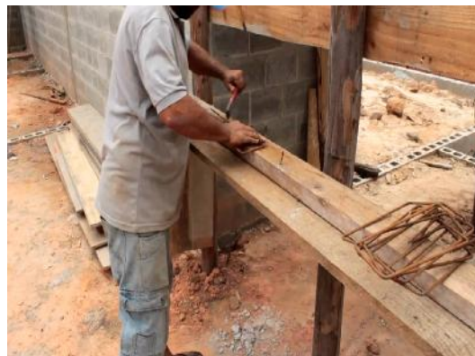
Figura 13 - Dobra de vergalhões Fonte: FabioConstroi, (2010).
