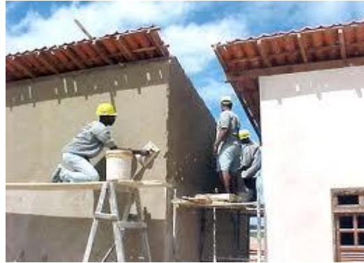
Figura 35 - Aplicação de reboco em parede Fonte: Senai, (2014).
