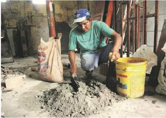
Figura 34 – Fabricação de argamassa Fonte: Melo, (2013).
