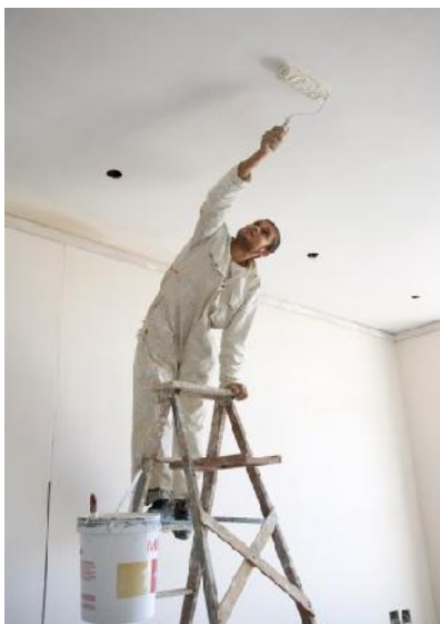
Figura 42 - Pintura do teto Construindo a dois, (2014).
