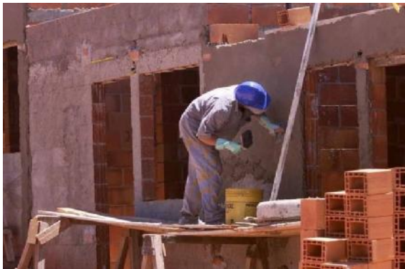
Figura 38 – Regularização do reboco Fonte: Junior, (2014).
