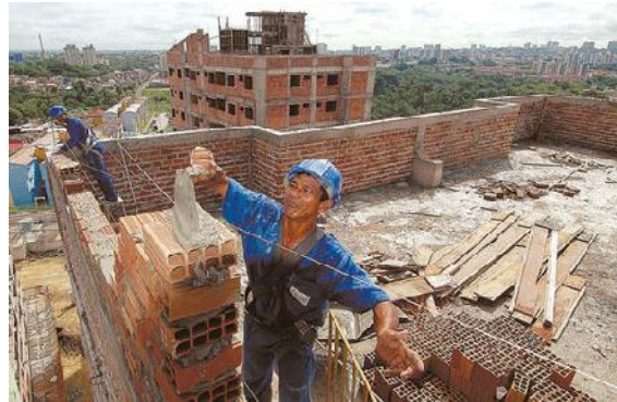
Figura 37 - Assentamento de tijolos Fonte: ACritica.com, (2012).
