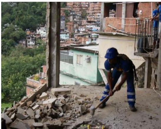
Figura 1 - Demolição Fonte: ASCOM da SEOP, (2010).
