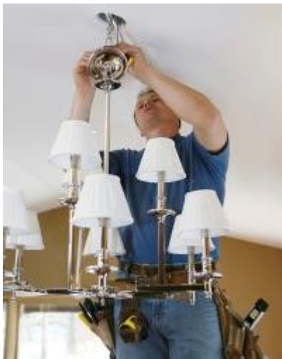
Figura 25 - Manutenção de luminária Fonte: Eletricista BR, (2014).
