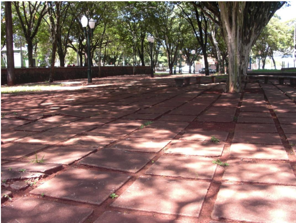
Fotografia 2: Atual situação das calçadas da praça. Fonte: Do autor
