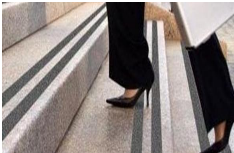
Figura 17 – Sinalização visual para escadas e degraus.
