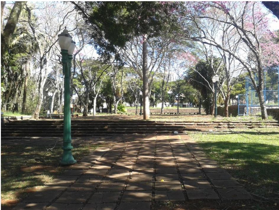
Fotografia 12: Ausência de corrimãos e rampa na escada 5. Fonte: Do autor
