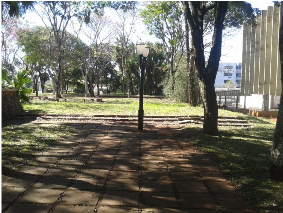
Fotografia 10: Ausência de corrimãos e rampa na escada 3. Fonte: Do autor
