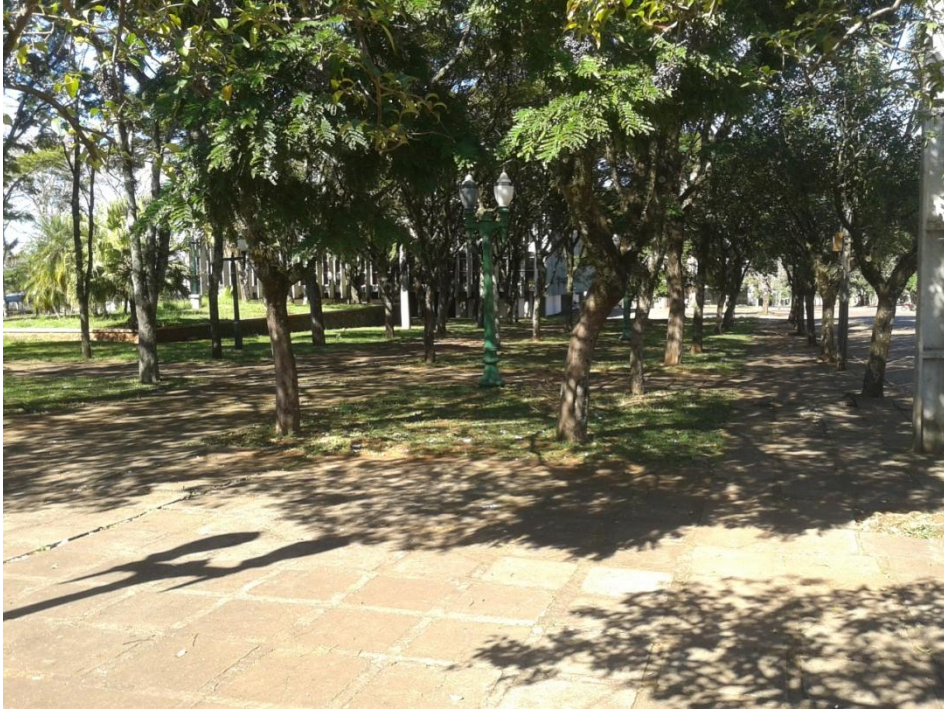
Fotografia 6: Ausência de piso tátil nas calçadas de acesso à praça. Fonte: Do autor
