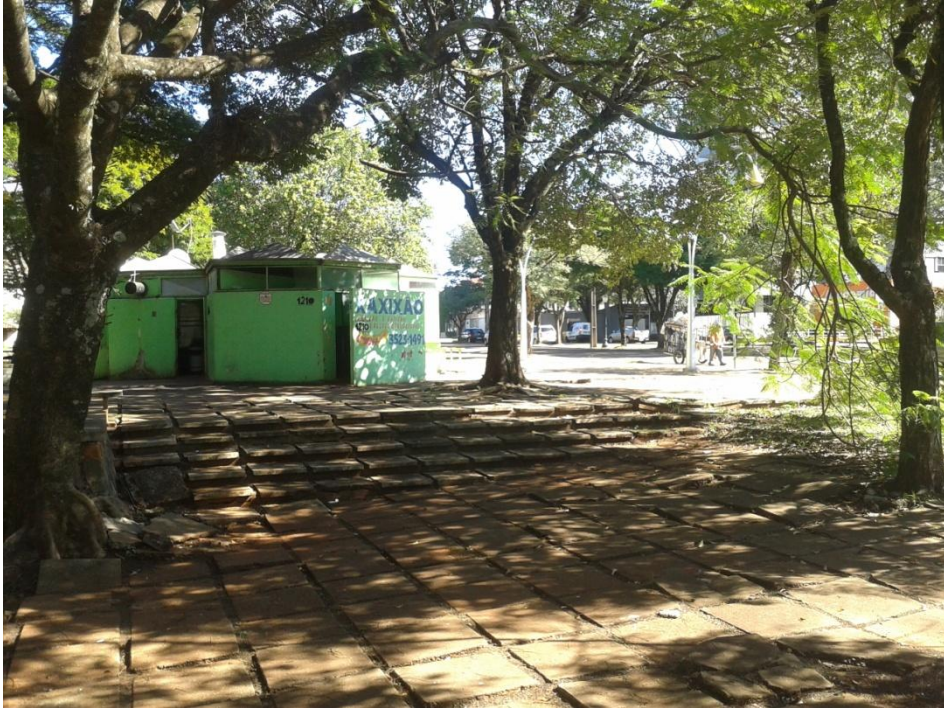
Fotografia 13: Ausência de corrimãos e rampa na escada 6. Fonte: Do autor
