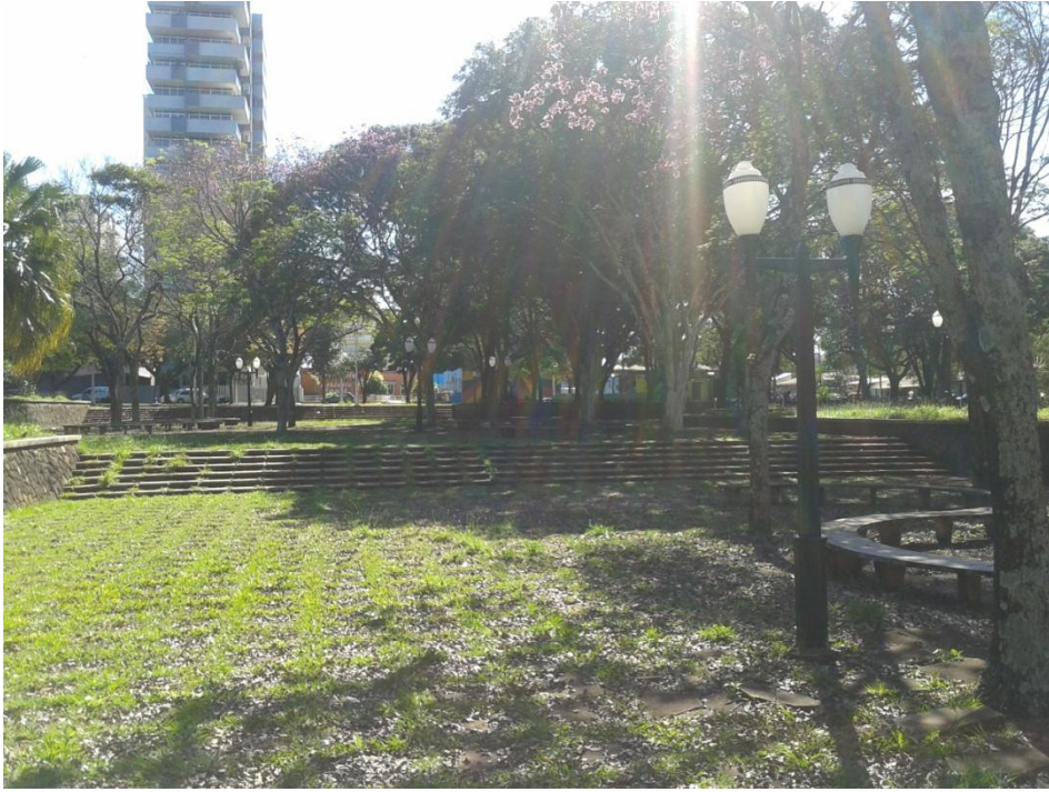
Fotografia 9: Ausência de corrimãos e rampa na escada 2. Fonte: Do autor
