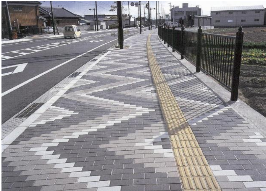
Figura 14 – Implantação de piso tátil junto ao piso intertravado. Fonte: Rhino Pisos, 2014
