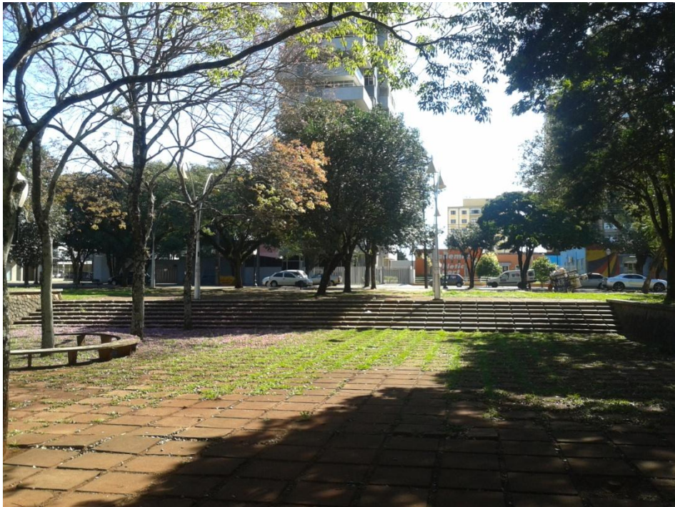
Fotografia 8: Ausência de corrimãos e rampa na escada 1. Fonte: Do autor
