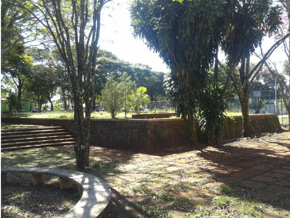
Fotografia 16: Ausência de proteção ou guarda-corpo no canteiro elevado 3. Fonte: Do autor
