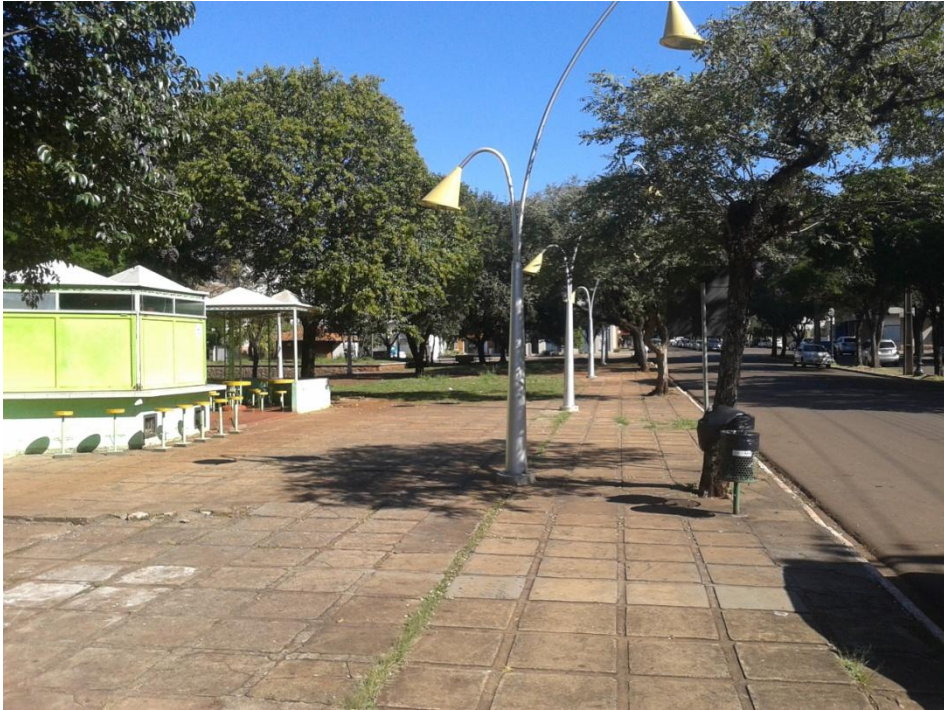
Fotografia 4: Ausência de piso tátil nas calçadas de acesso à praça. Fonte: Do autor
