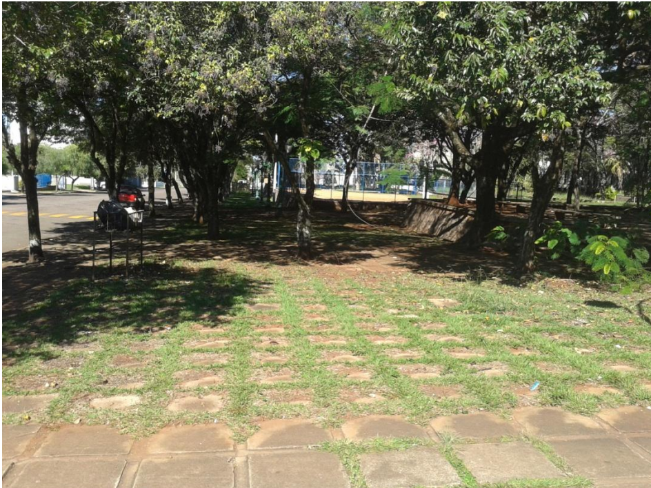
Fotografia 5: Ausência de piso tátil nas calçadas de acesso à praça. Fonte: Do autor
