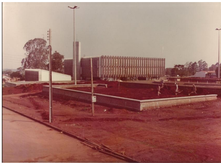
Figura 12: Praça Bento Munhoz da Rocha Netto em construção Fonte: Museu Municipal de Campo Mourão – PR, 2014
