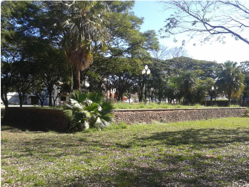
Fotografia 15: Ausência de proteção ou guarda-corpo no canteiro elevado 2. Fonte: Do autor
