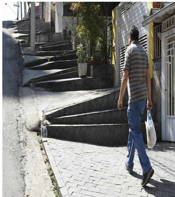
Figura 13- Pedestre enfrenta calçada íngreme com degraus irregulares. Fonte: Luiz Carlos Murauskas(2011)
