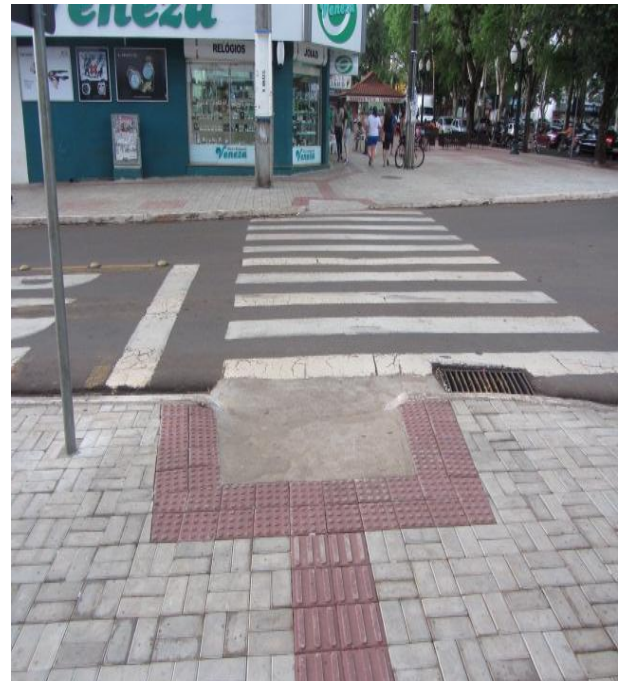
Figura 42- Rampa conforme Fonte: autor(2014)
