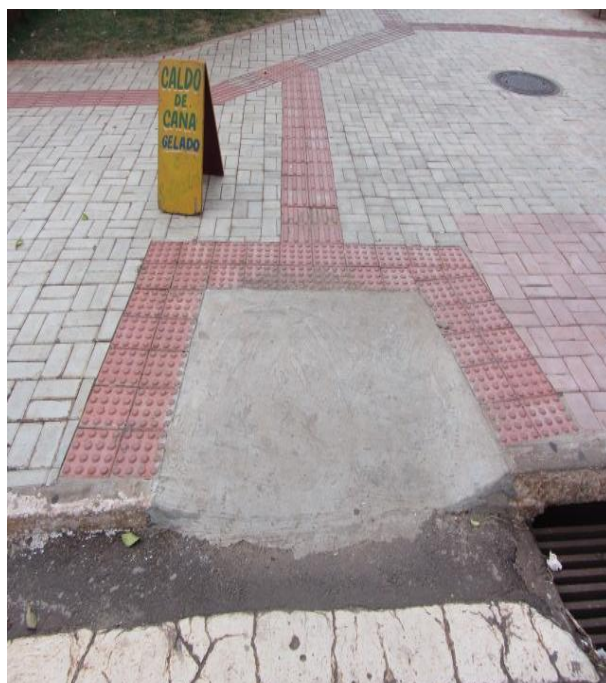
Figura 36- Rampa conforme Fonte: autor(2014)
