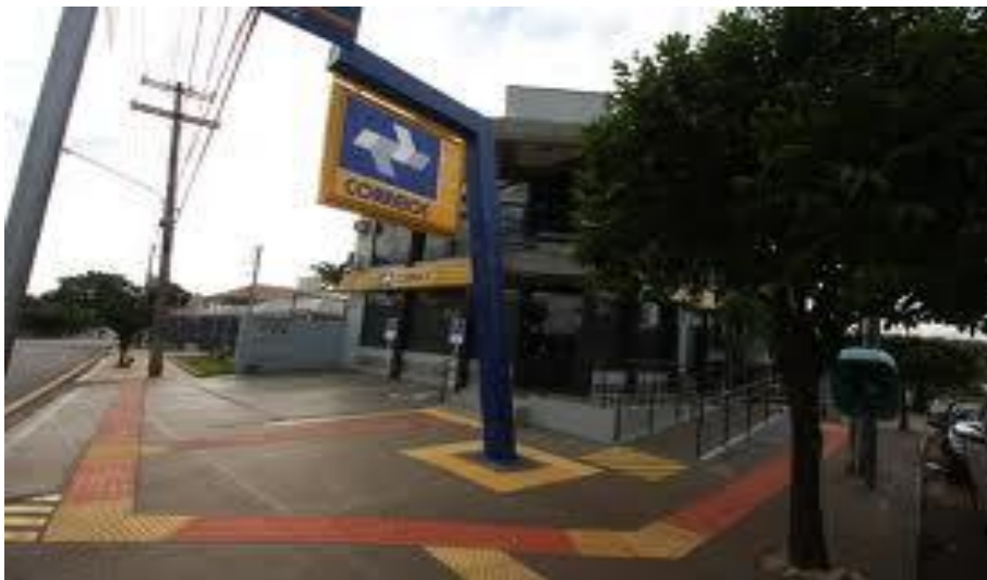
Figura 4 – Calçada em boas condições de tráfego Fonte: Frederico Rios(2011)
