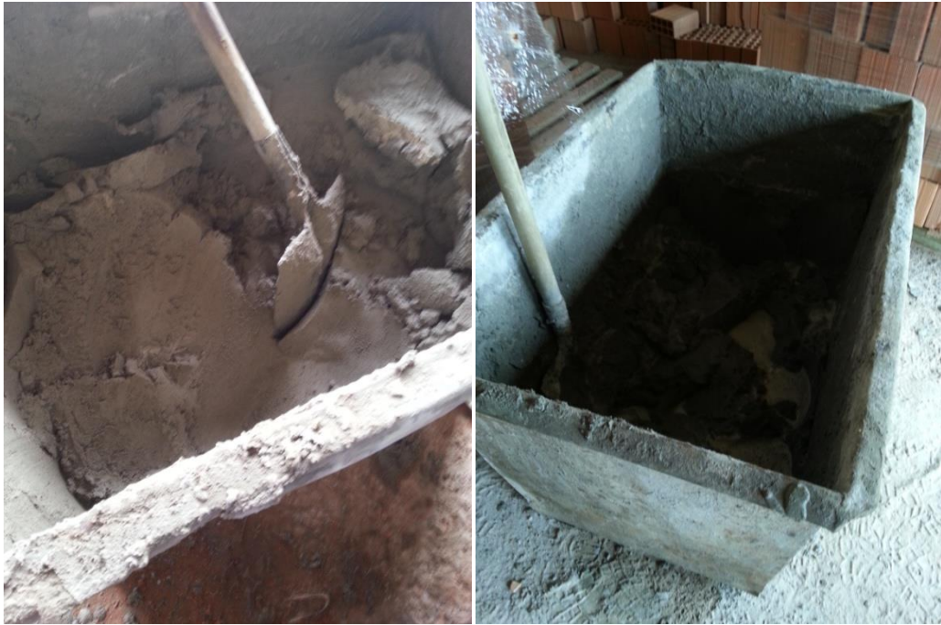
Figuras 32 e 33 – Argamassa estabilizada Fonte: Autoria própria.
