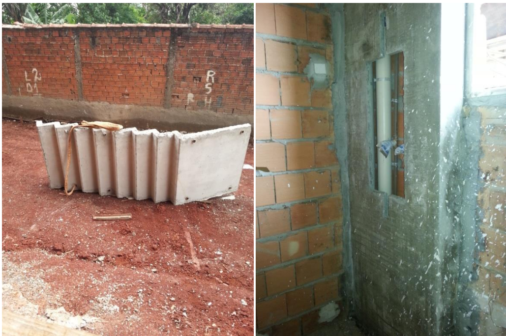
Figuras 17 e 18 – Pré-moldados evidenciados na obra. Fonte: Autoria própria.
