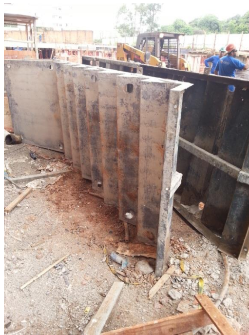
Figura14 – Forma metálica de escada Fonte: Autoria própria.
