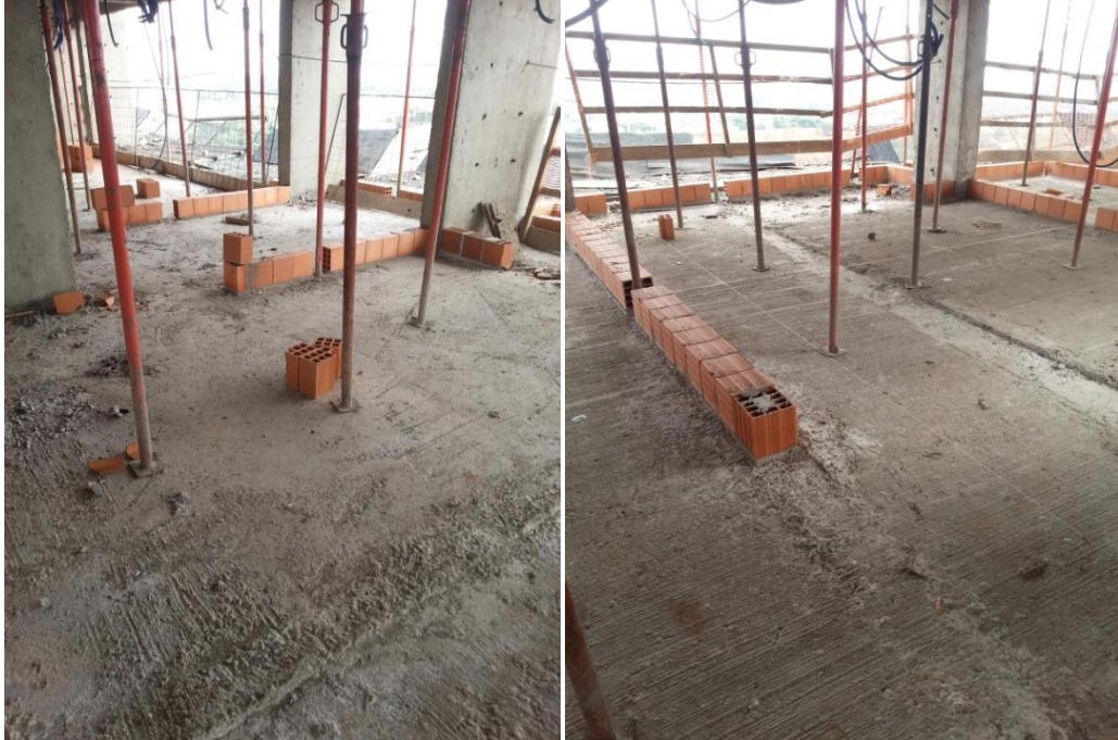
Figuras 12 e 13 – Assentamentos das primeiras fiadas Fonte: Autoria própria.
