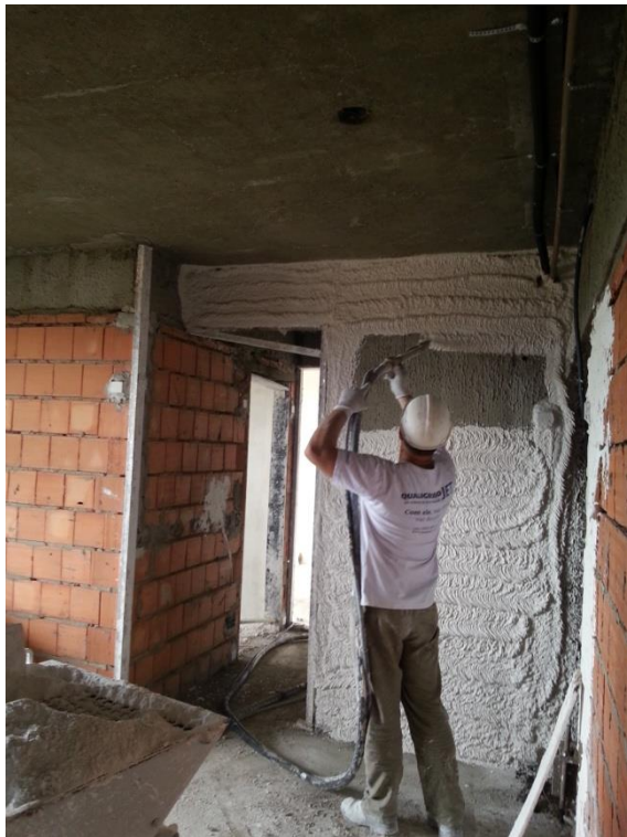
Figura 27 – Gesso projetado. Fonte: Autoria própria.
