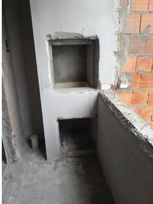
Figura 19 – Pré-moldado evidenciado na obra Fonte: Autoria própria.
