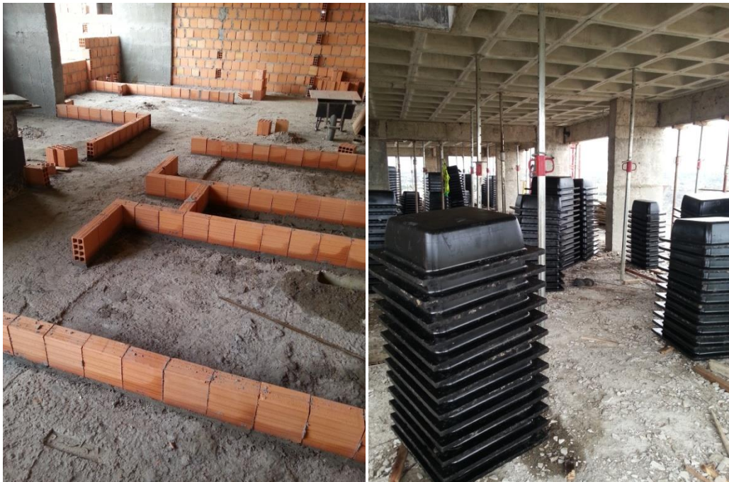
Figuras 37 e 38 – preparação da primeira fiada e lajes nervuradas Fonte: Autoria própria.
